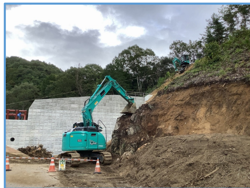
砂防堰堤左岸下流の法面掘削状況
