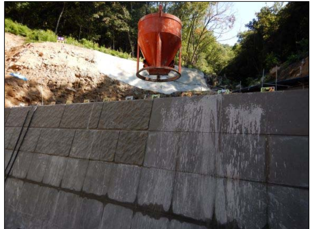
コンクリート打設状況②
