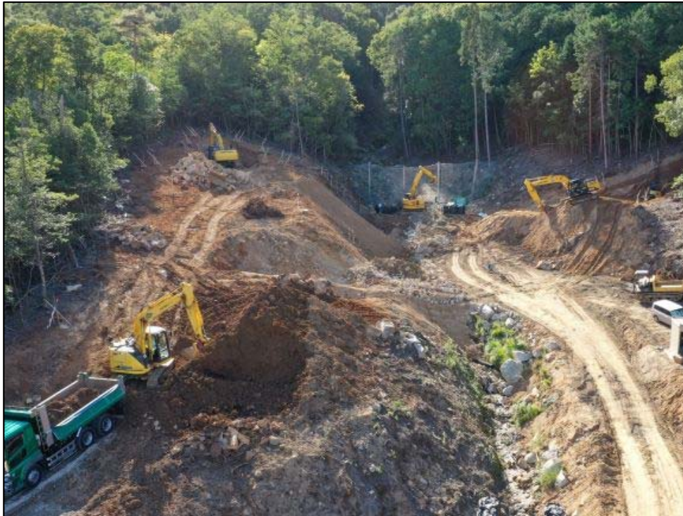
掘削作業状況
