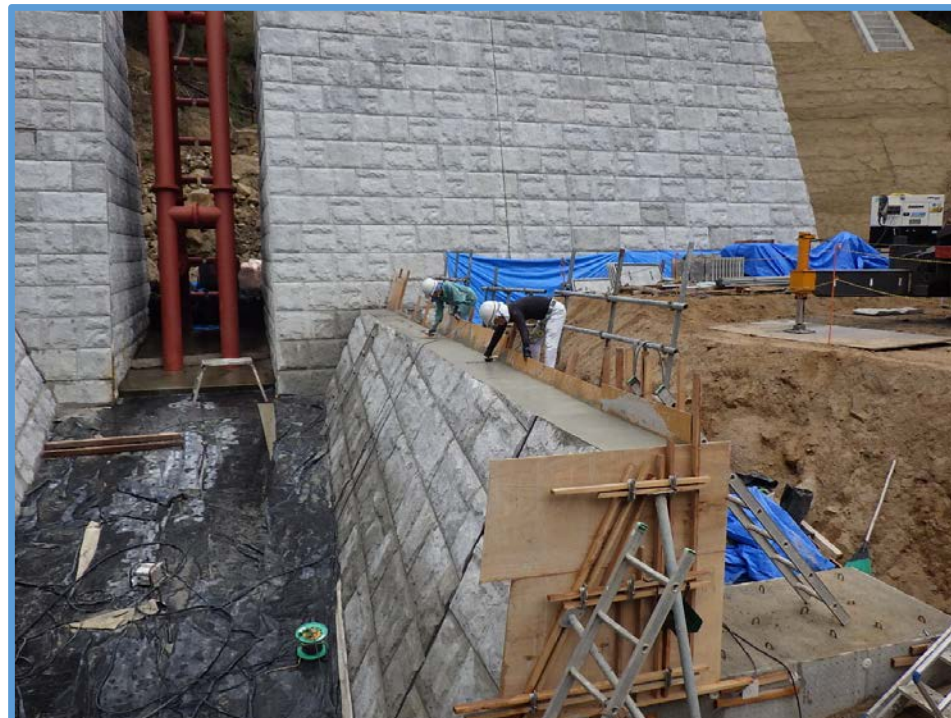
前庭保護工（側壁）のコンクリート打設状況
