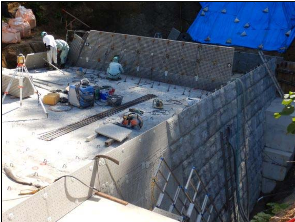
型枠施工状況
