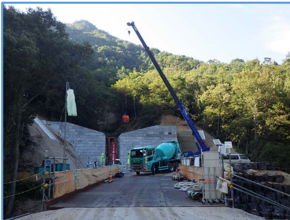
前庭保護工（側壁）のコンクリート打設状況
