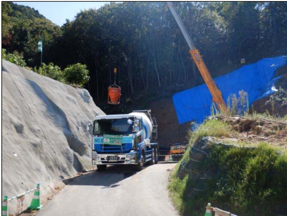
コンクリート打設状況①
