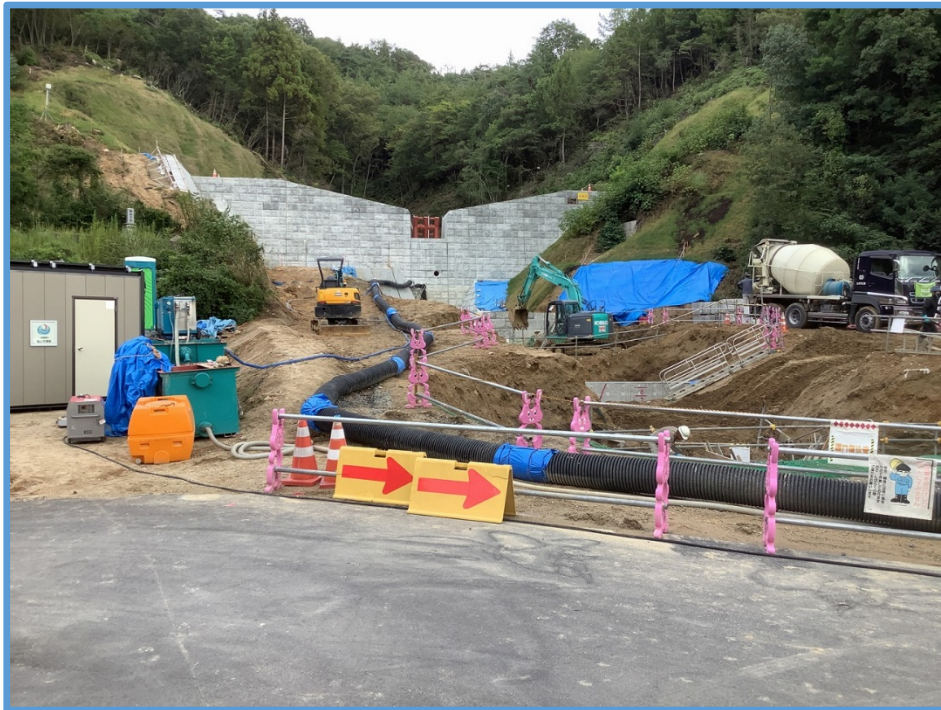
床止の施工状況
