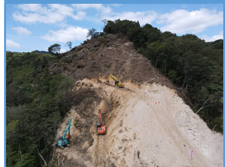
管理道の掘削状況
