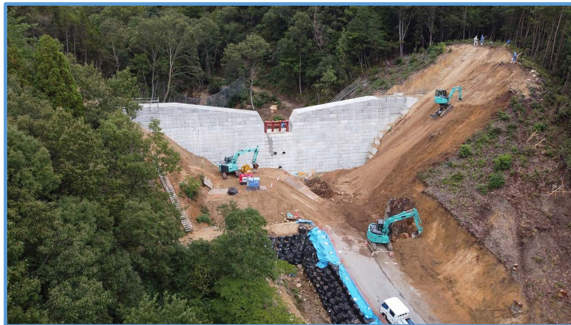
砂防堰堤左岸下流の法面掘削状況
