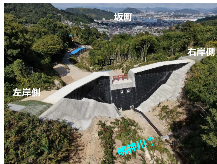
堰堤施工状況(上流より)
