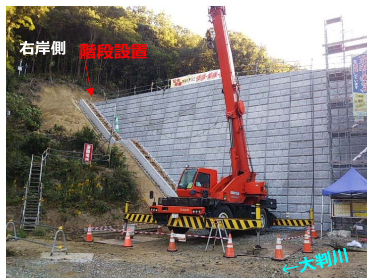
大判川施工状況（左岸側より）
