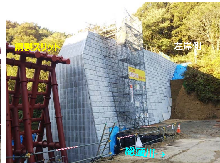
総頭川施工状況（右岸側より）
