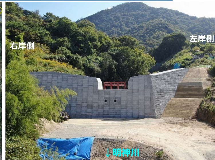
堰堤施工状況(堰堤直下)
