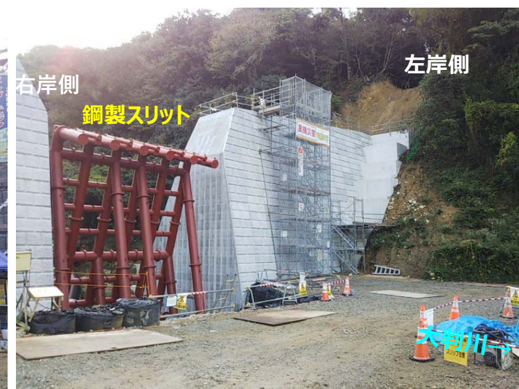
大判川施工状況（右岸側より）
