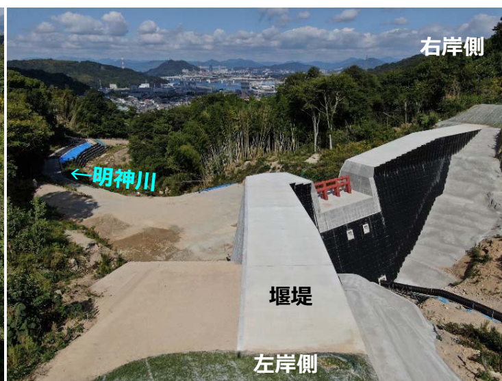
堰堤施工状況(左岸側より)
