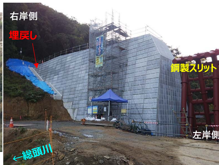
総頭川施工状況（左岸側より）
