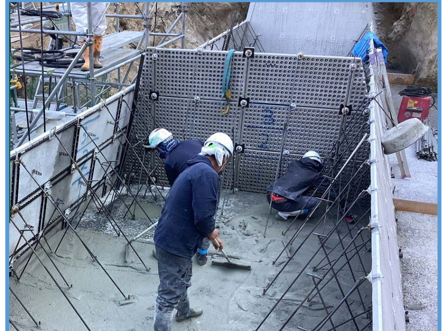
第1垂直壁のコンクリート打設状況
