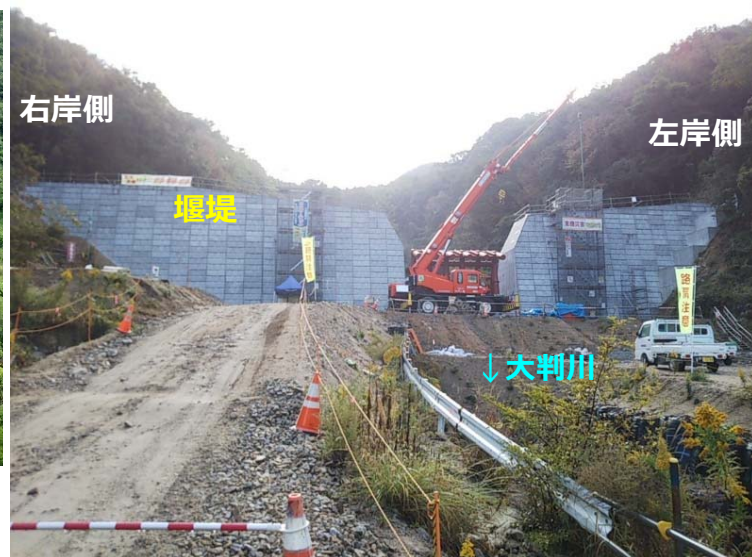
大判川施工状況（左岸側より）
