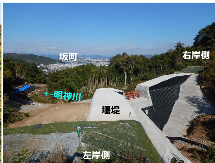
堰堤施工状況(左岸側より)
