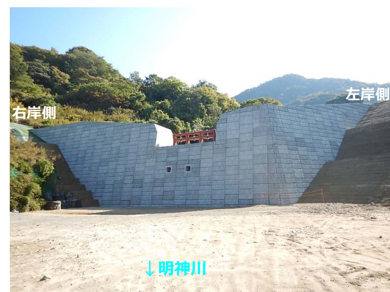
堰堤施工状況(堰堤直下)
