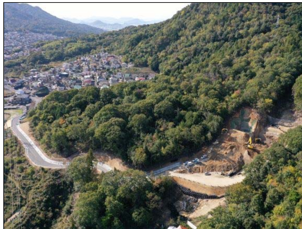
工事用道路施工状況
