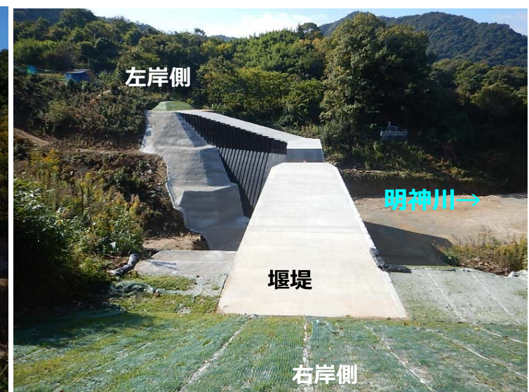
堰堤施工状況(右岸側より)
