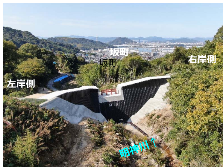
堰堤施工状況(上流より)
