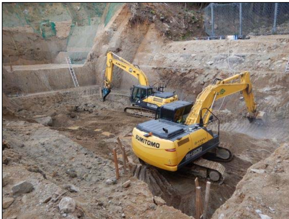
掘削作業状況
