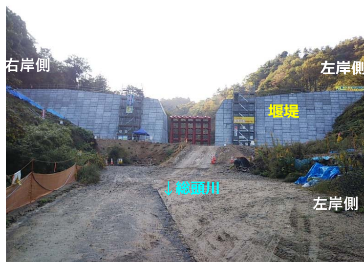
総頭川施工状況（左岸側より）
