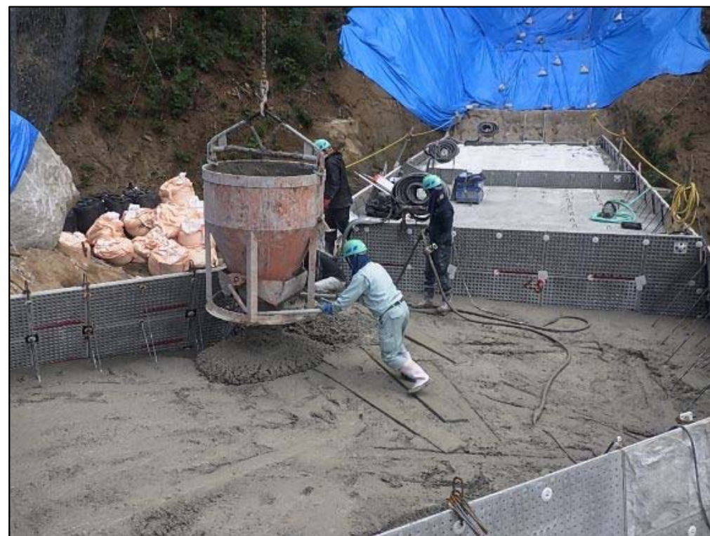
コンクリート打設状況
