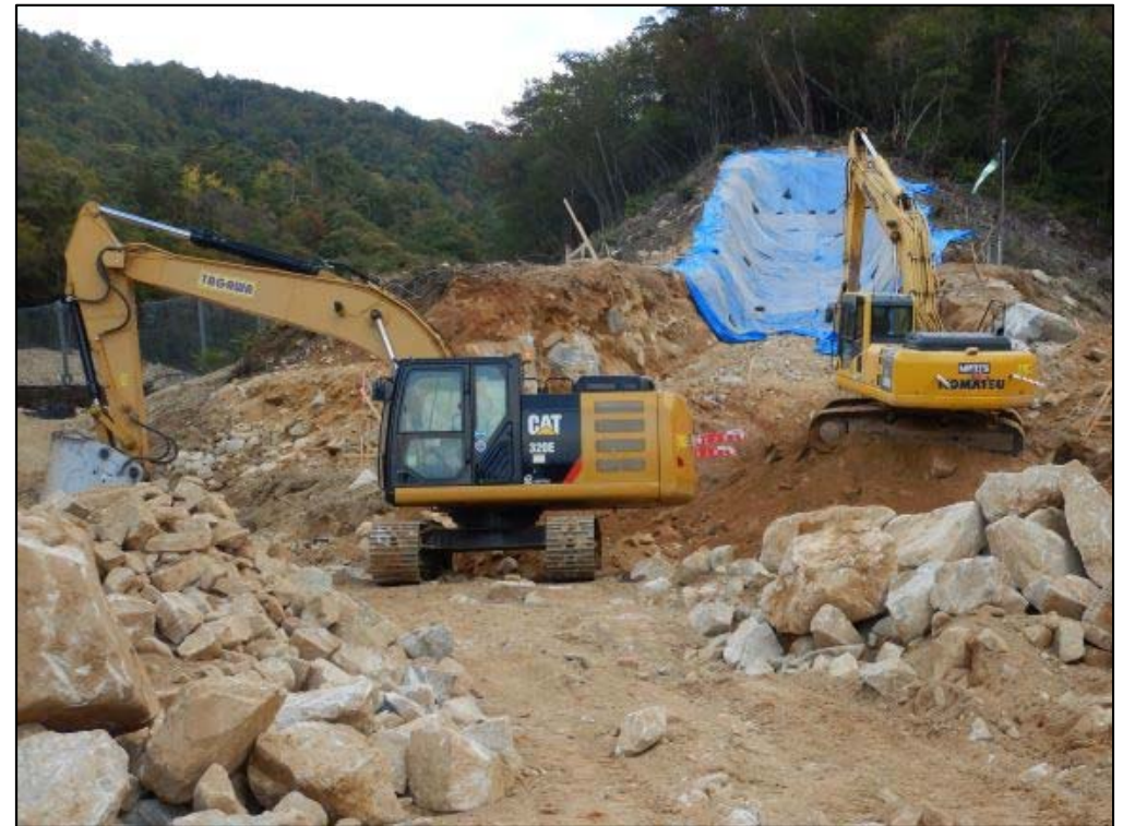
掘削作業状況
