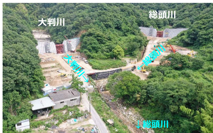
総頭川・大判川施工状況 (R2.6末時点)
