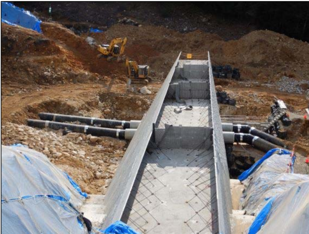
砂防堰堤施工状況
