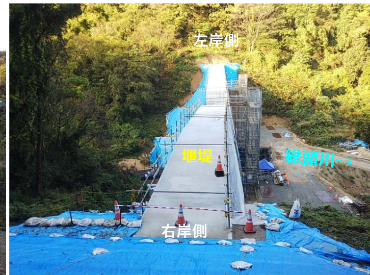
総頭川施工状況（右岸側より）
