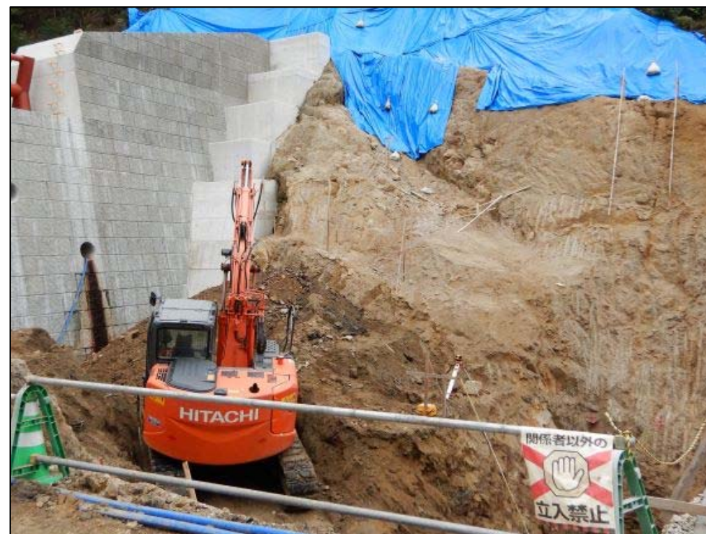
掘削作業状況②
