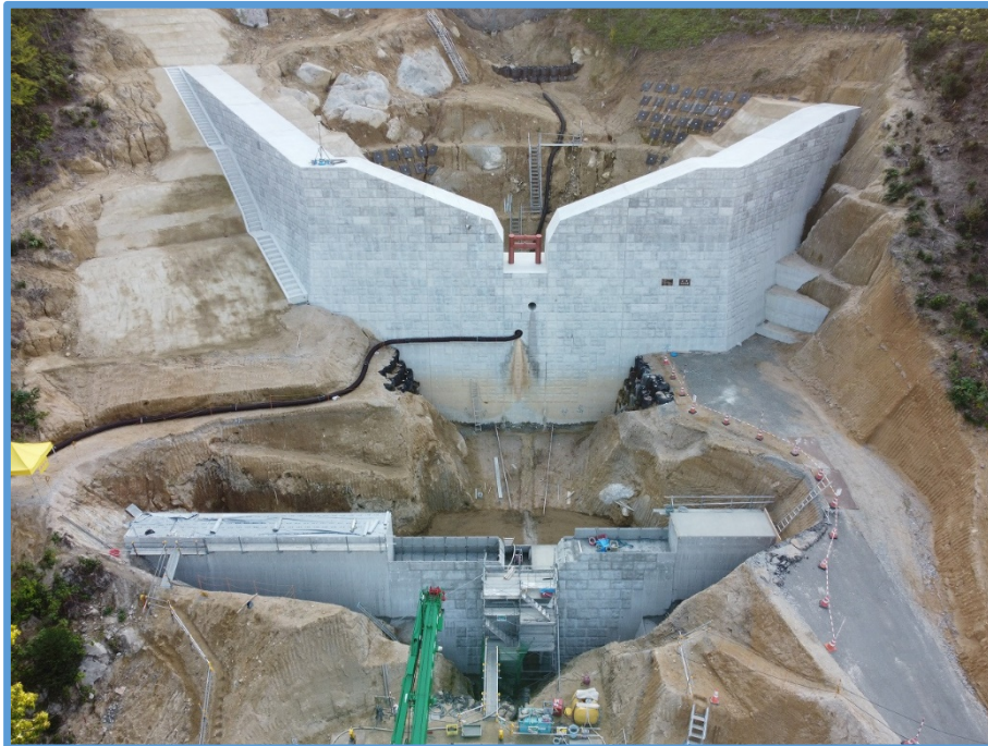
第1垂直壁のコンクリート打設状況
