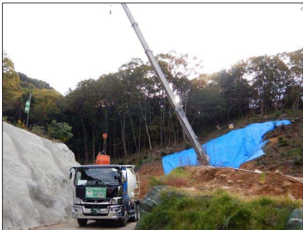
コンクリート打設状況①
