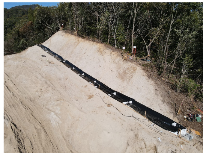
管理道の法面掘削実施状況
