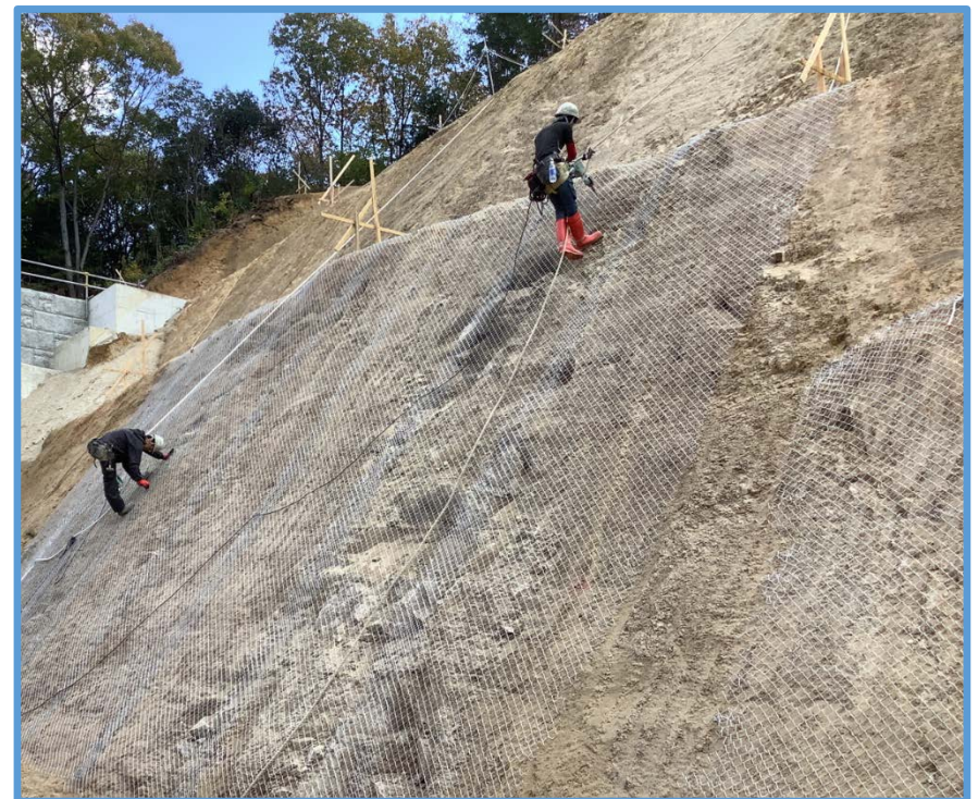
砂防堰堤左岸下流の法面工施工状況
