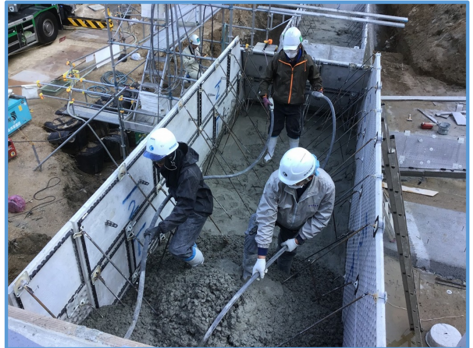
第1垂直壁のコンクリート打設状況
