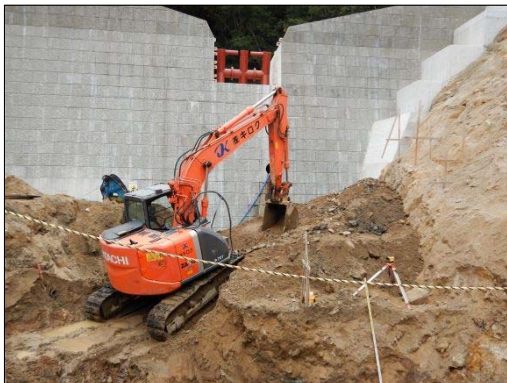
掘削作業状況①
