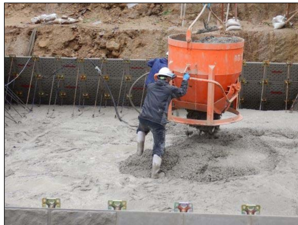
コンクリート打設状況②
