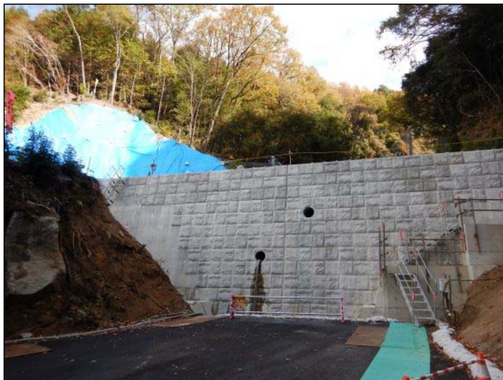
施工状況①
