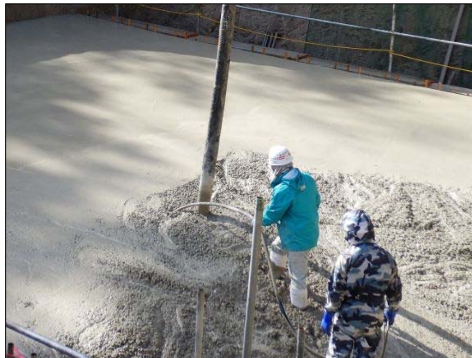
コンクリート打設状況②
