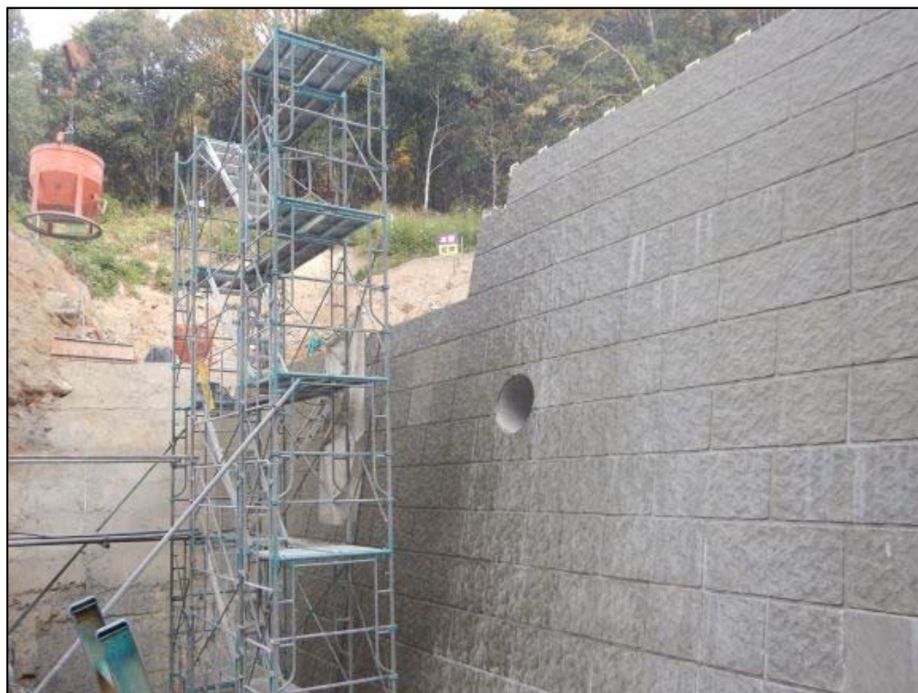
コンクリート打設状況①
