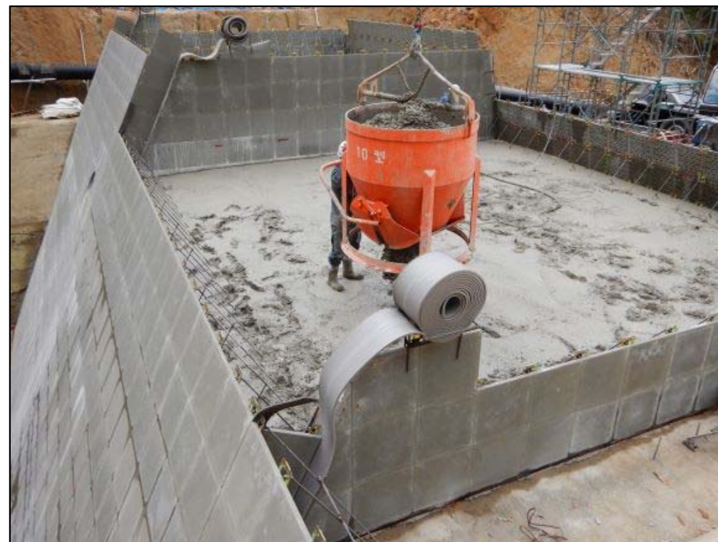
コンクリート打設状況②
