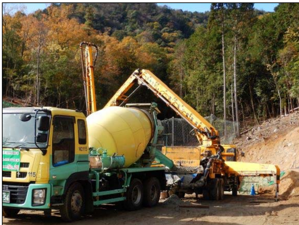
コンクリート打設状況①
