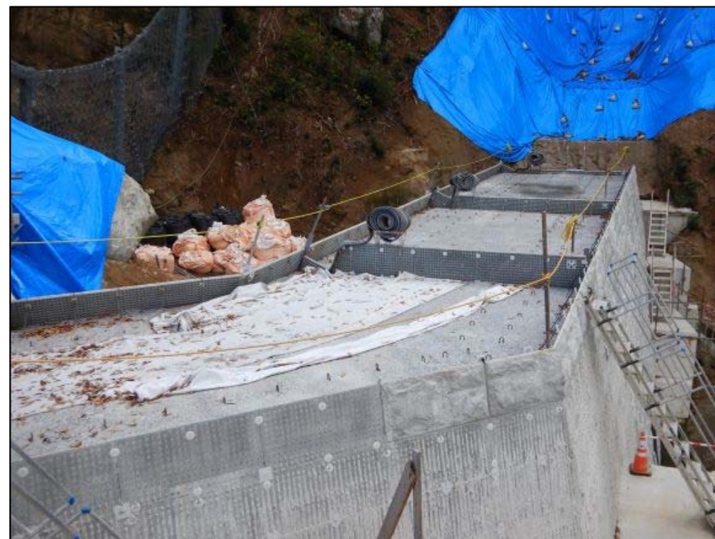
施工状況②
