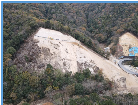
施工中（11月25日時点）
