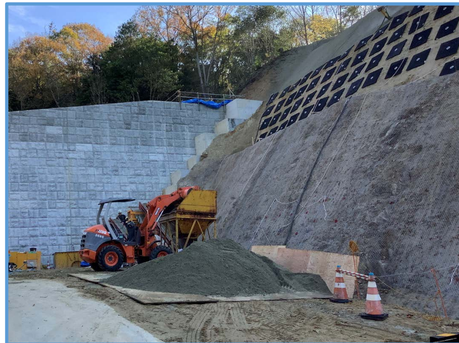
砂防堰堤左岸下流の法面工施工状況
