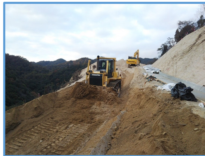
管理道の法面掘削実施状況
