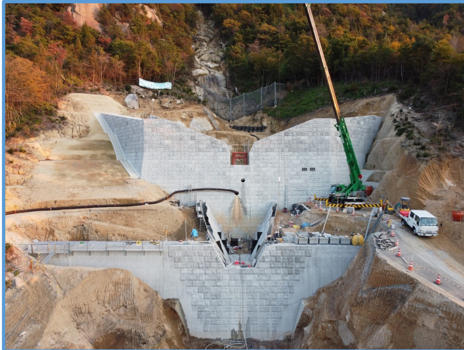
側壁工のコンクリート打設状況
