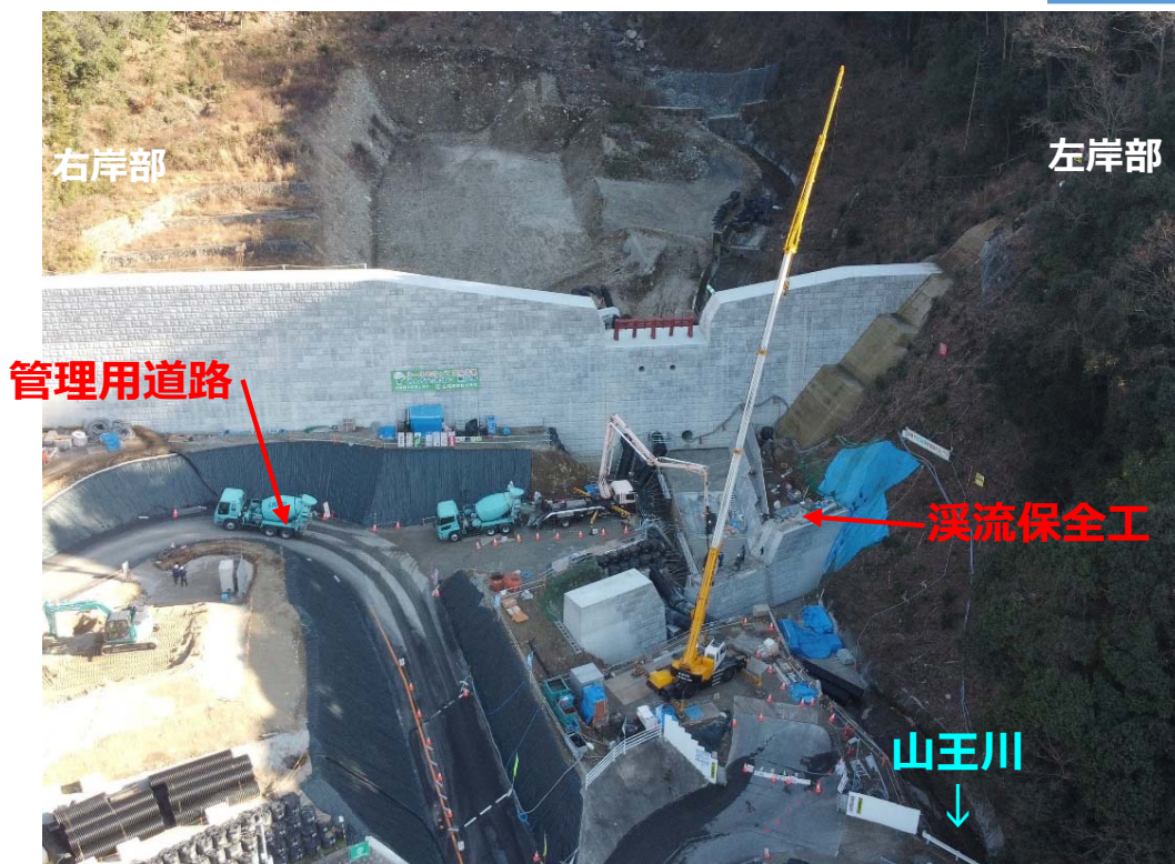
砂防堰堤本体下流部の施工状況
