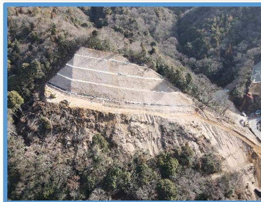
施工中（1月29日時点）
