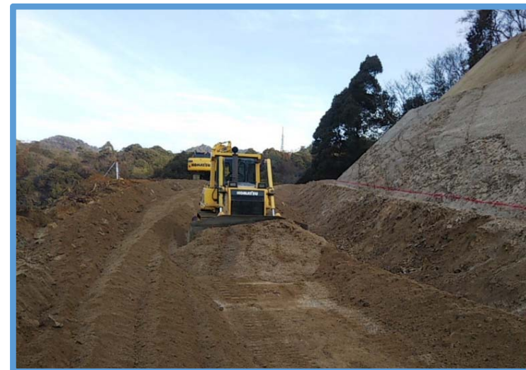
管理道の法面掘削実施状況
