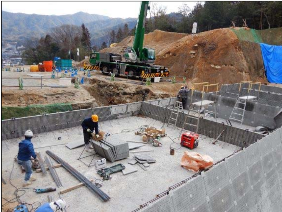
砂防堰堤施工状況
