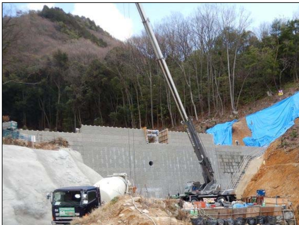
砂防堰堤施工状況
