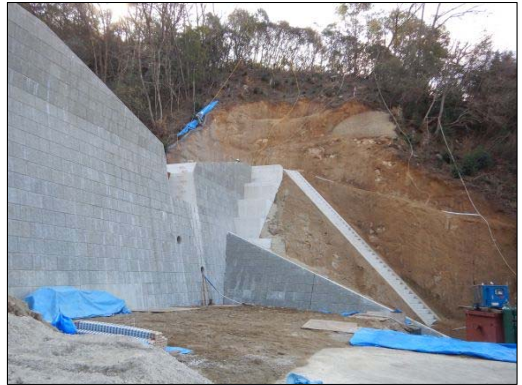
施工状況②
