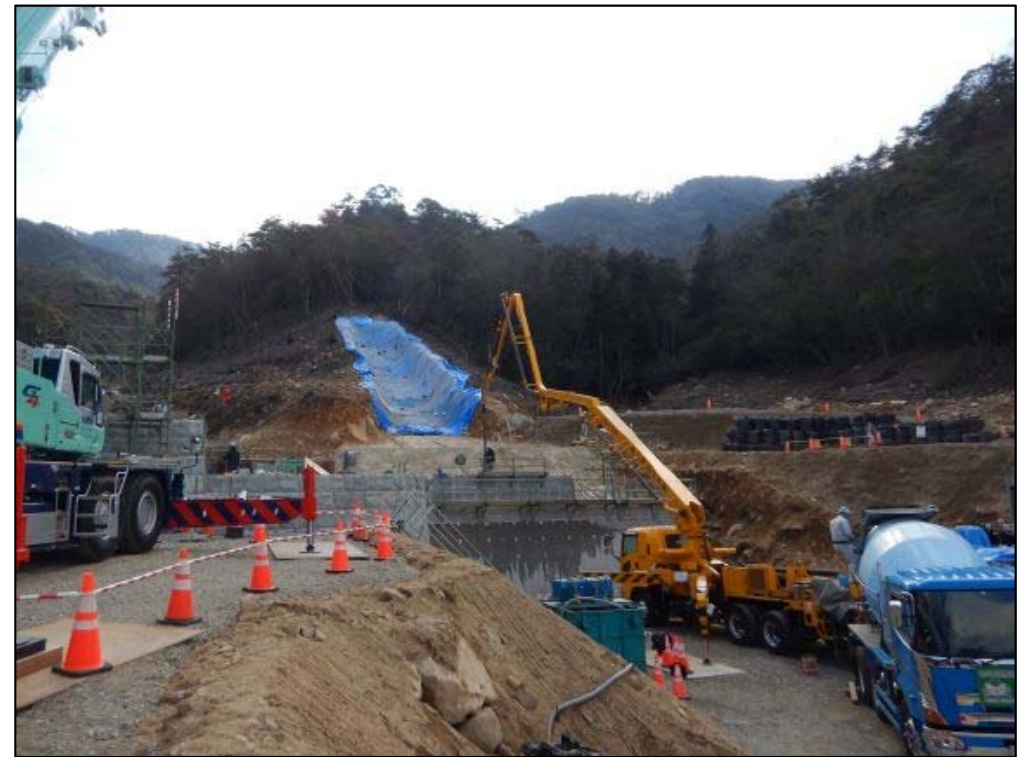
コンクリート打設状況
