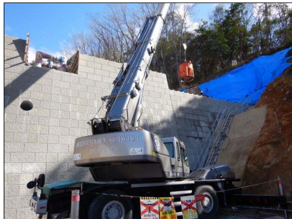
コンクリート打設状況
