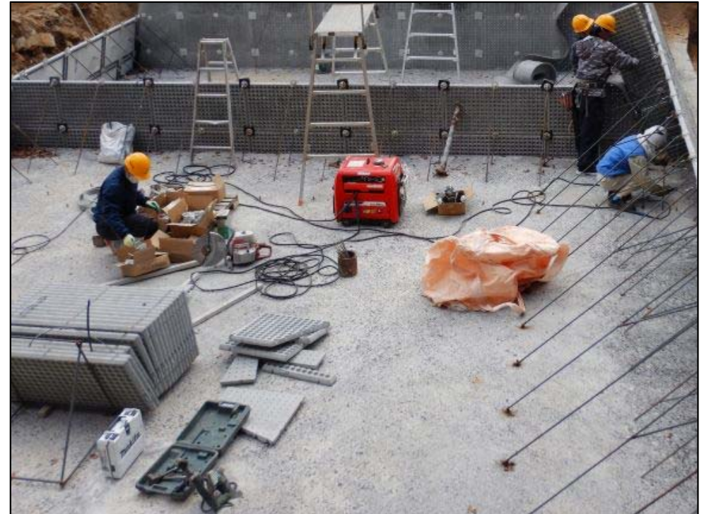
砂防堰堤施工状況
