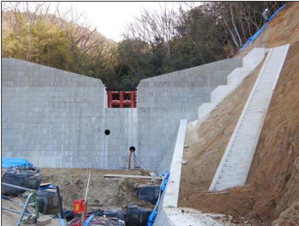
施工状況①
