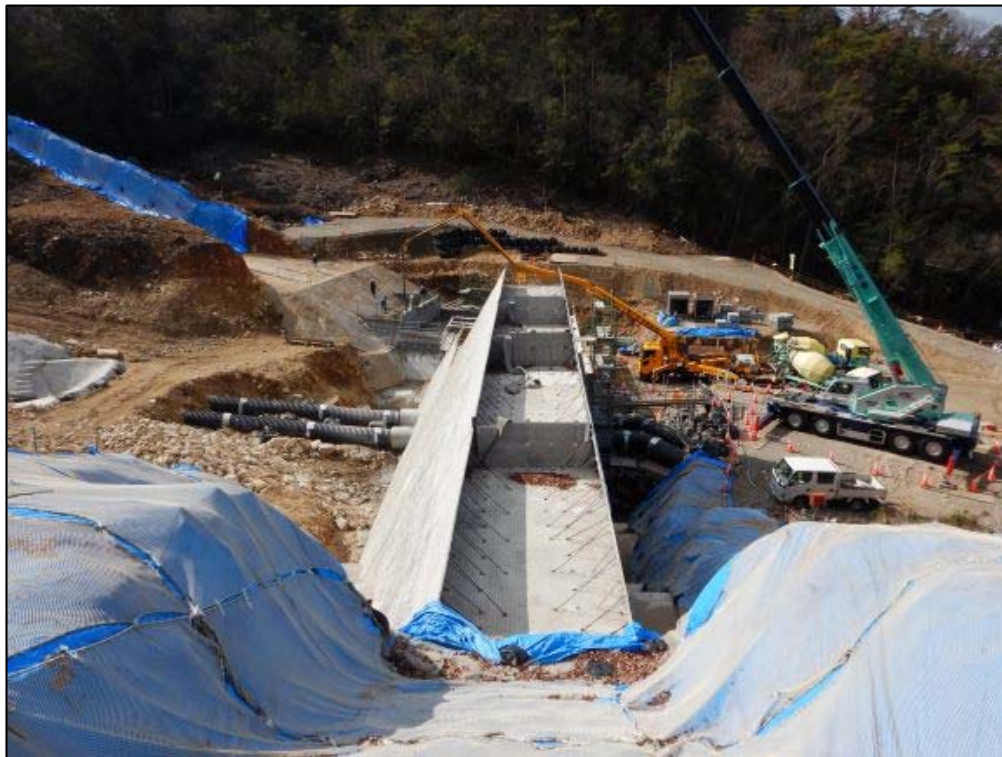
砂防堰堤施工状況
