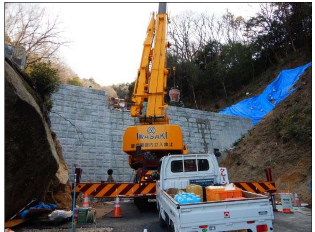
コンクリート打設状況
