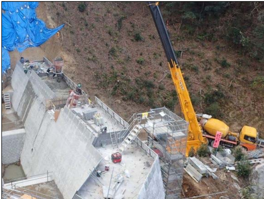
砂防堰堤施工状況
