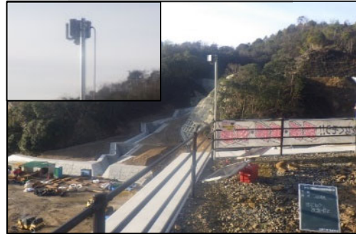
写真-4 現場設置状況
