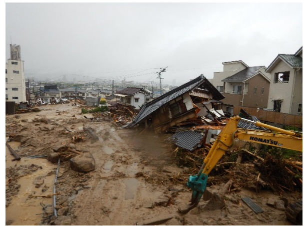
平成30年7月豪雨被災写真：広島県砂防課
