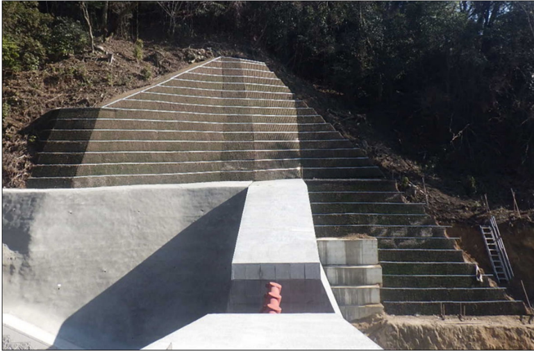
左岸袖部完成
