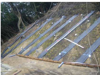
裏面排水材設置
