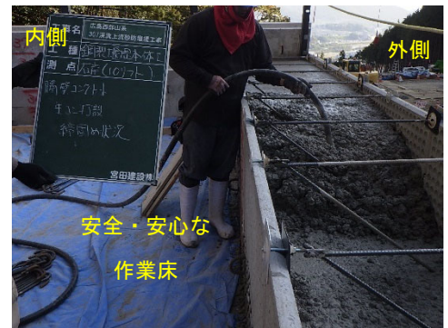
【図-11：本堤内作業状況】
