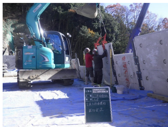
【本堤内クレーンによる作業状況】
