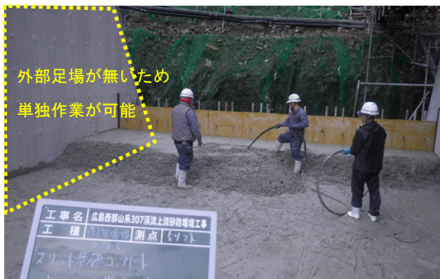
【図-12：スリット基礎 Co 打設状況】
