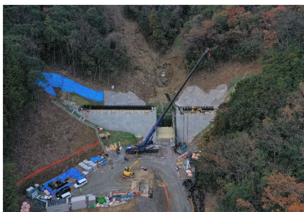
【130t クレーンによる運搬状況】
