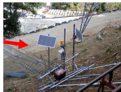
写真-15 下部側 土石流警報装置の設置
