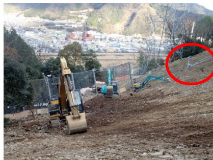
写真-15 下部側 土石流警報装置の設置
