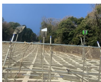
写真-16 Webカメラ(法面上段部)
