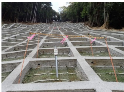
写真-14 法面最上段部 傾斜計設置
