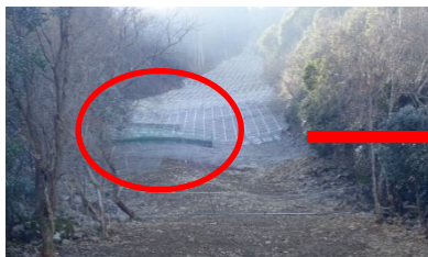
写真-9 法面全景
