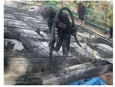
写真-7 圧送吹付にて供試体採取
