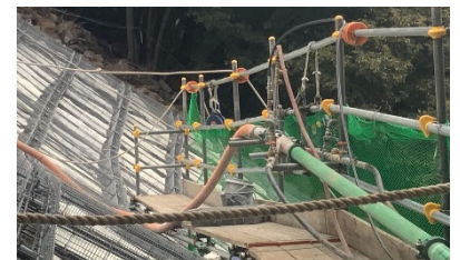
写真-10 中段仮設通路
