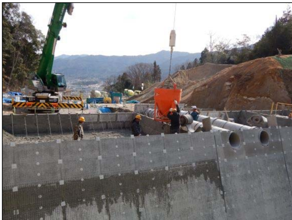
コンクリート打設状況①
