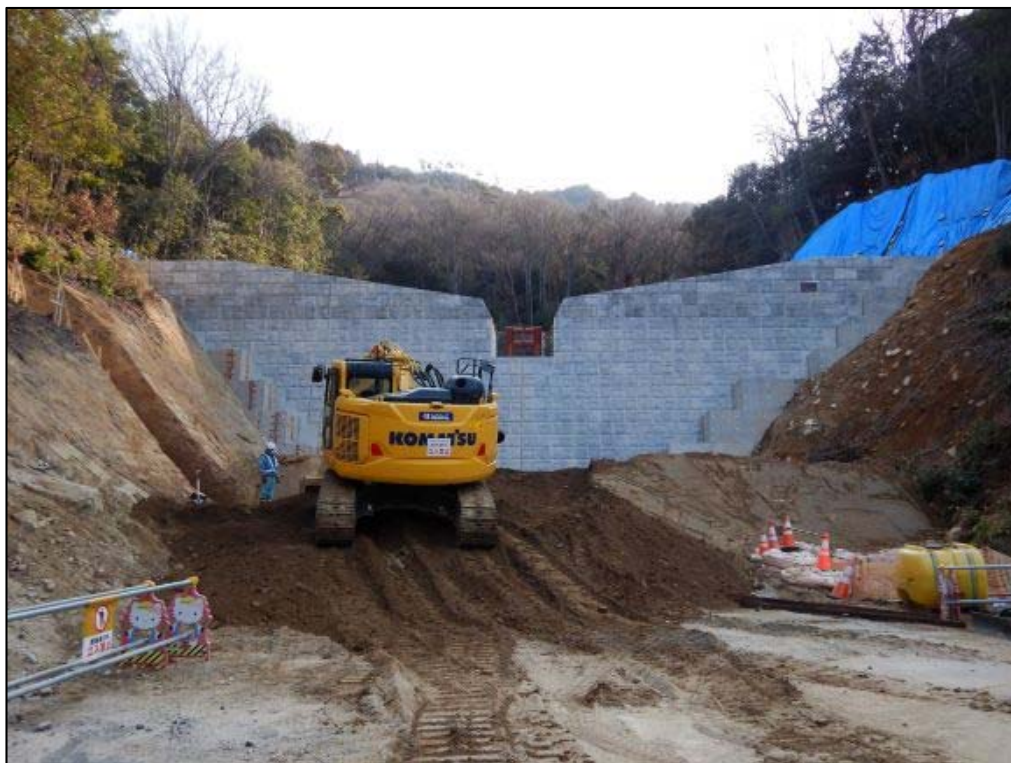
施工状況①
