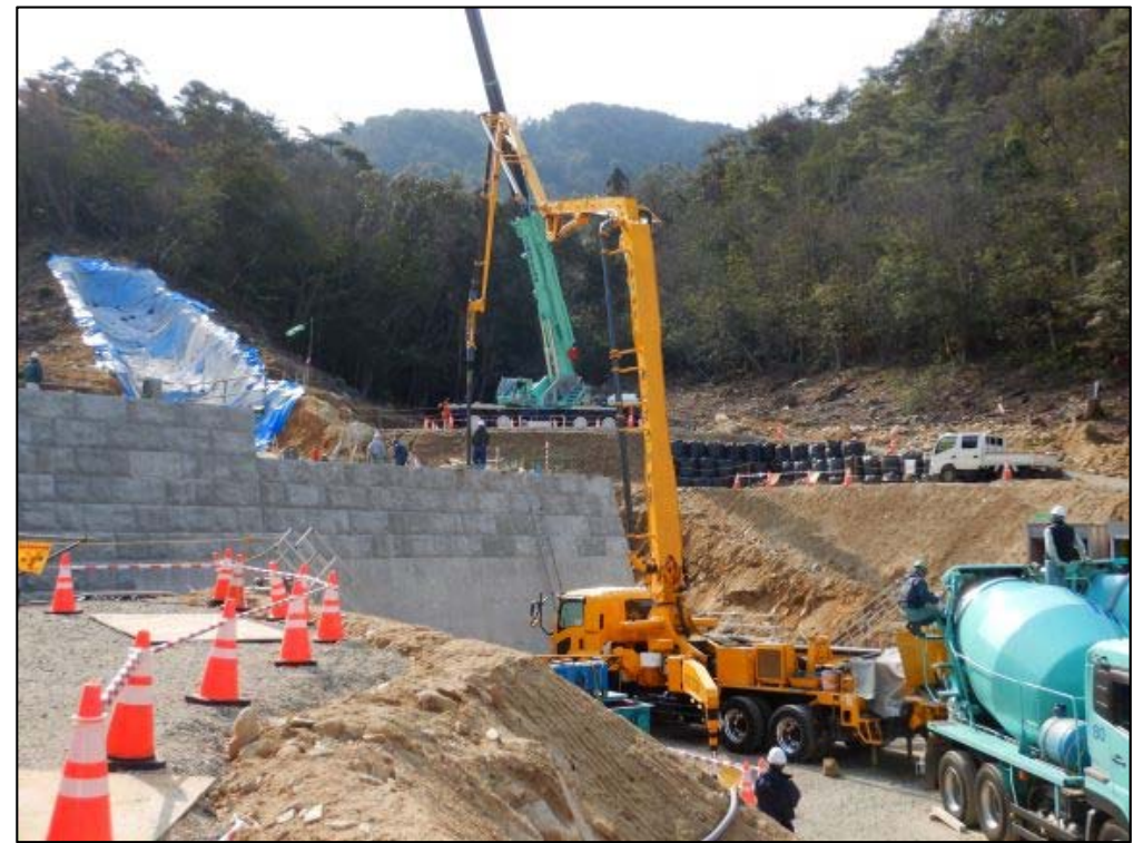
コンクリート打設状況
