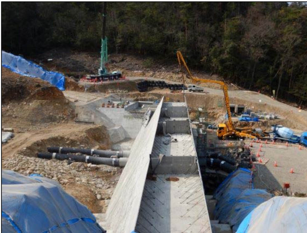
砂防堰堤施工状況
