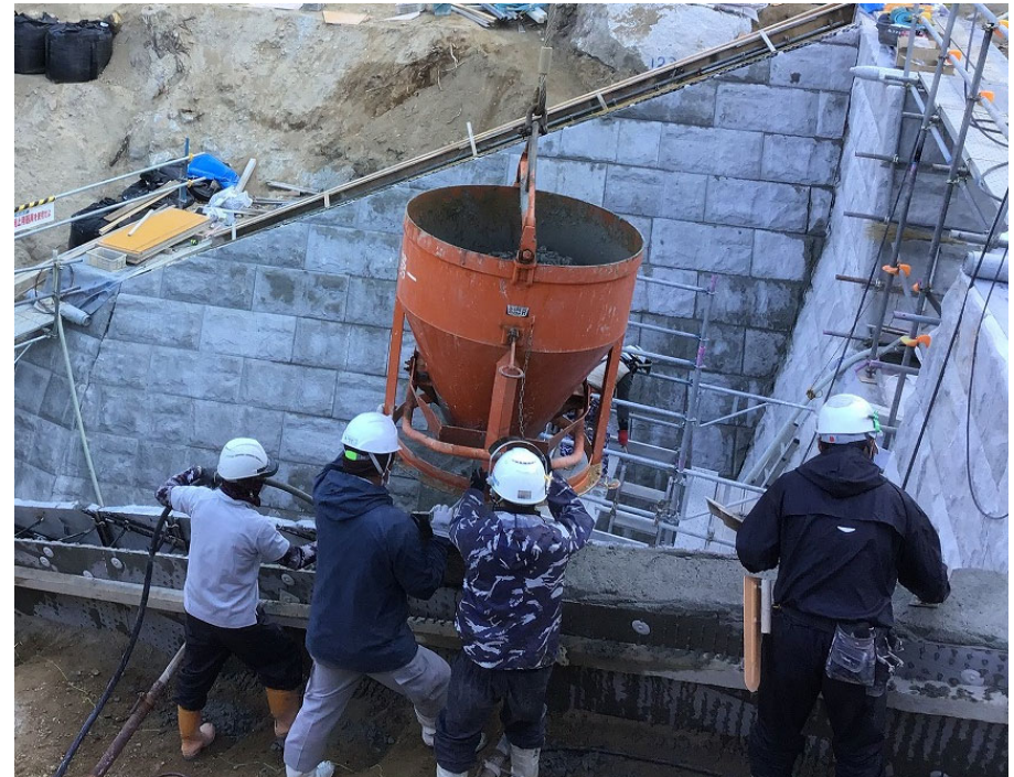
側壁工のコンクリート打設状況
