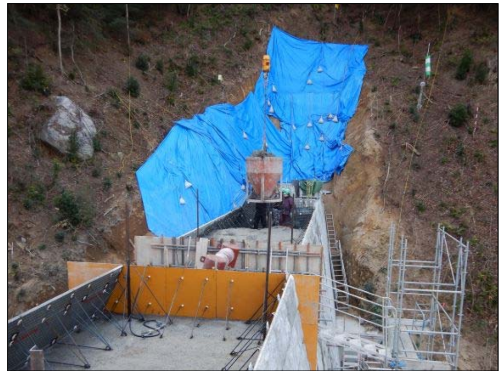
コンクリート打設状況②
