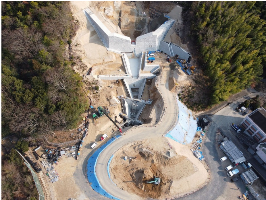
側壁工のコンクリート打設状況
