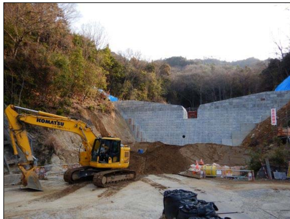
施工状況②
