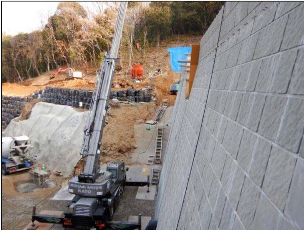
コンクリート打設状況①
