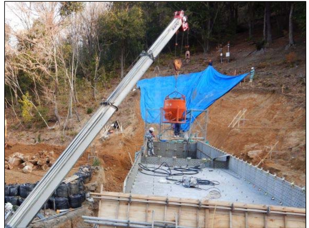
コンクリート打設状況②
