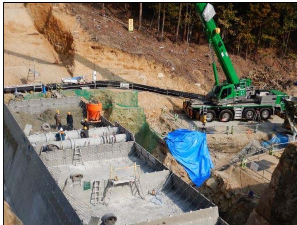
コンクリート打設状況②
