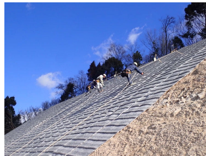
管理道の法面工実施状況
