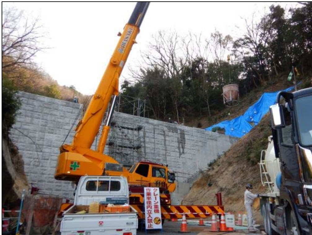
コンクリート打設状況①
