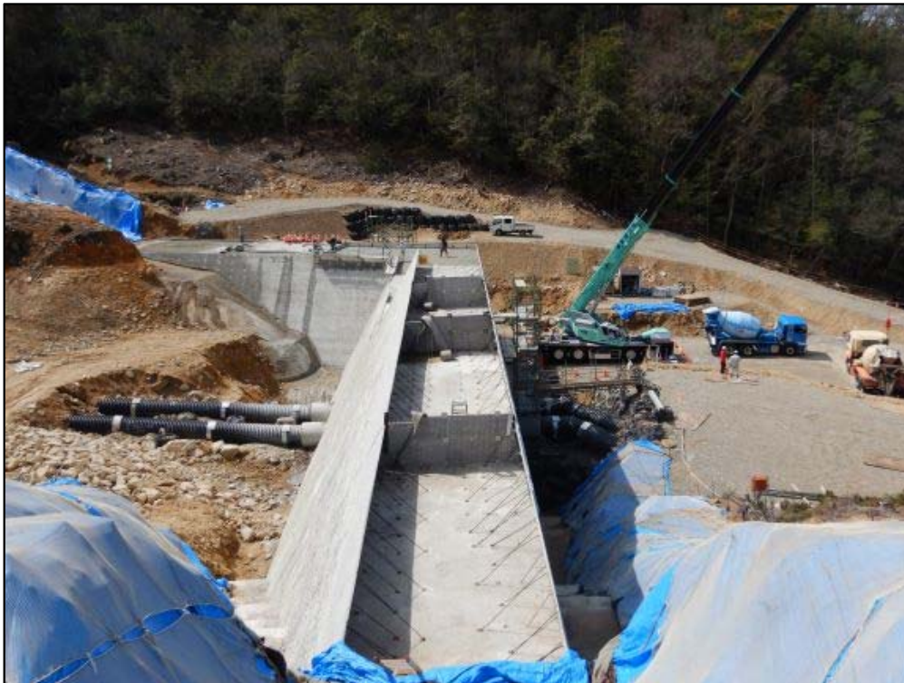
砂防堰堤施工状況
