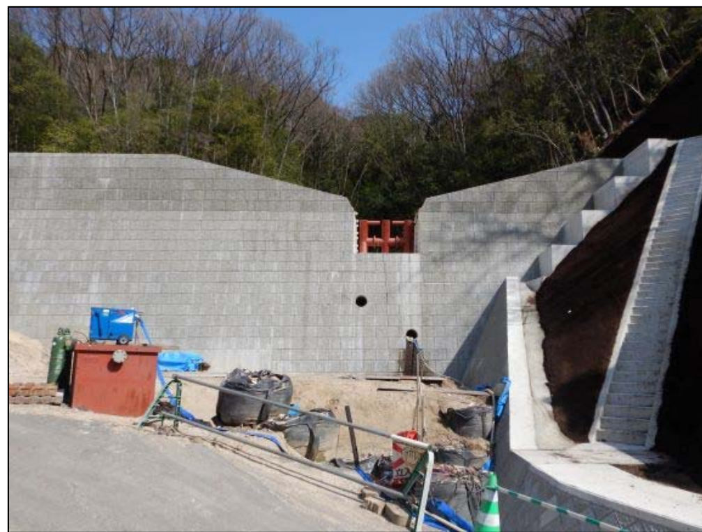
施工状況②
