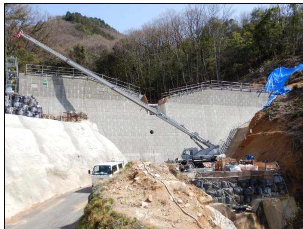
施工状況②
