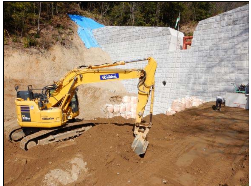
施工状況②
