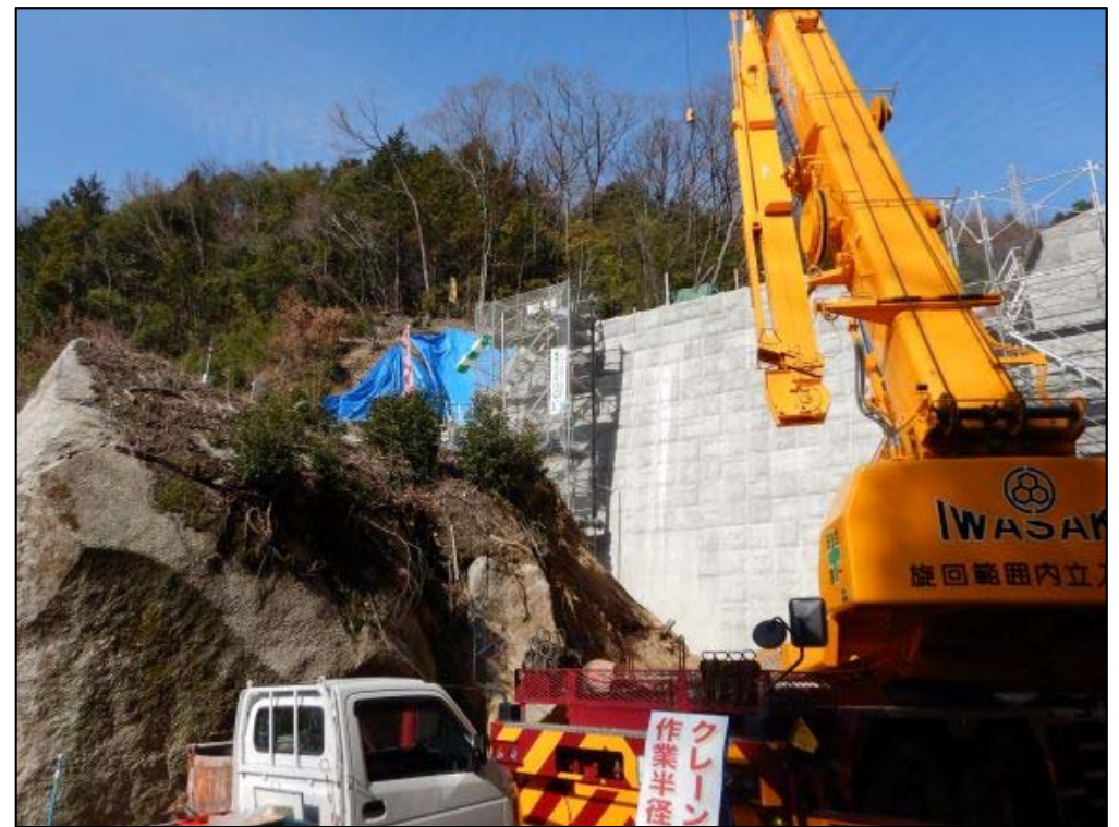
施工状況②
