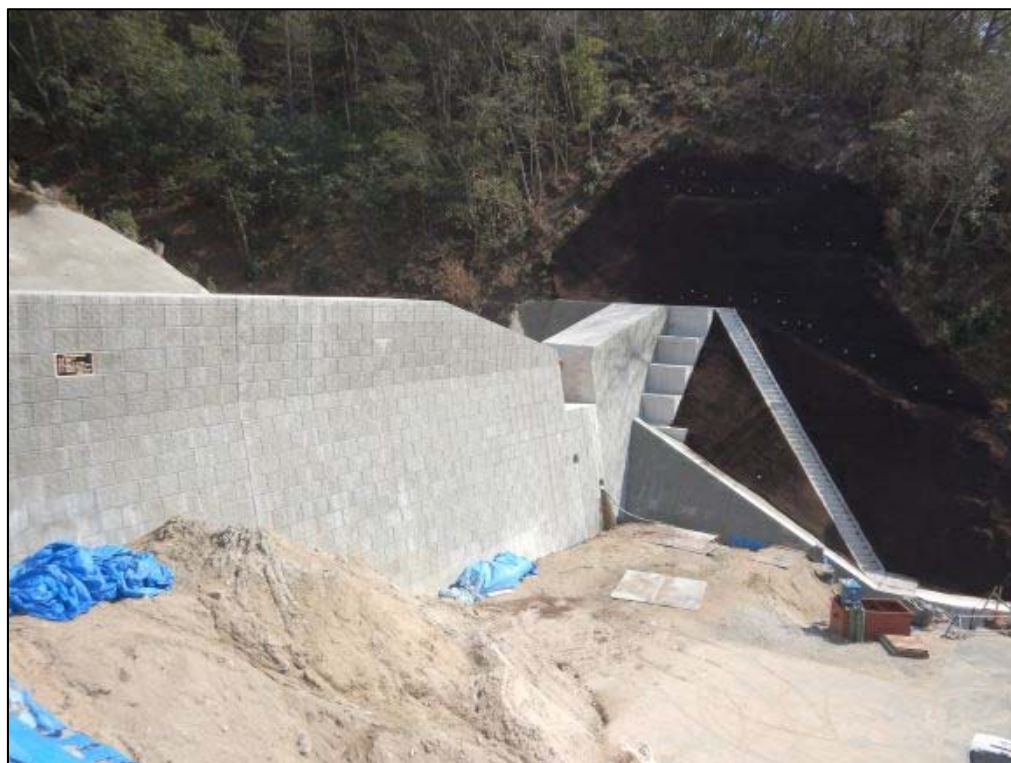
施工状況①
