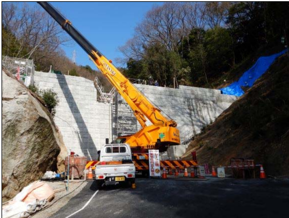
施工状況①
