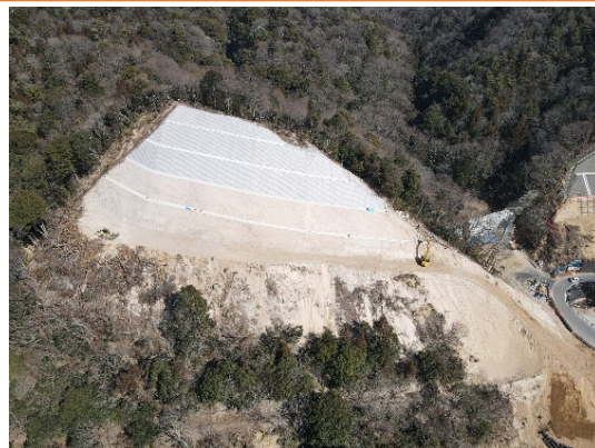
施工中（2月19日時点）
