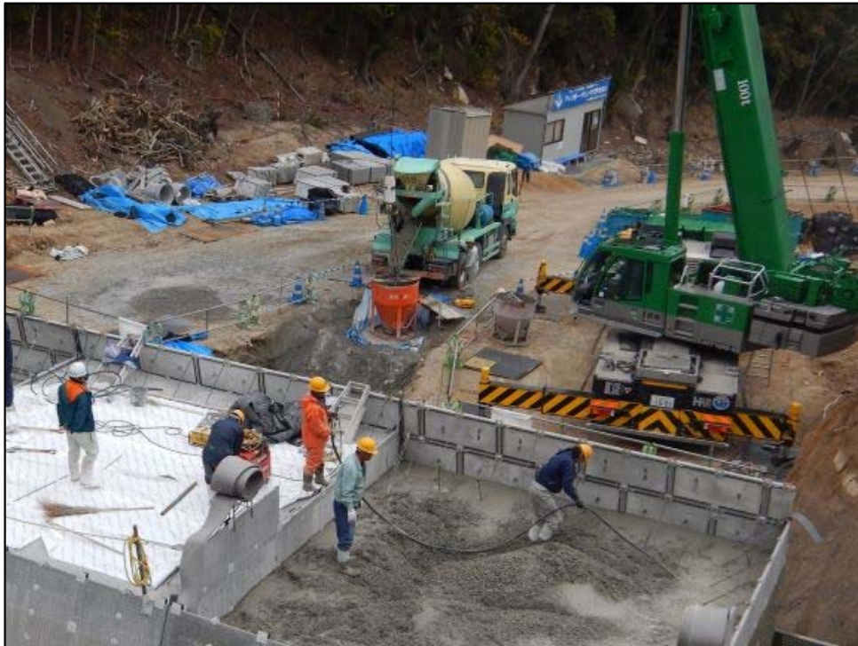
コンクリート打設状況①
