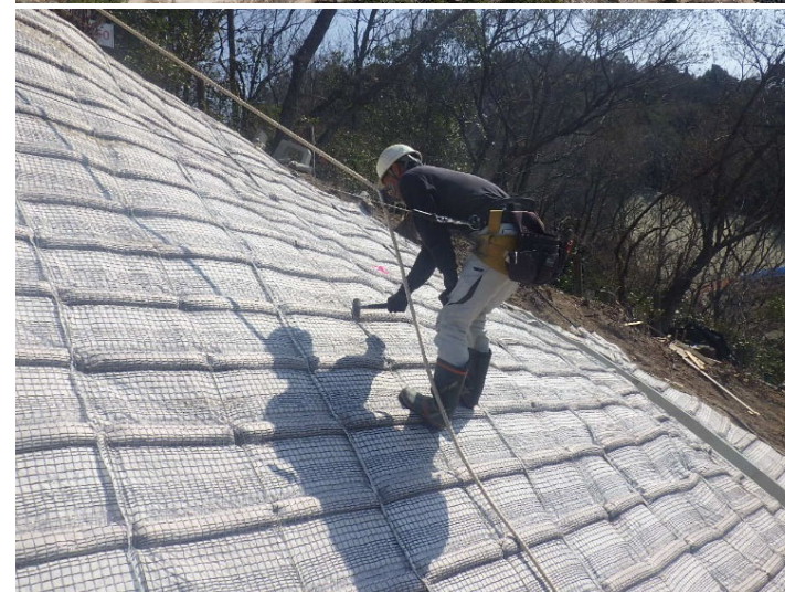
管理道の法面工実施状況
