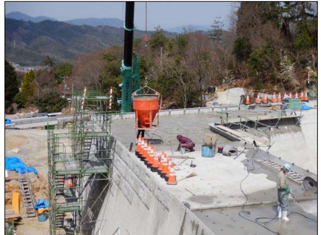
コンクリート打設状況
