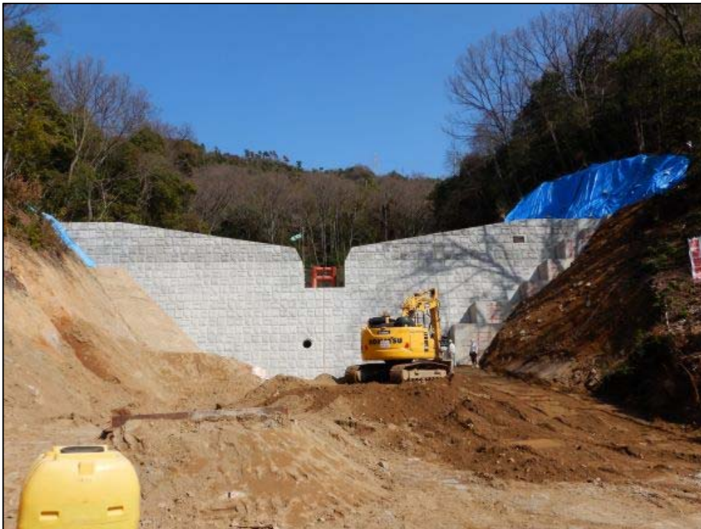
施工状況①
