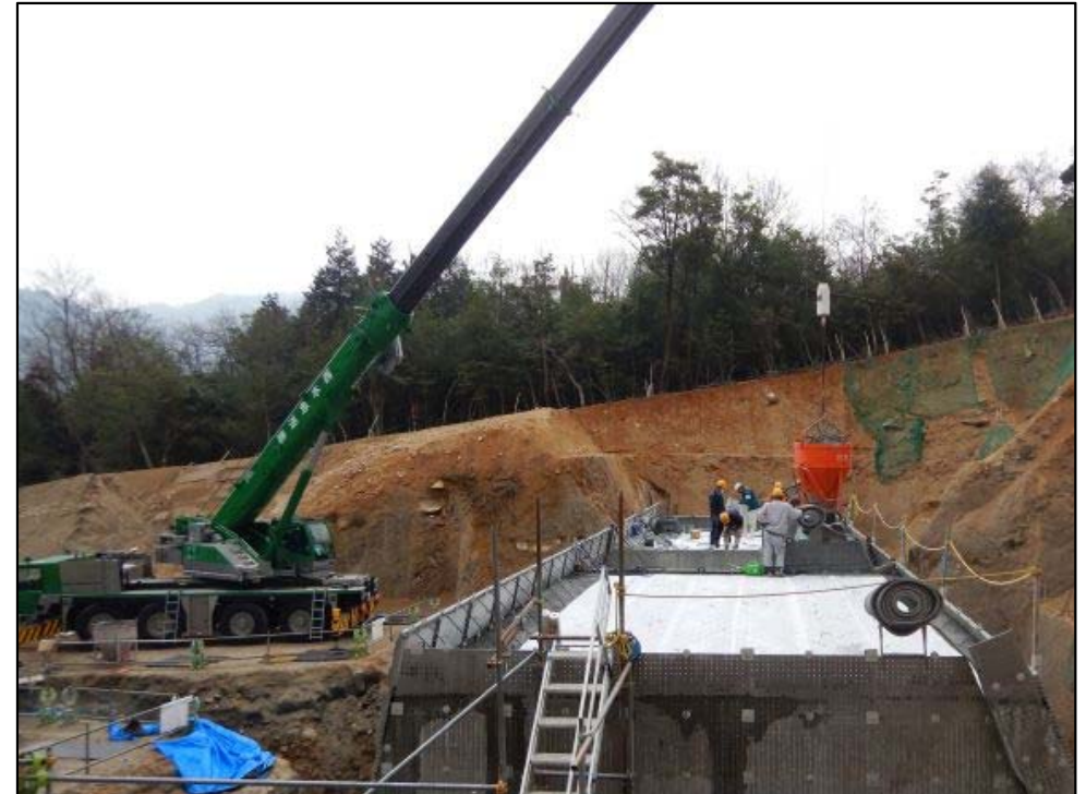
コンクリート打設状況②
