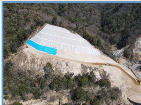
施工中（3月10日時点）
