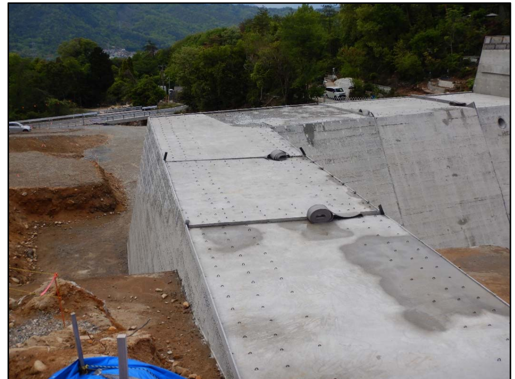
コンクリート打設状況
