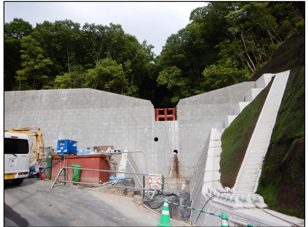
施工状況②
