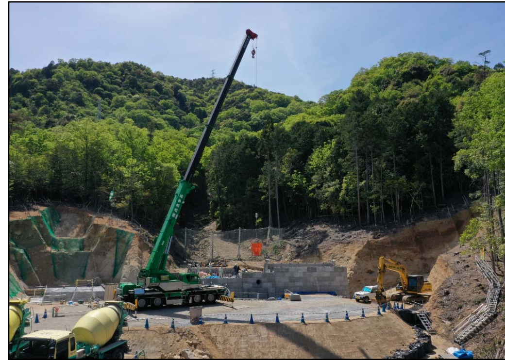
コンクリート打設状況②
