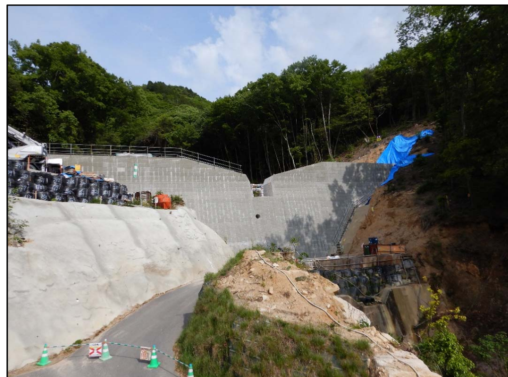
施工状況②
