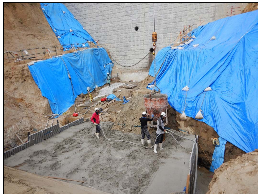
施工状況②
