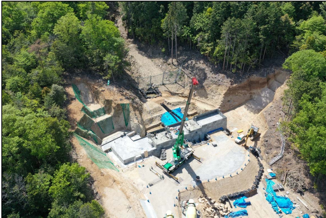
コンクリート打設状況①
