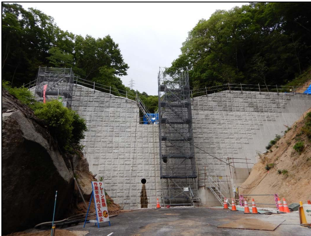
施工状況①
