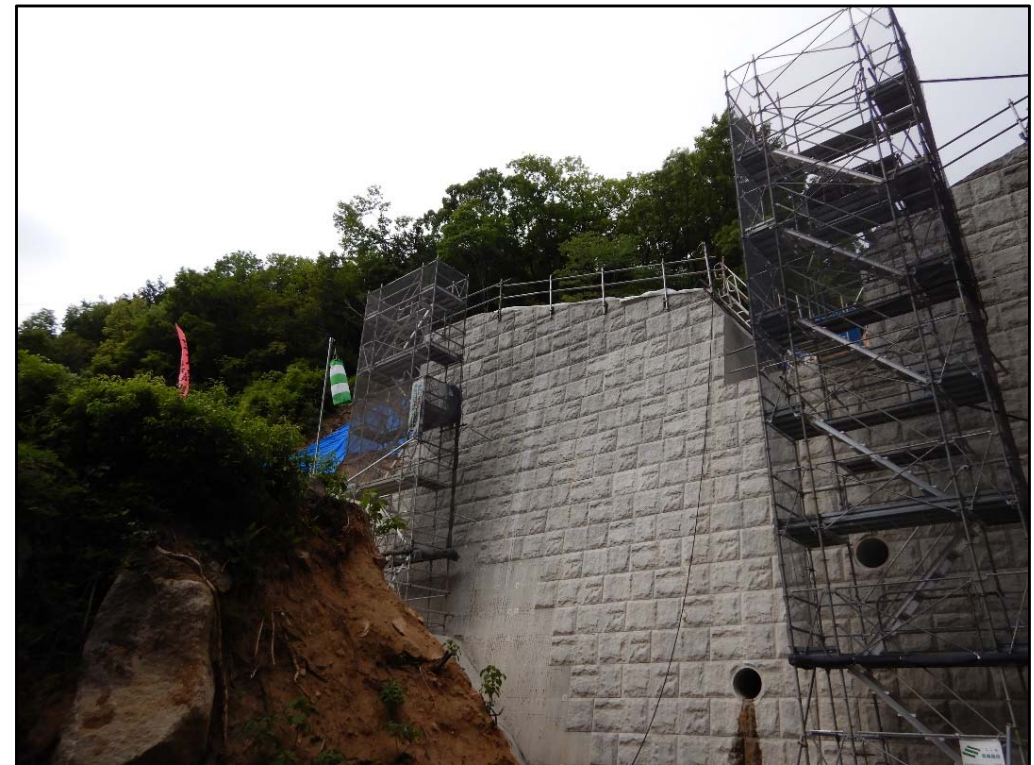
施工状況②
