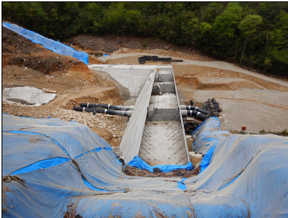
砂防堰堤施工状況
