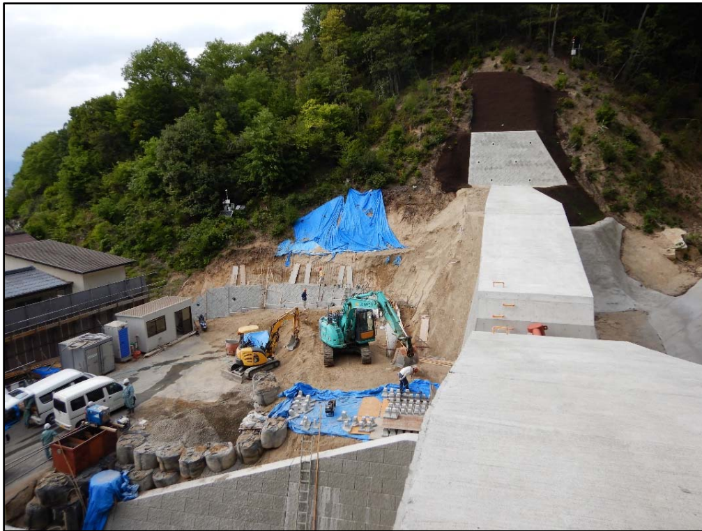
施工状況①
