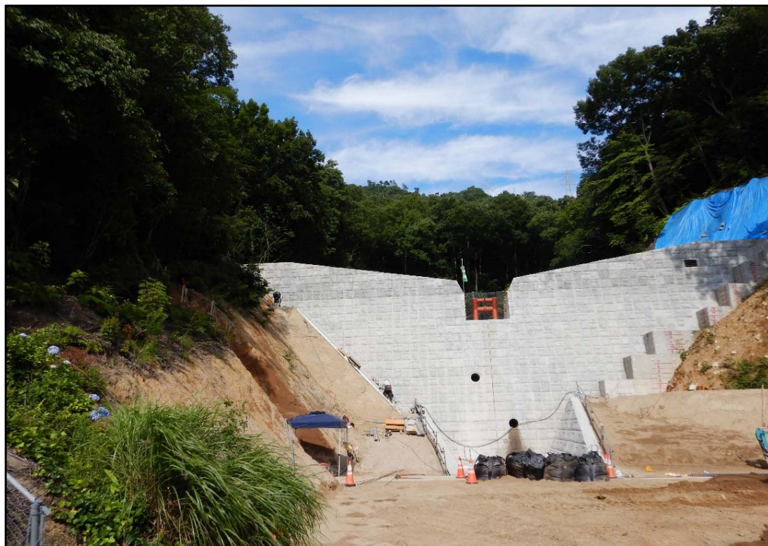
砂防堰堤全景
