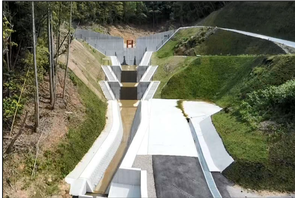
砂防堰堤全景
