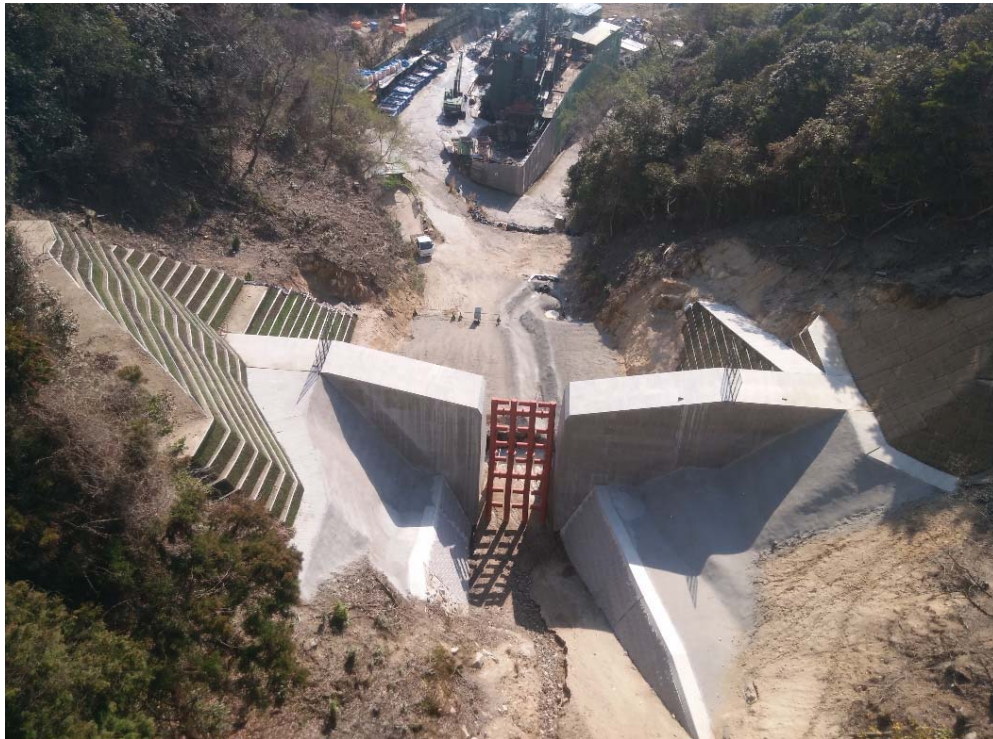
砂防堰堤上流側より
