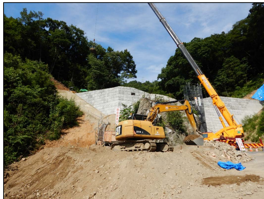
埋戻し施工状況
