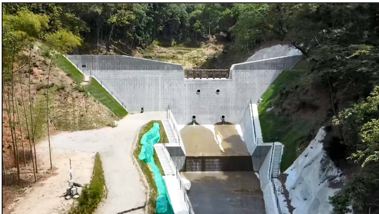
砂防堰堤全景
