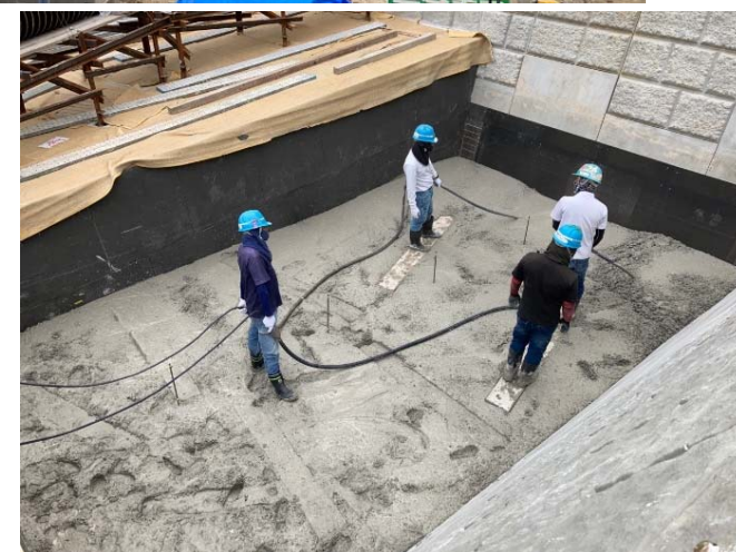
水叩工施工状況
