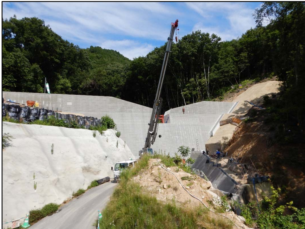
砂防堰堤全景
