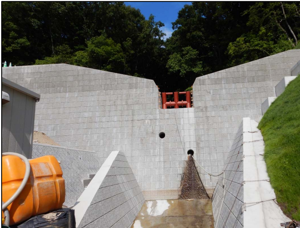
砂防堰堤全景
