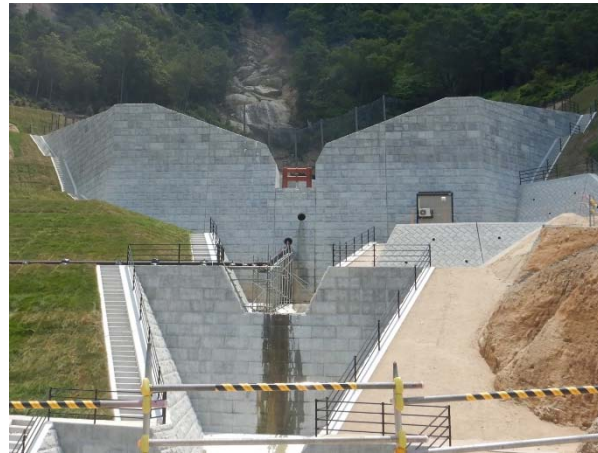
砂防堰堤正面写真
