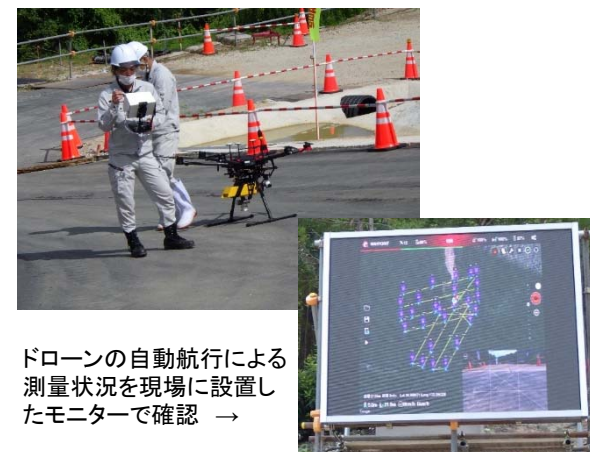
ドローンによる3次元レーザー測量
