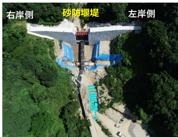
総頭川施工状況 (空撮) (R3.7月末時点)
