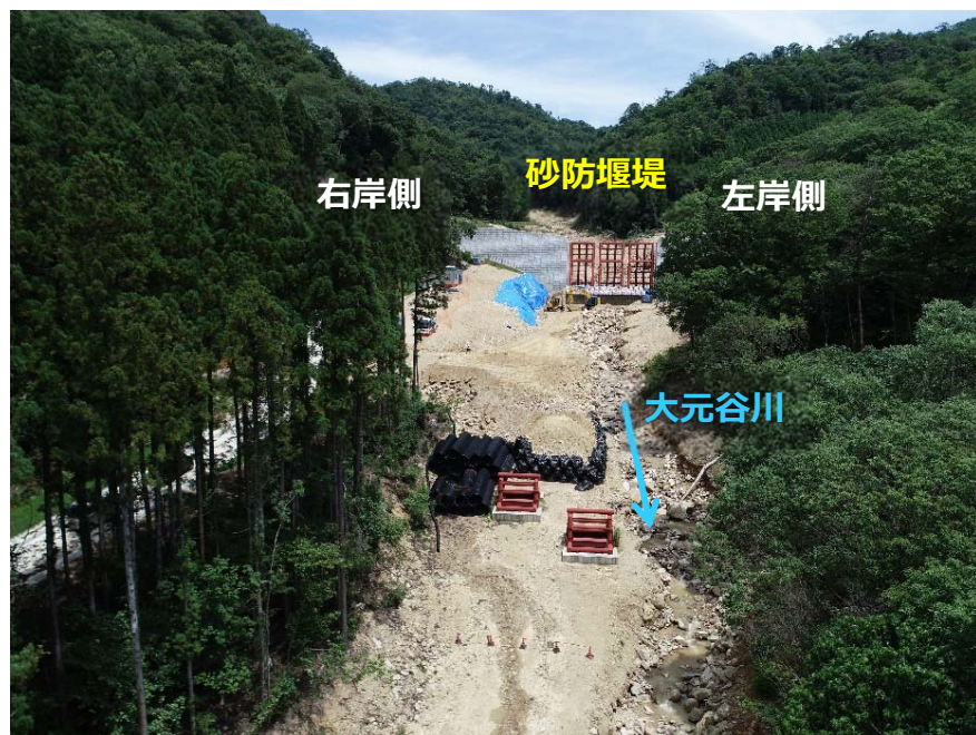
砂防堰堤全景（下流側より）
