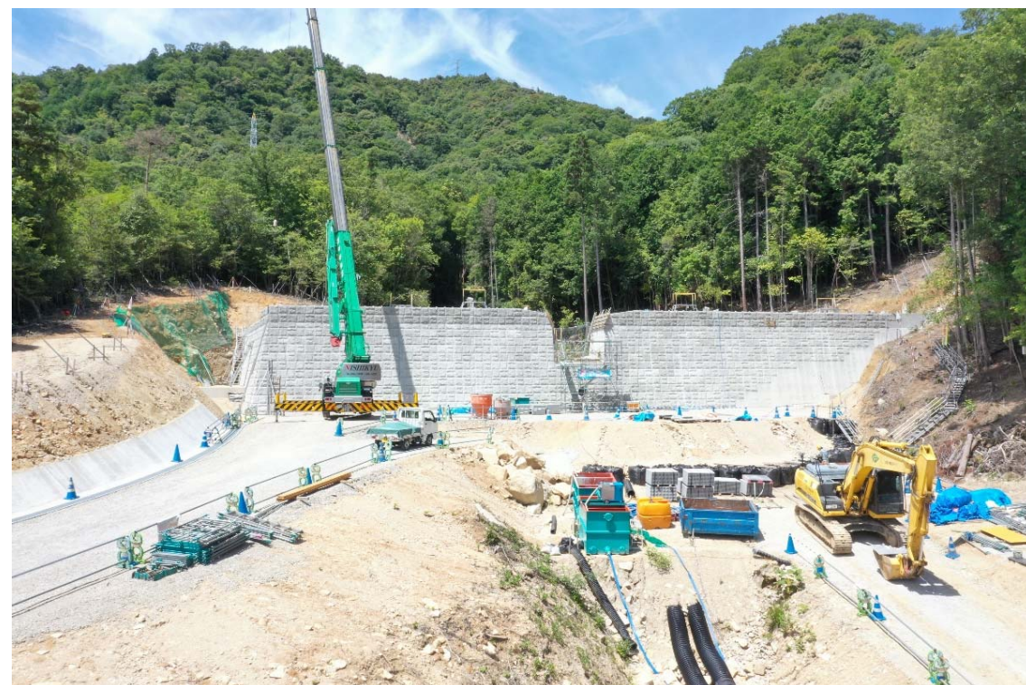
砂防堰堤施工状況①
