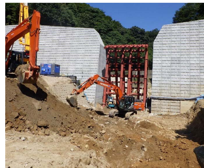
前庭保護工掘削状況 (大判川)
