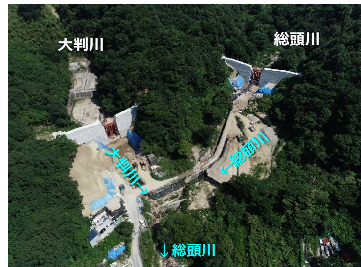
総頭川・大判川施工状況 (R3.7月末時点)
