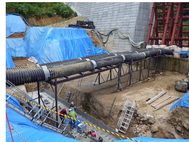
第1垂直壁施工状況 (総頭川)
