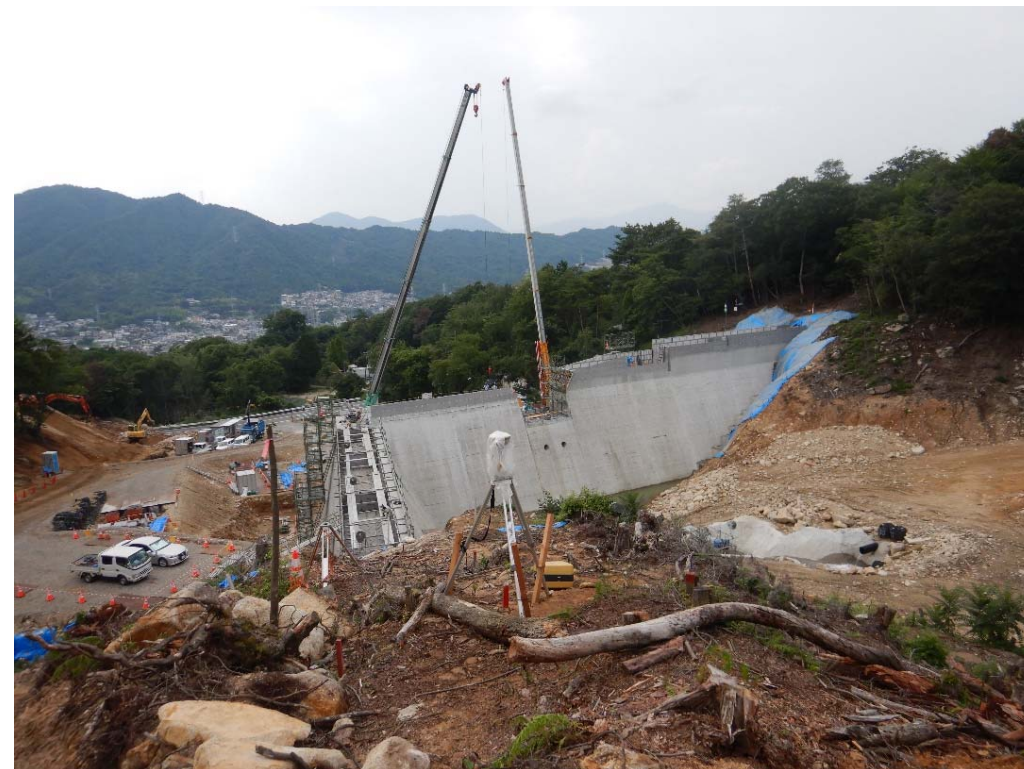
砂防堰堤施工状況 (上流側より)
