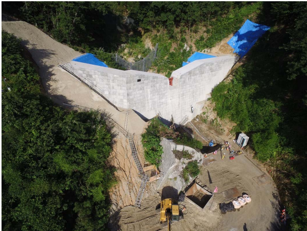
砂防堰堤全景
