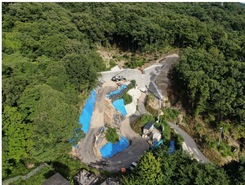
砂防堰堤全景
