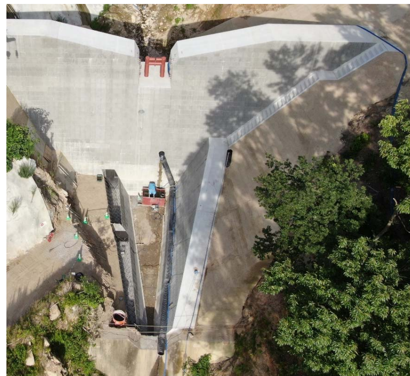
前庭保護工施工状況
