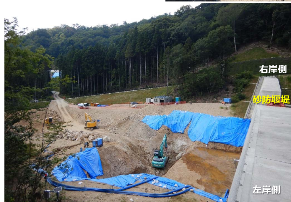
工事状況（堰堤左岸側より下流部を撮影）
