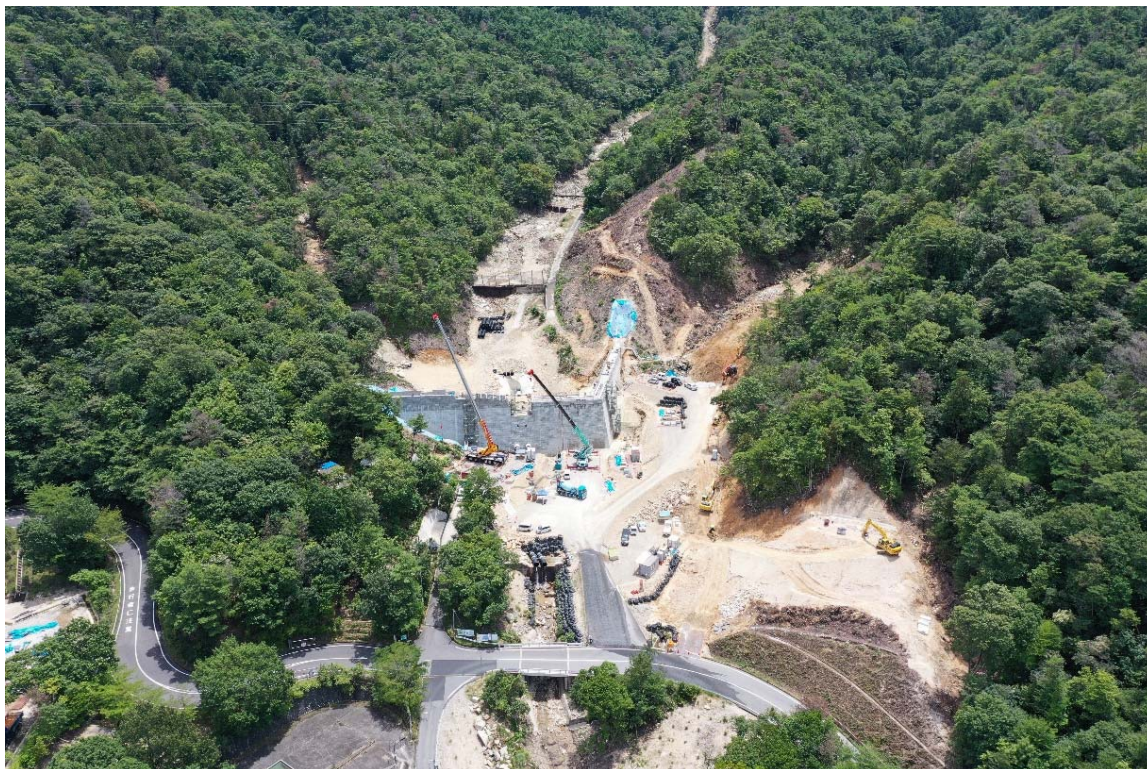
砂防堰堤施工状況 (全景)
