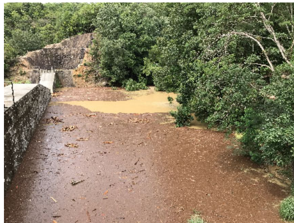
土石流発生直後（R3. 8. 15撮影）
