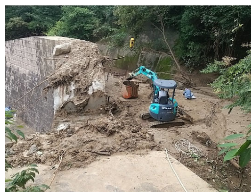
【集積した土砂等をホッパーへ積み込み】
