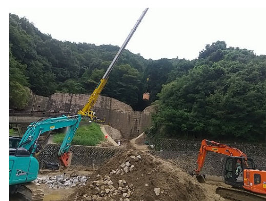
【クレーンで下流側へ下ろす】
