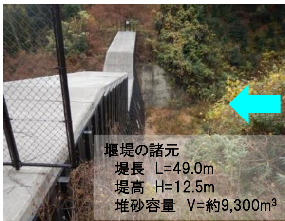
砂防堰堤の土砂堆積の状況 (R3. 8. 26撮影)
