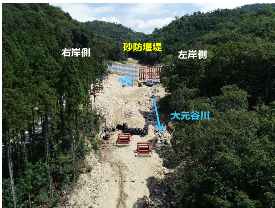
砂防堰堤全景（下流側より）
