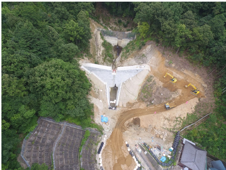
砂防堰堤全景（下流側より）
