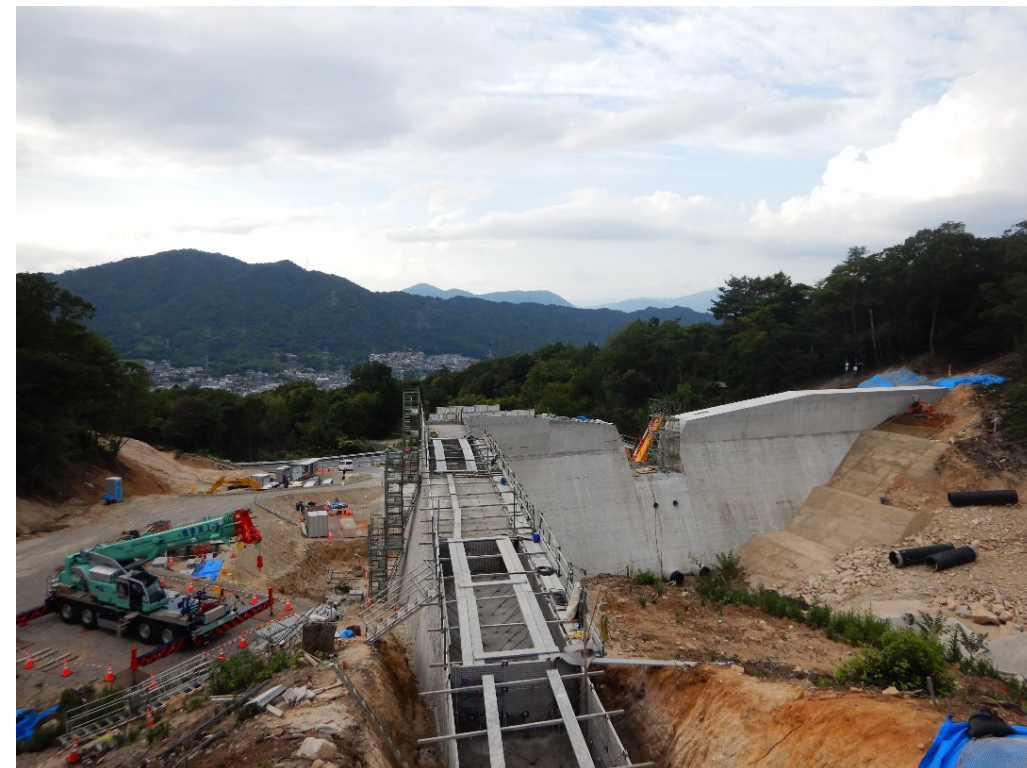
砂防堰堤施工状況 (上流側より)
