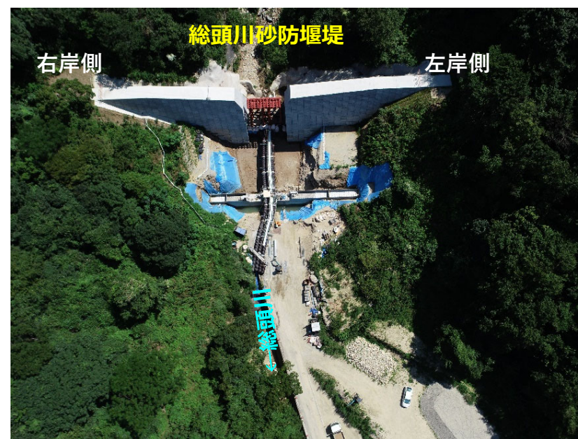
総頭川施工状況 (R3.8月末時点)
