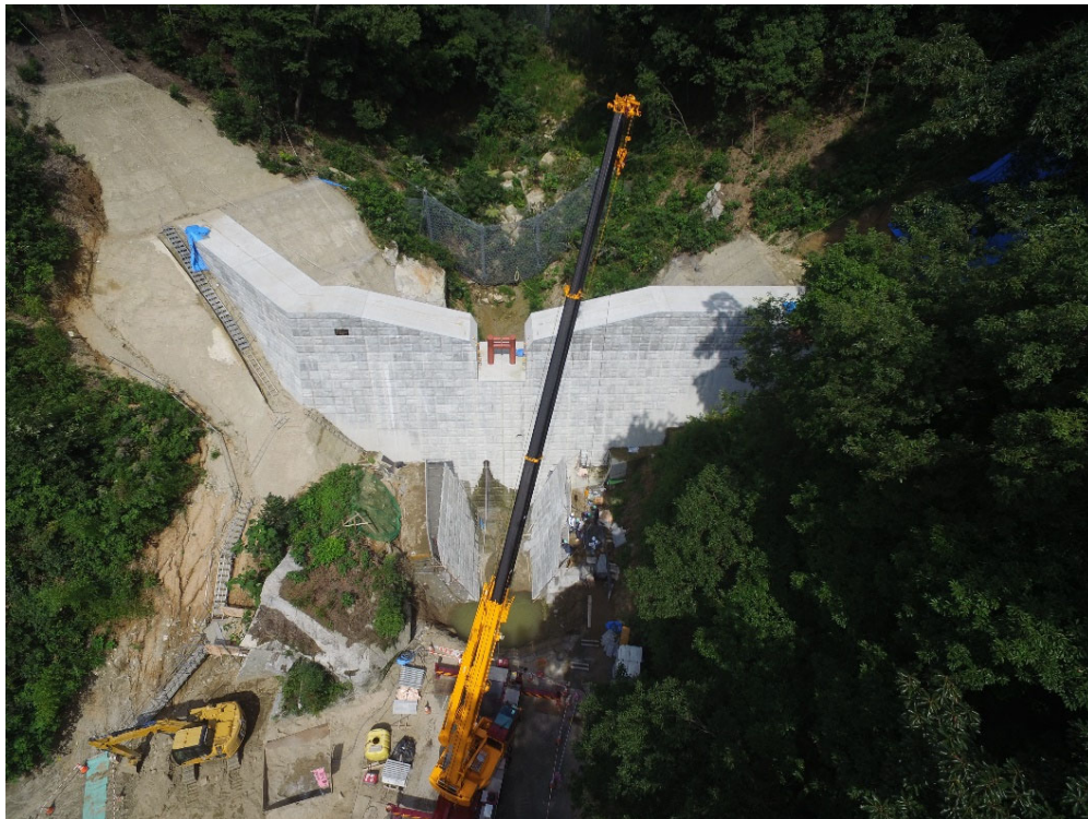
砂防堰堤全景
