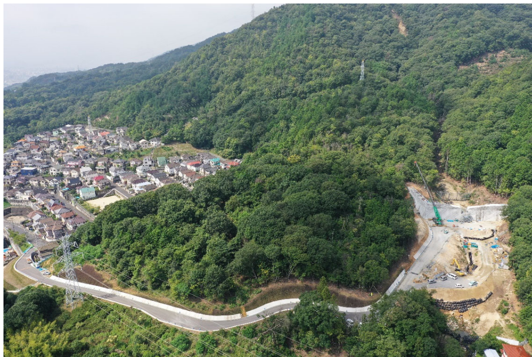
砂防堰堤施工状況①
