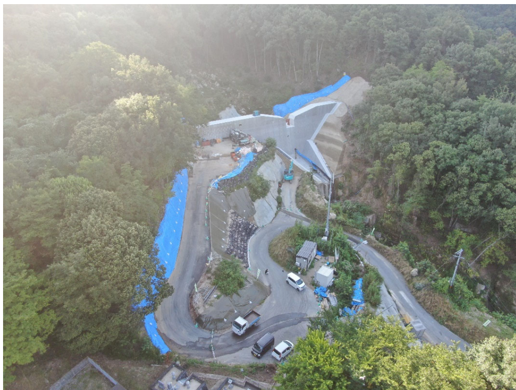
砂防堰堤全景
