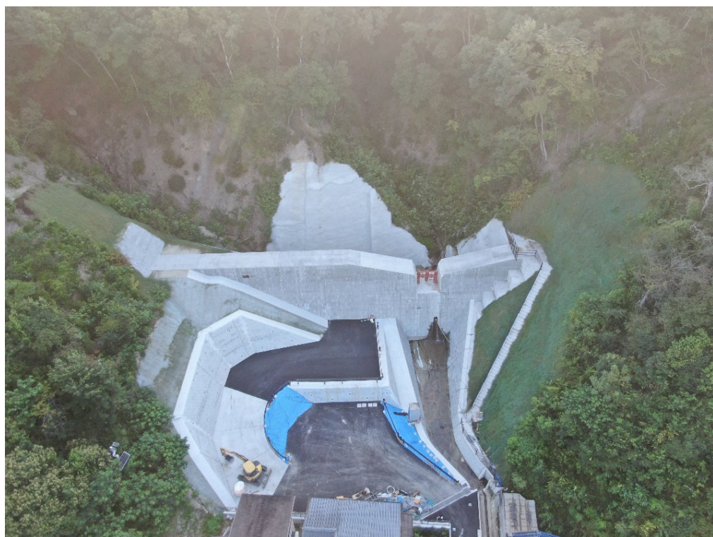
砂防堰堤全景（下流側より）
