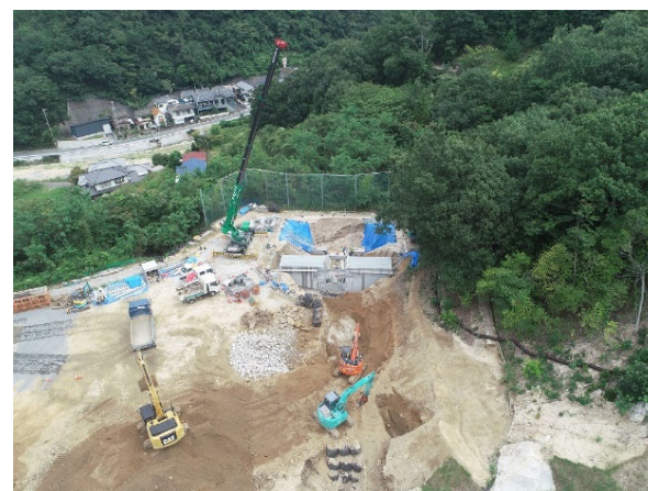
流木捕捉工施工状況（92隣e）
