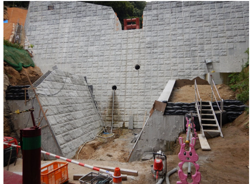
前庭保護工施工状況
