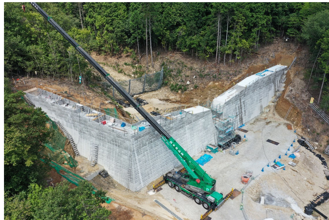
砂防堰堤施工状況②
