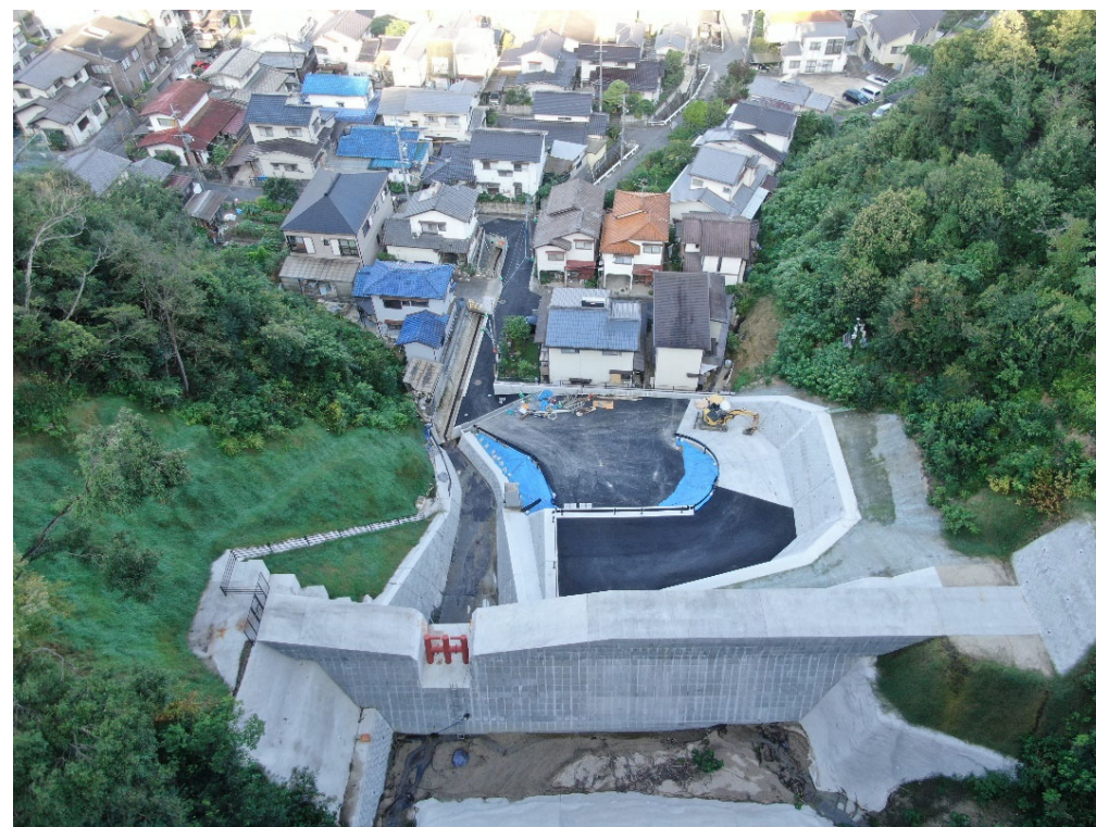
砂防堰堤全景（上流側より）
