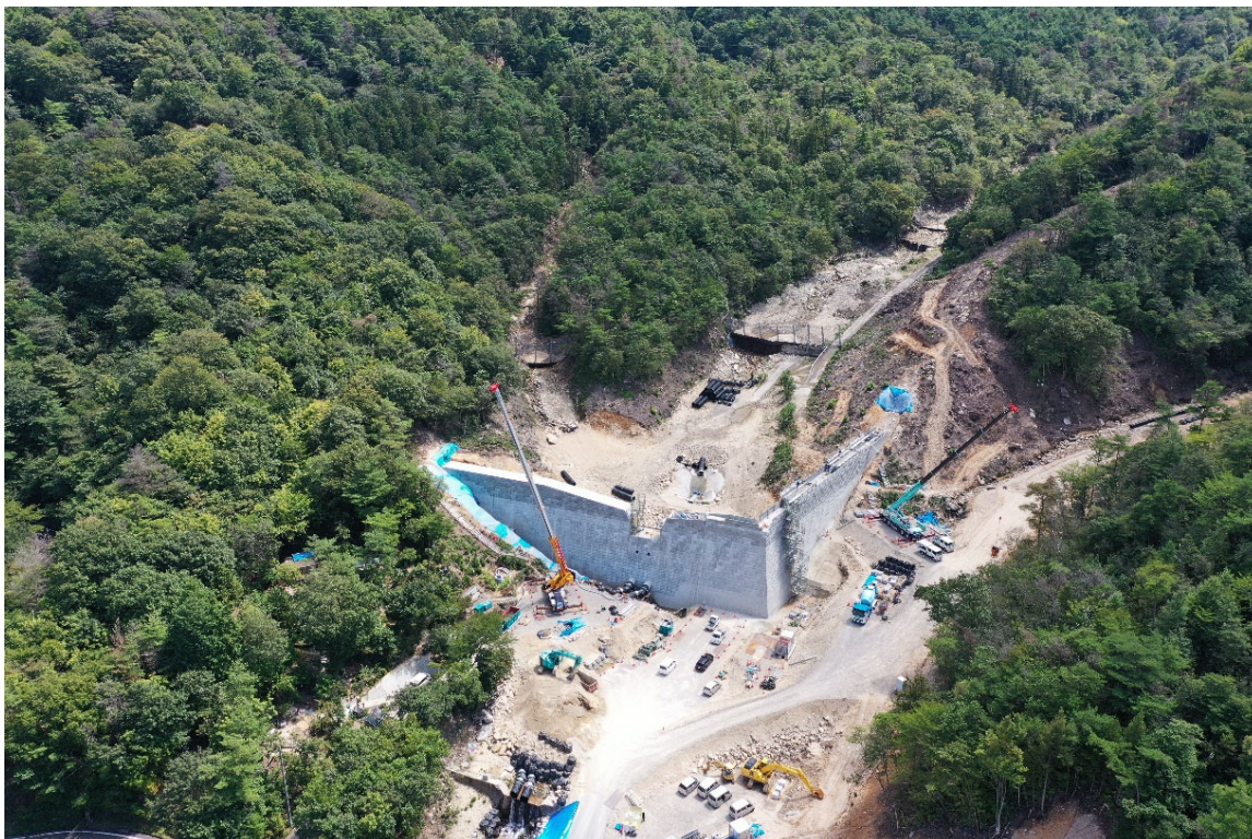
砂防堰堤施工状況 (全景)
