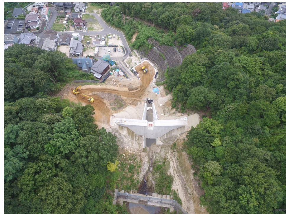
砂防堰堤全景（上流側より）
