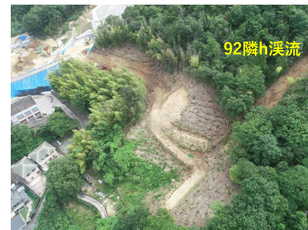
92隣h施工状況
