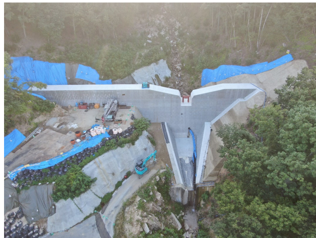
前庭保護工施工状況
