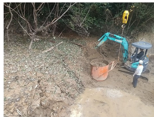
【土砂を掘削しホッパーへの積み込み状況】
