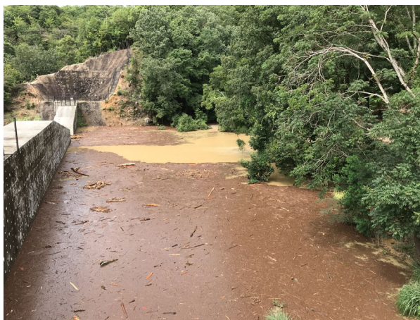
土石流発生直後（R3.8.15撮影）
