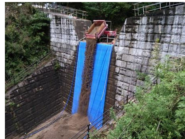
②積み込んだ土砂を下へ落とす
