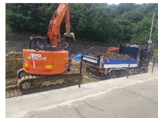
【ダンプへの積込状況】
