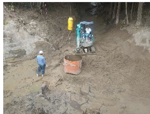
【ホッパーへの積込状況】
