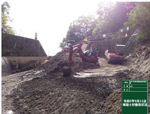
①土砂集積・積み込み状況
