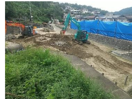
【巨石の破碎状況】
