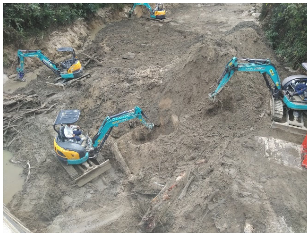
【土砂集積状況】
