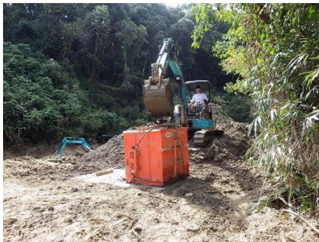
【土砂積込状況】
