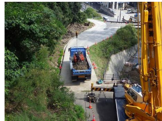
【土砂搬出状況】
