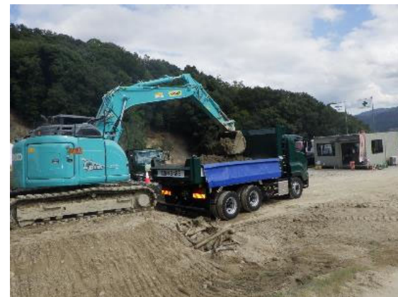
【堰堤から落とした土砂の集積・ダンプ搬出状況】
