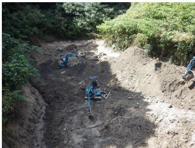
【土砂集積状況】
