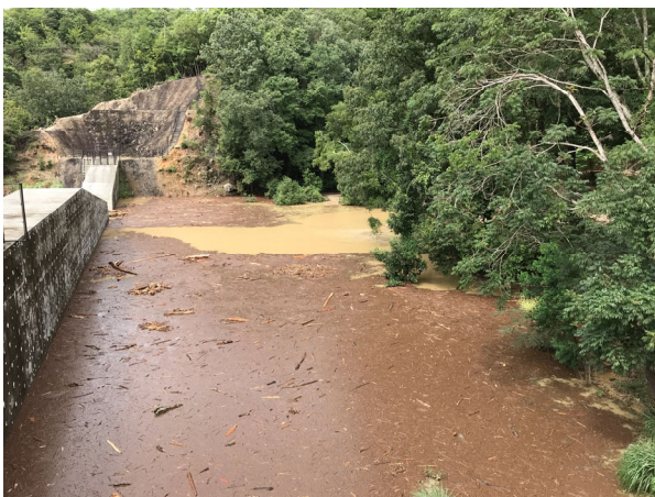
土石流発生直後（R3. 8. 15撮影）
