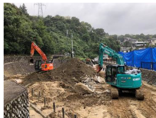
【土砂等集積状況】
