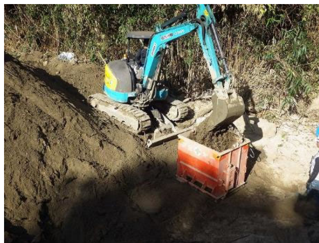
【土砂積込状況】
