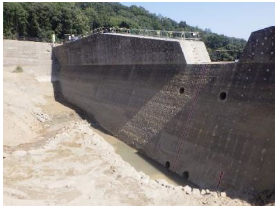
【堰堤上流側の掘削状況】
