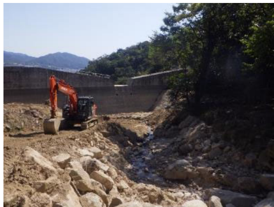
【堰堤上流側の掘削状況】
