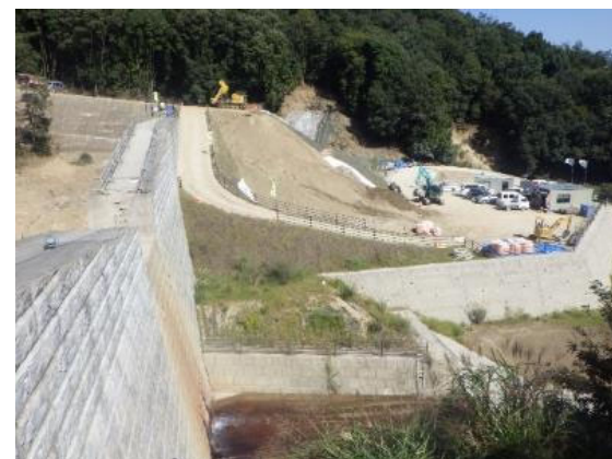
【堰堤から土砂を落としている状況】
