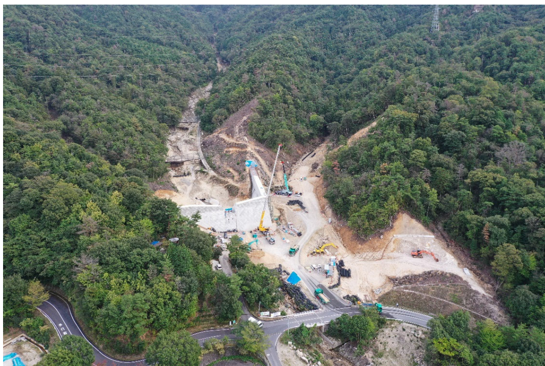
砂防堰堤施工状況 (全景)
