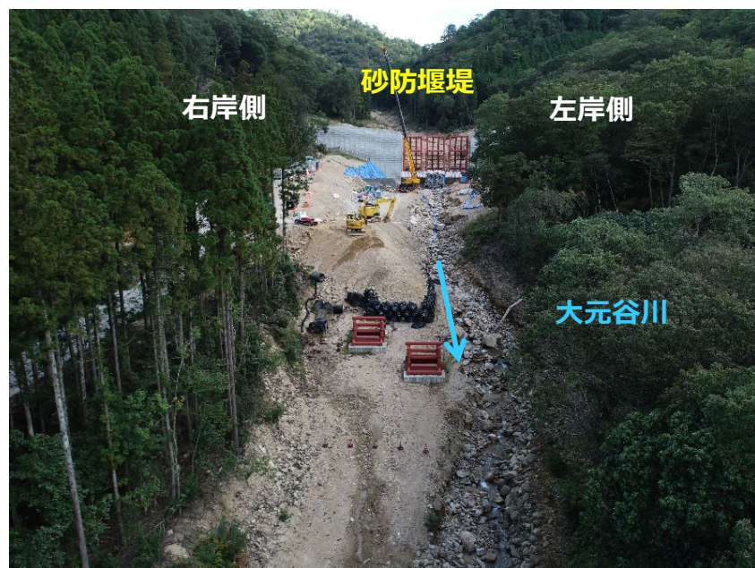
砂防堰堤全景（下流側より）
