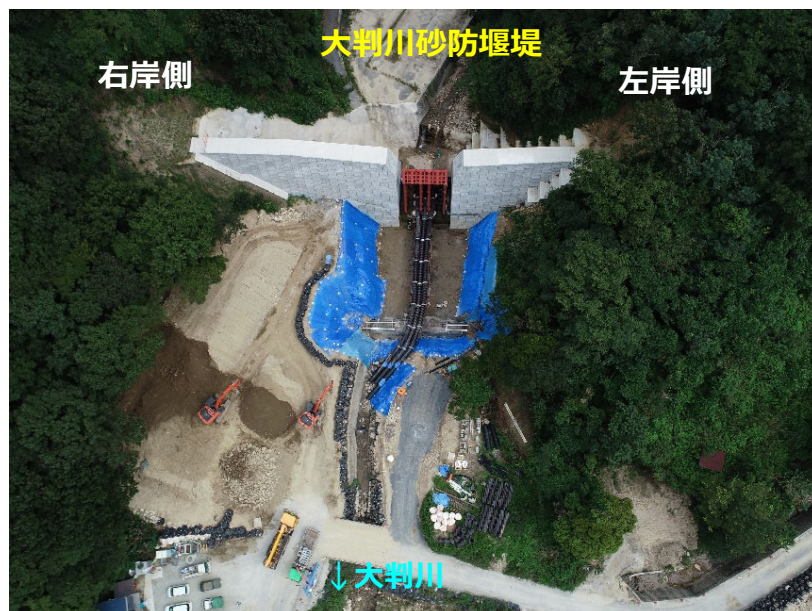
大判川施工状況 (R3.9月末時点)
