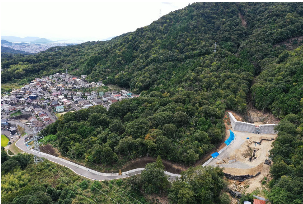
砂防堰堤施工状況①
