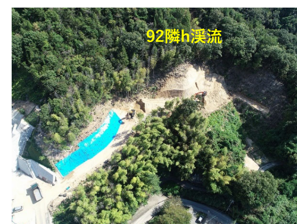
92隣h施工状況
