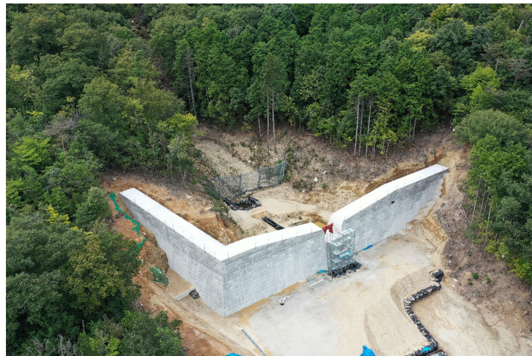
砂防堰堤施工状況②
