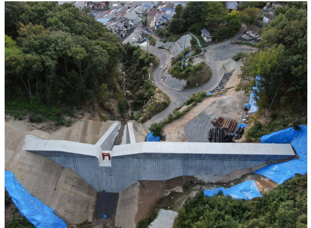
砂防堰堤全景（上流側より）
