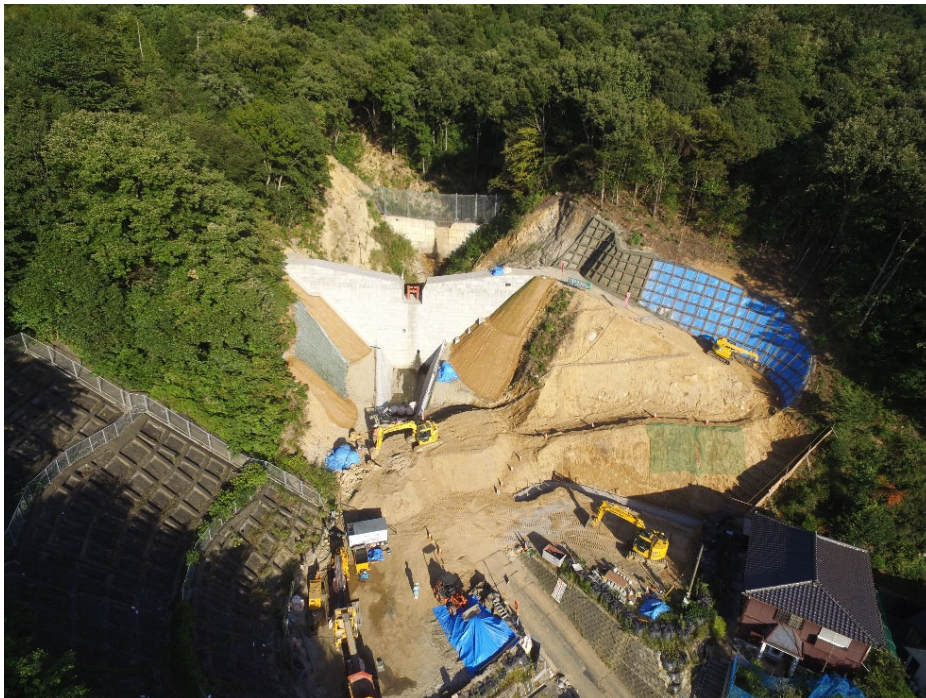
砂防堰堤全景（下流側より）
