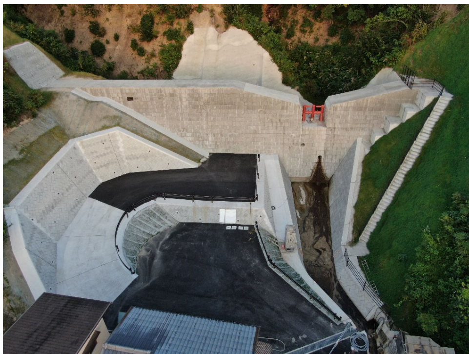
砂防堰堤全景（下流側より）
