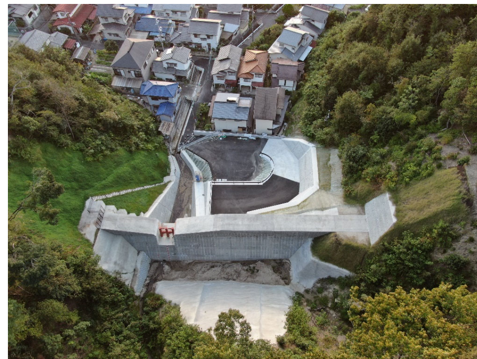
砂防堰堤全景（上流側より）
