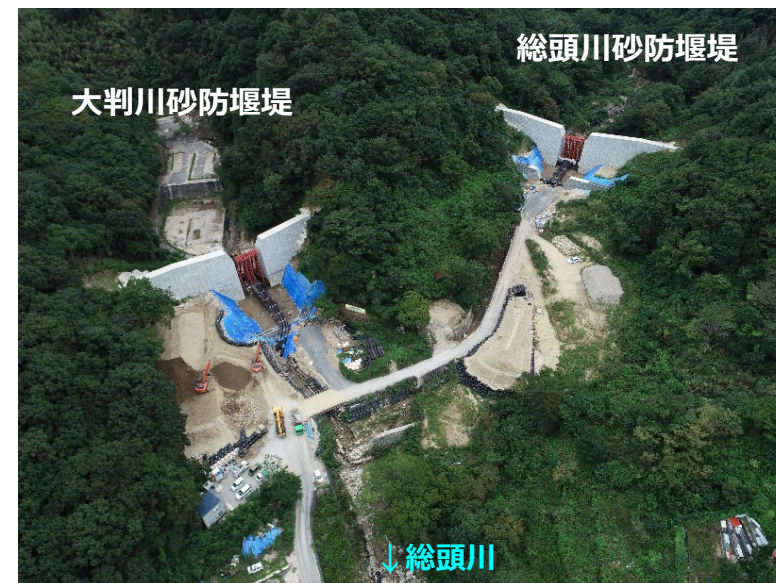
総頭川・大判川施工状況(R3.9月末時点)
