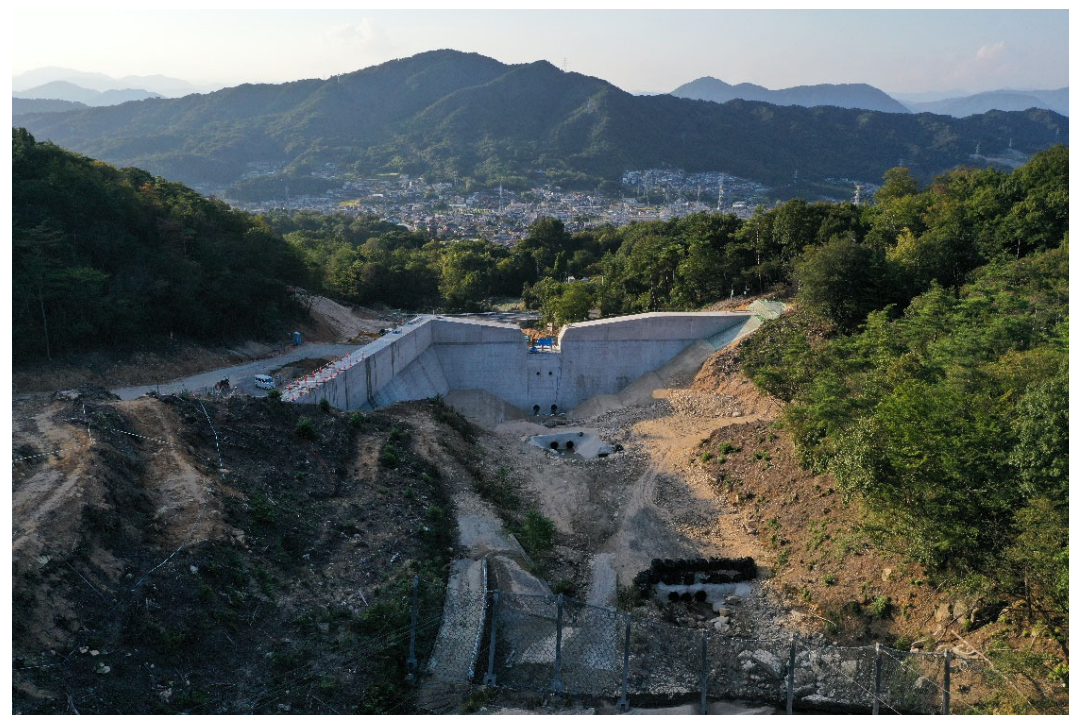
砂防堰堤施工状況 (上流側より)
