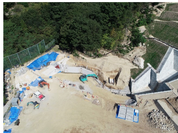
92隣e施工状況
