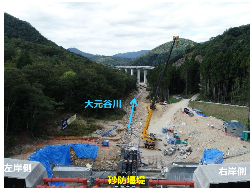
工事状況（上流側より）
