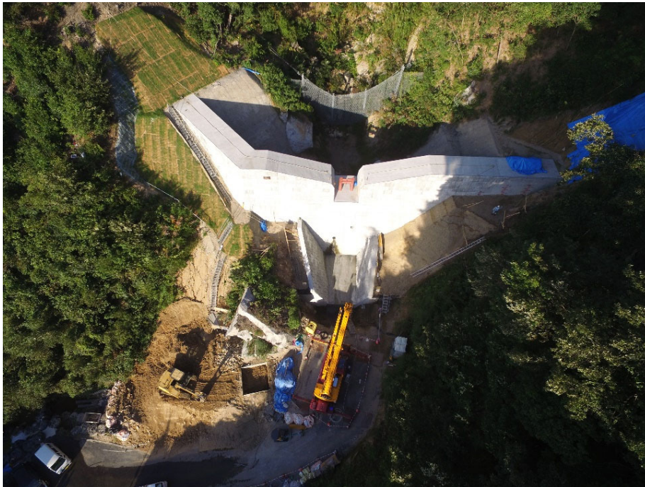
砂防堰堤全景
