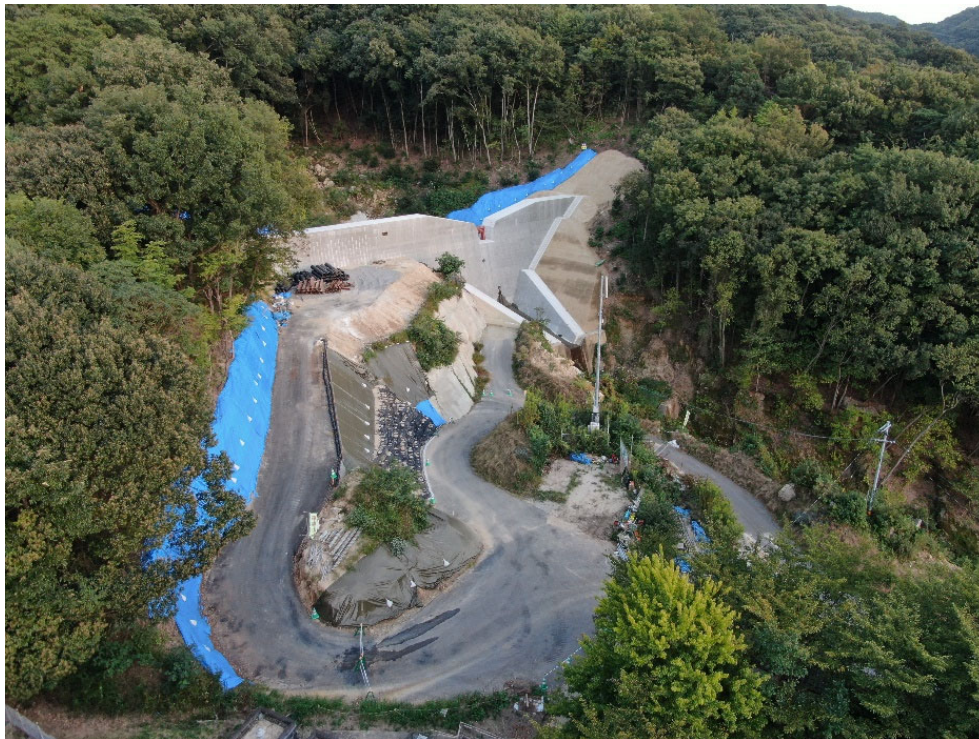
砂防堰堤全景（下流側より）
