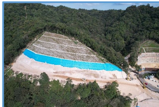
施工中（9月30日時点）
