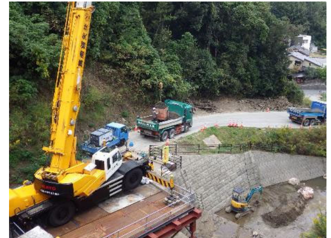
【土砂搬出状況】
