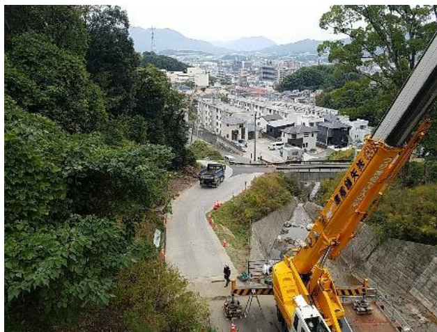
【土砂搬出状況】
