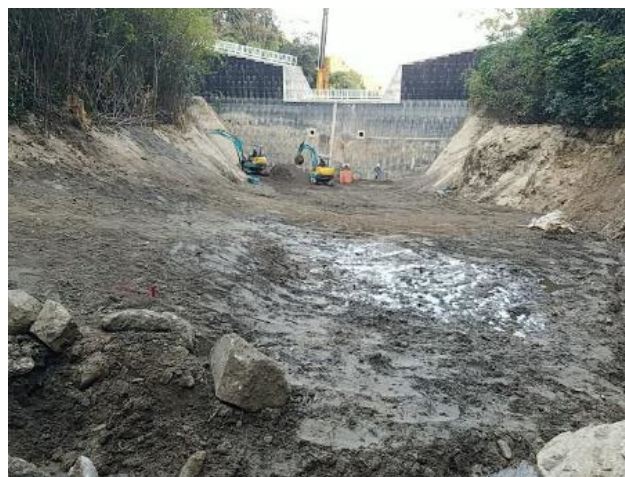
【掘削完了全景】
