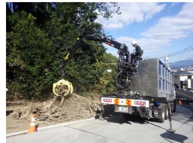
【流木搬出状況】
