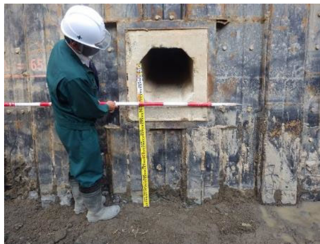
【掘削確認状況】
