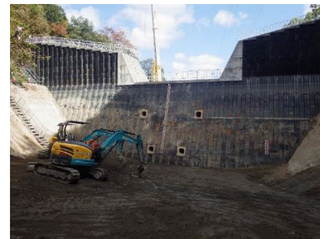
【掘削完了全景】
