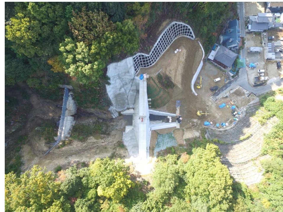
砂防堰堤全景
