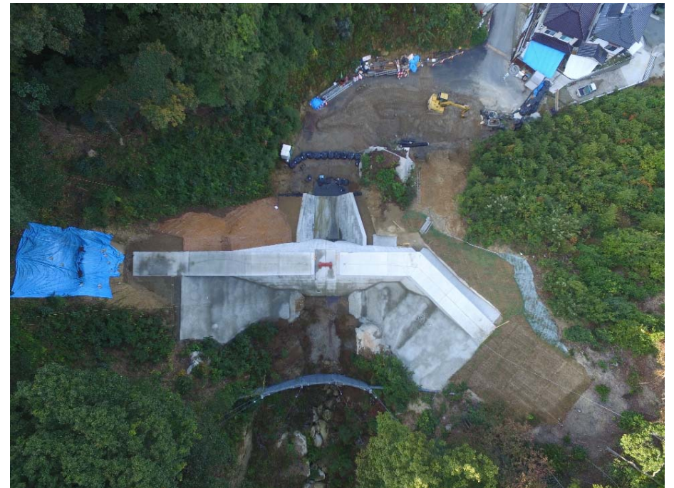
砂防堰堤全景
