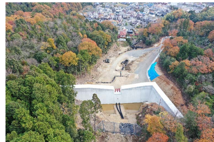
砂防堰堤施工状況③
