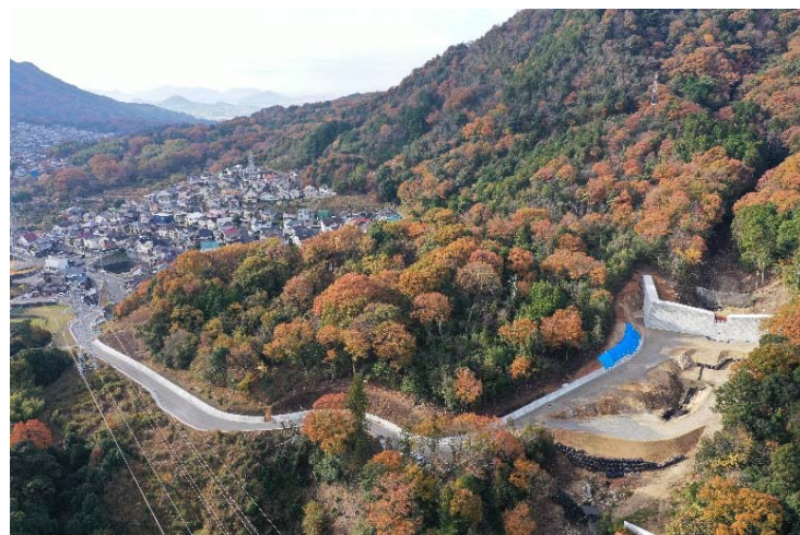
砂防堰堤施工状況①
