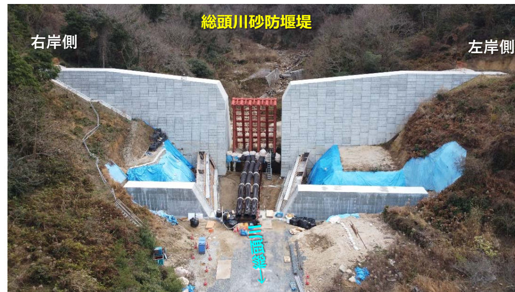
総頭川施工状況 (R3.12月末時点)
