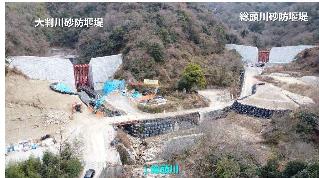
総頭川・大判川施工状況(R3.12月末時点)
