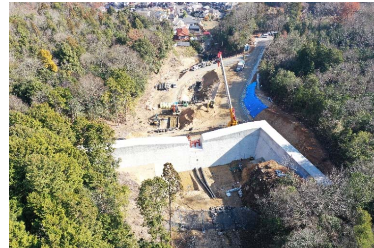
砂防堰堤施工状況③
