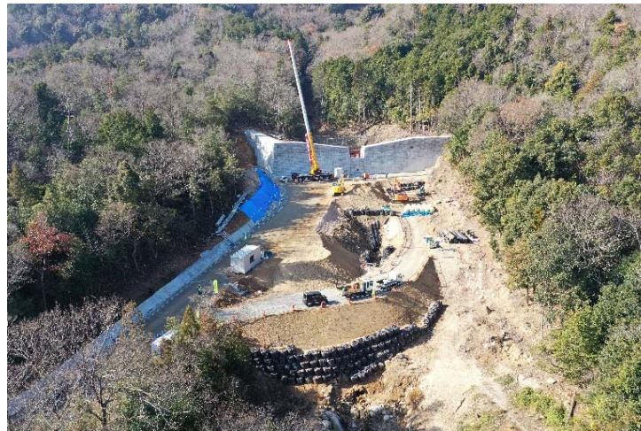
砂防堰堤施工状況②
