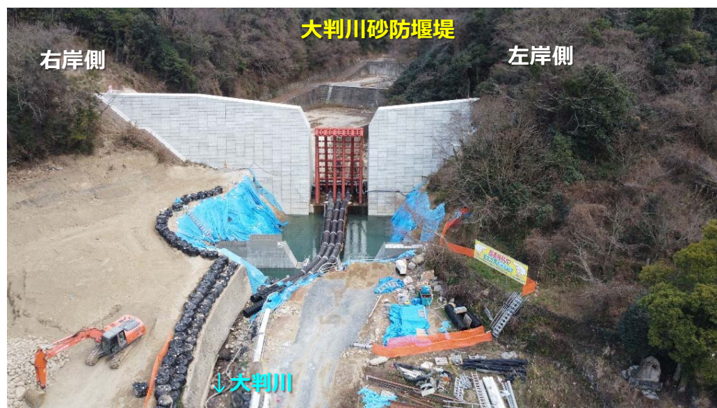
大判川施工状況 (R3.12月末時点)
