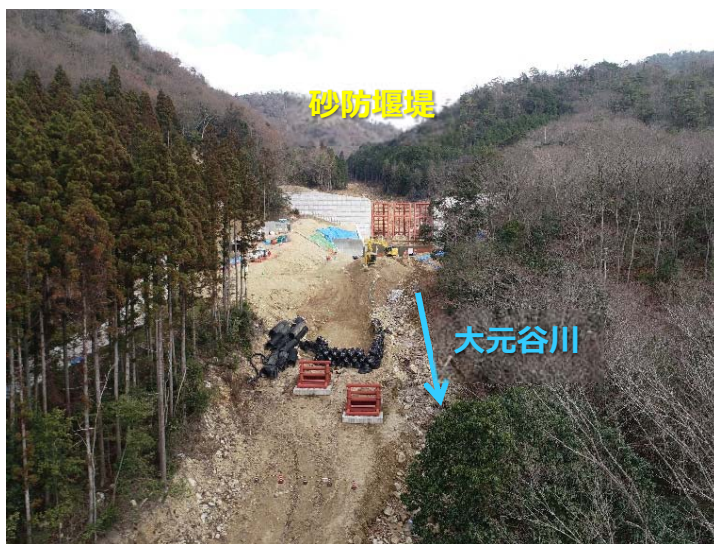
砂防堰堤全景（下流側より）
