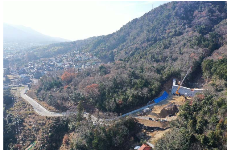
砂防堰堤施工状況①
