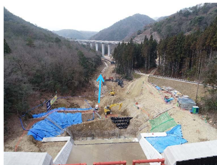
砂防堰堤全景（上流側より）
