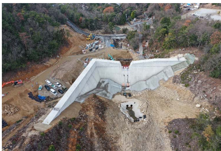
砂防堰堤施工状況
