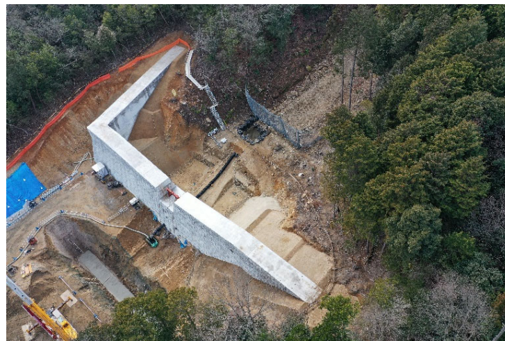
砂防堰堤施工状況②
