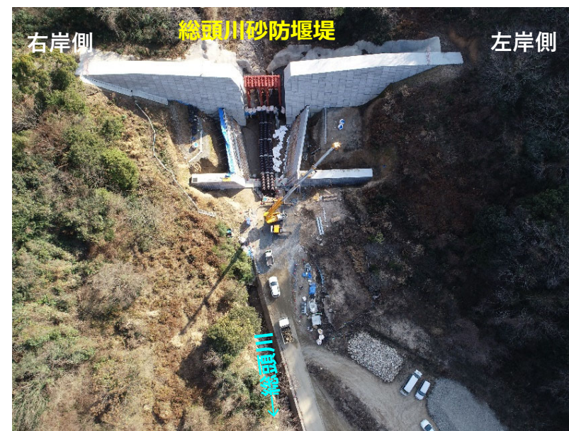
総頭川施工状況 (R4.1月末時点)
