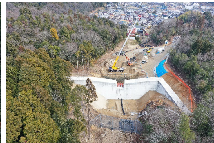
砂防堰堤施工状況③
