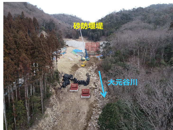
砂防堰堤全景（下流側より）
