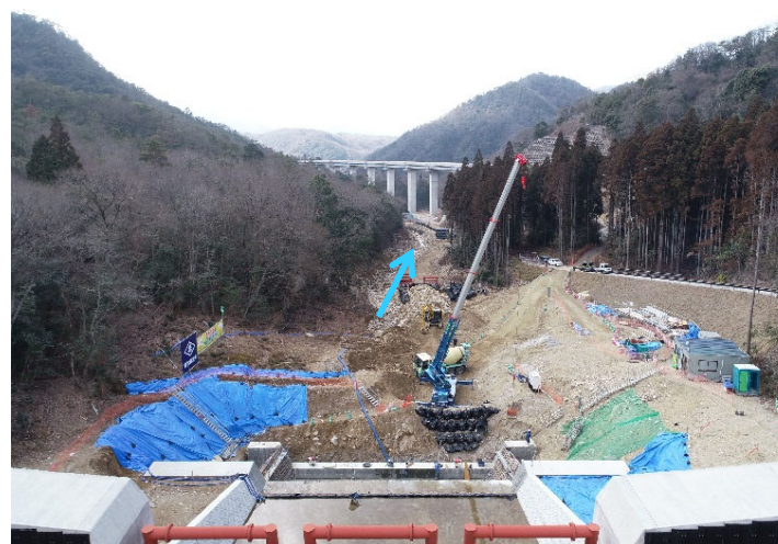
砂防堰堤全景（上流側より）
