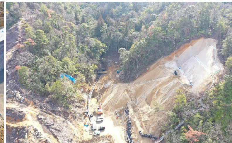
管理用道路施工状況
