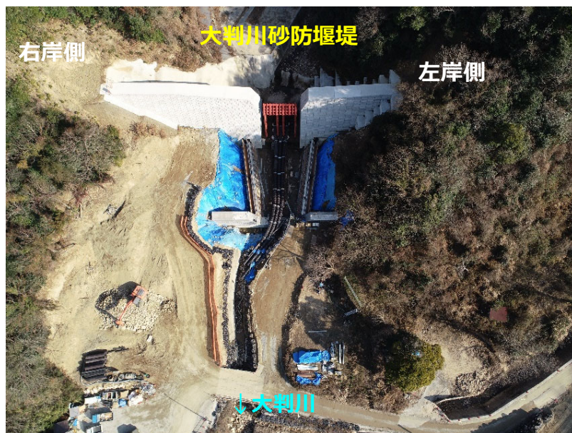
大判川施工状況 (R4.1月末時点)
