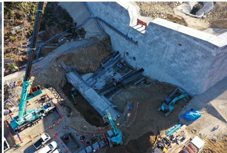
前庭保護工施工状況
