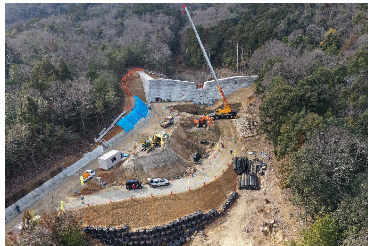
砂防堰堤施工状況①
