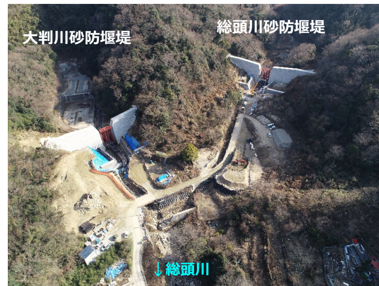
総頭川・大判川施工状況(R4.1月末時点)
