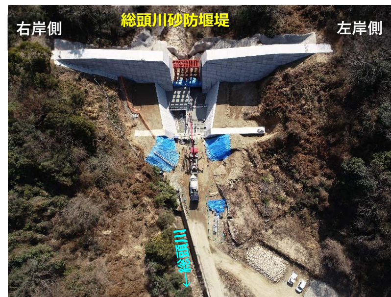
総頭川施工状況 (R4.2月末時点)
