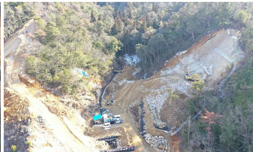
管理用道路施工状況
