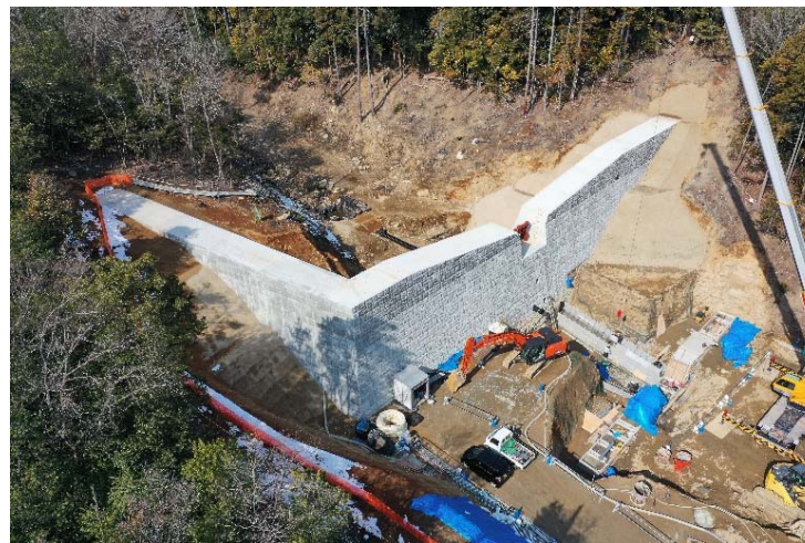
砂防堰堤施工状況②
