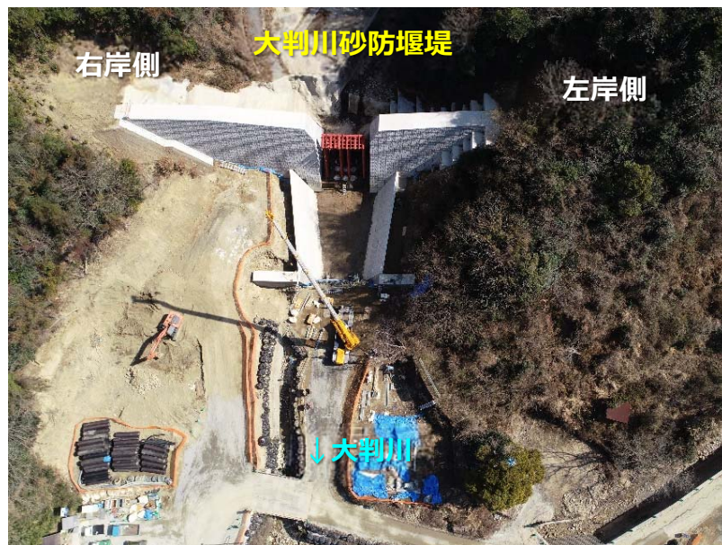
大判川施工状況 (R4.2月末時点)
