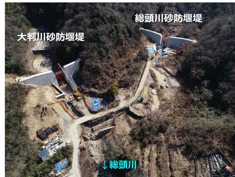
総頭川・大判川施工状況(R4.2月末時点)
