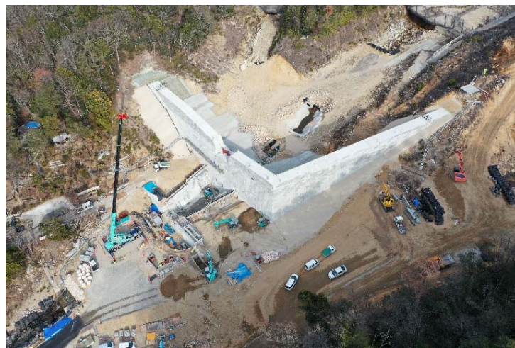
前庭保護工施工状況
