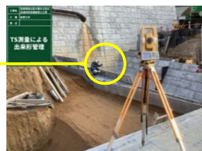
【構造物TS測量状況】
