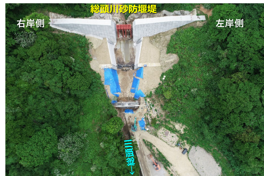
総頭川施工状況 (R4.5月末時点)
