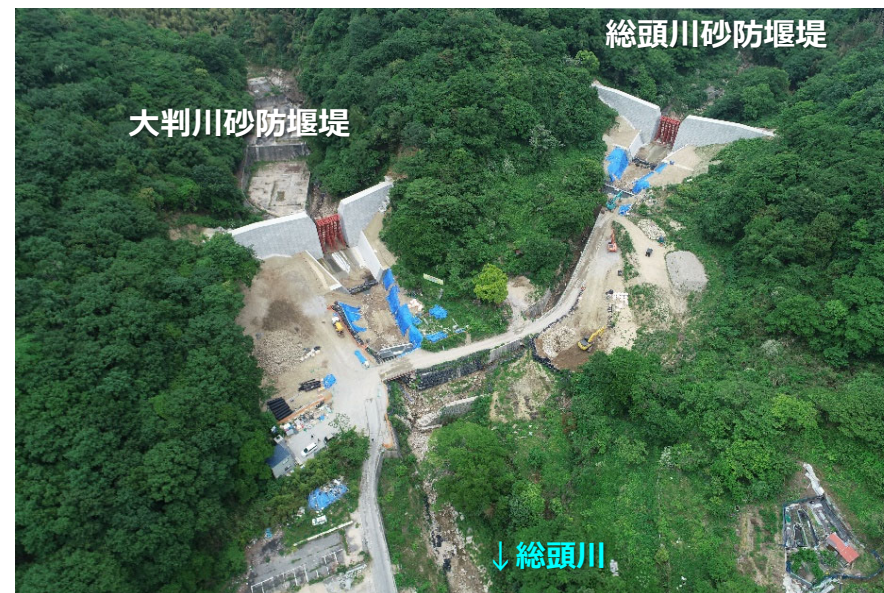
総頭川・大判川施工状況(R4.5月末時点)
