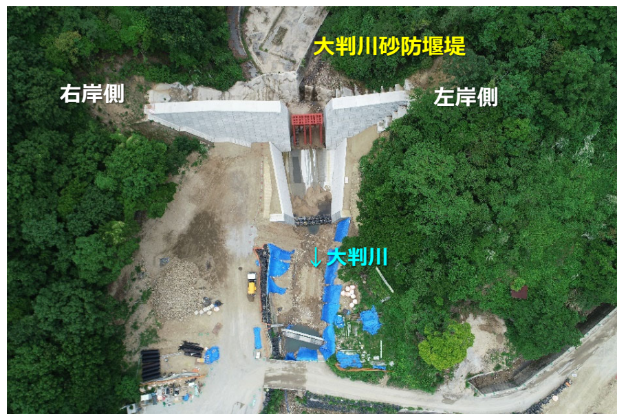
大判川施工状況 (R4.5月末時点)
