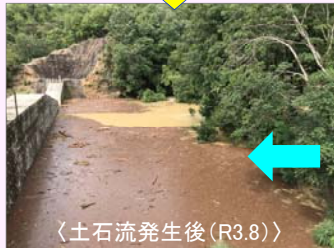
〈土石流発生後(R3.8)〉
