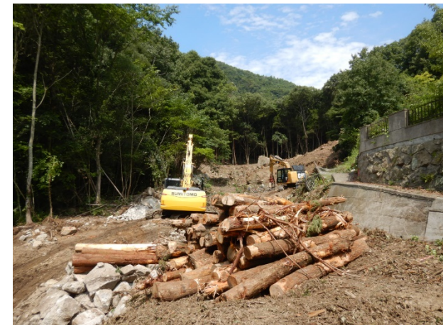
伐採の施工状況
