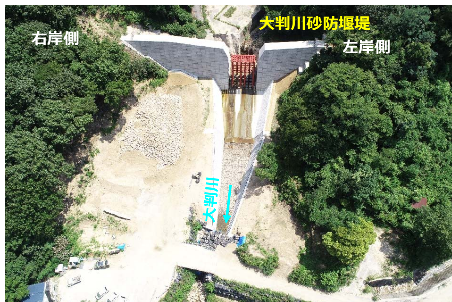
大判川施工状況 (R4.8月末時点)
