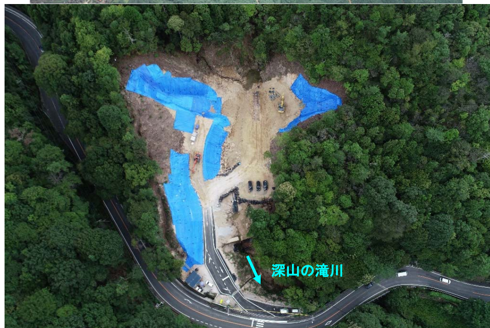
深山の滝川溪流下流施工状況(R4.8月末時点)
