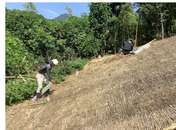
境界杭 施工状況
