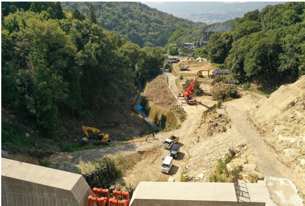
(堰堤上流より)
