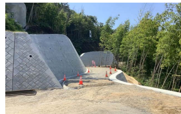
92隣h溪流 管理用道路の施工状況
