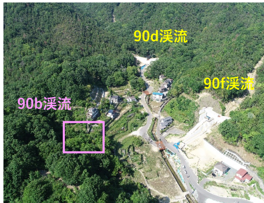
砂防堰堤全景（90b、90d、90f溪流）
