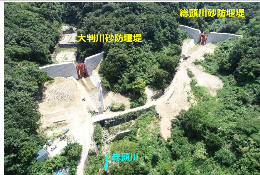
総頭川・大判川施工状況(R4.8月末時点)
