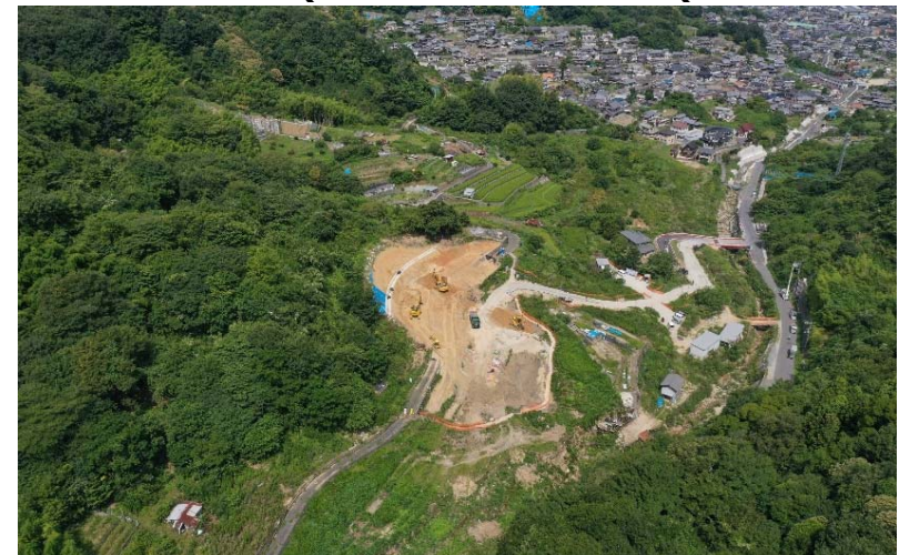
総頭川施工状況(上流から下流を望む) (R4.8月末時点)
