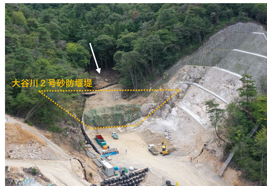
大谷川 2号砂防堰堤 施工状況 (掘削・床堀完了)
