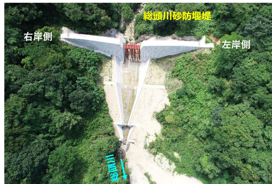
総頭川施工状況 (R4.8月末時点)
