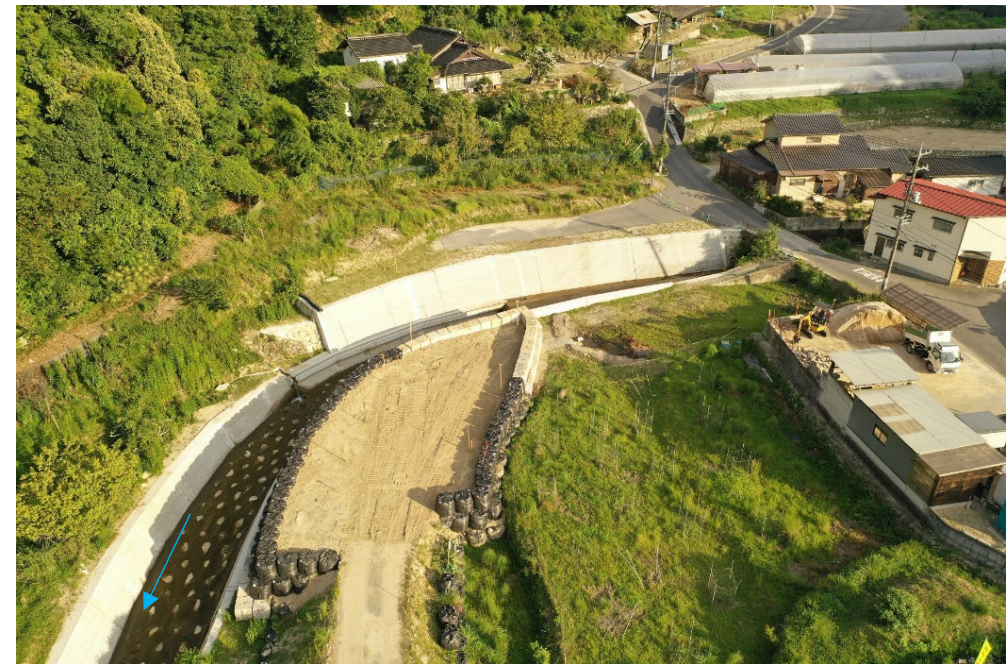
(工事用の仮橋設置箇所)
