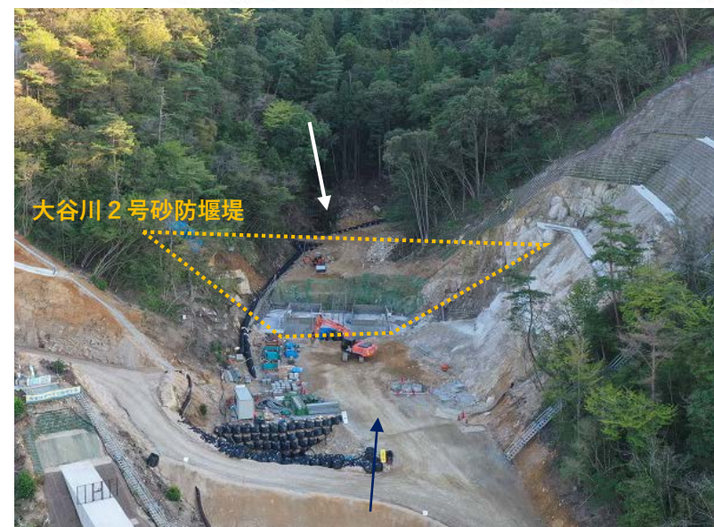
大谷川2号砂防堰堤 施工状況(堰堤本体)
