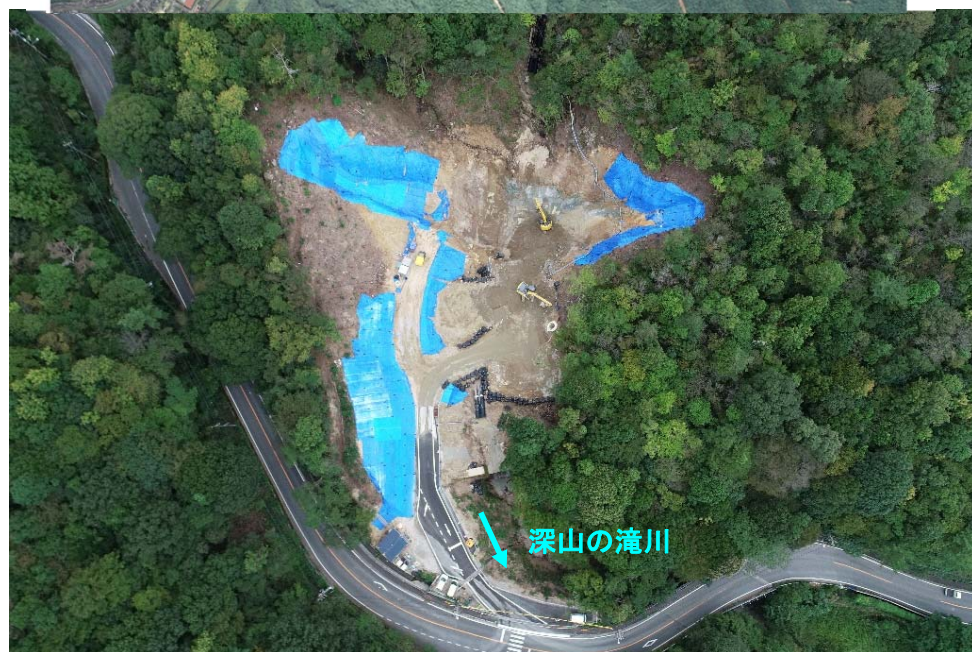
深山の滝川溪流下流施工状況(R4.9月末時点)
