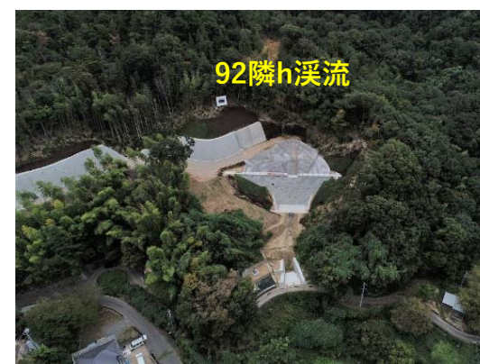
92隣h溪流 施工状況
