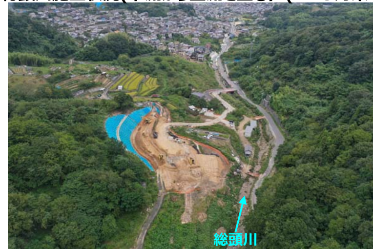
総頭川施工状況(上流から下流を望む) (R4.9月末時点)
