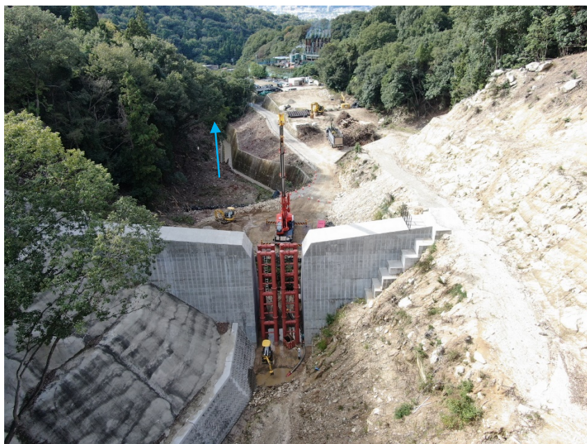
(堰堤上流より)
