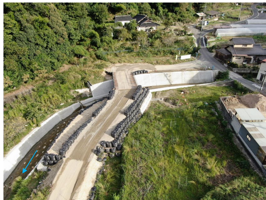
(工事用の仮橋設置箇所)
