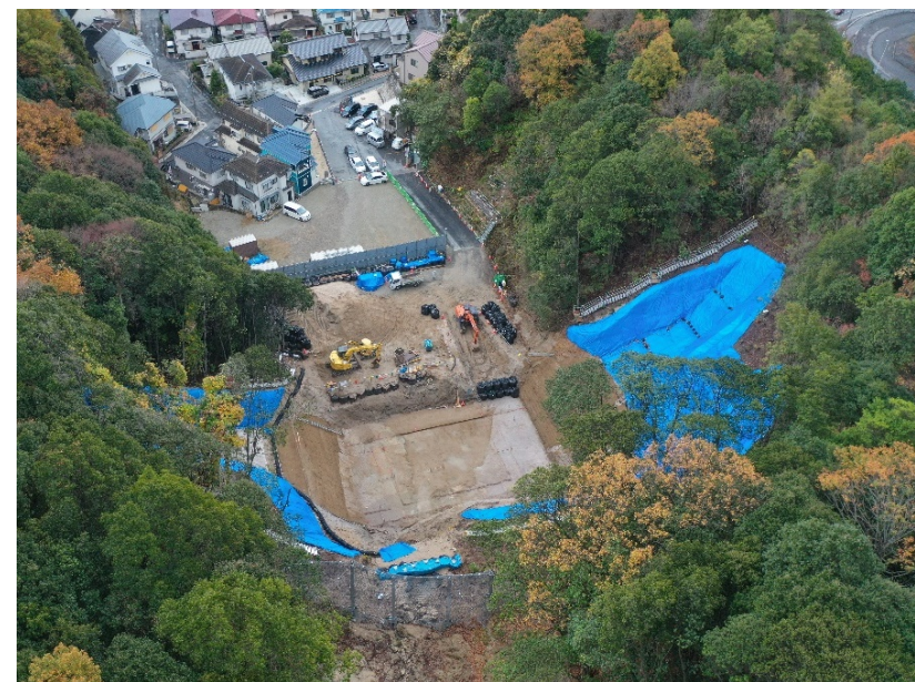
【施工状況（上流側より）】
