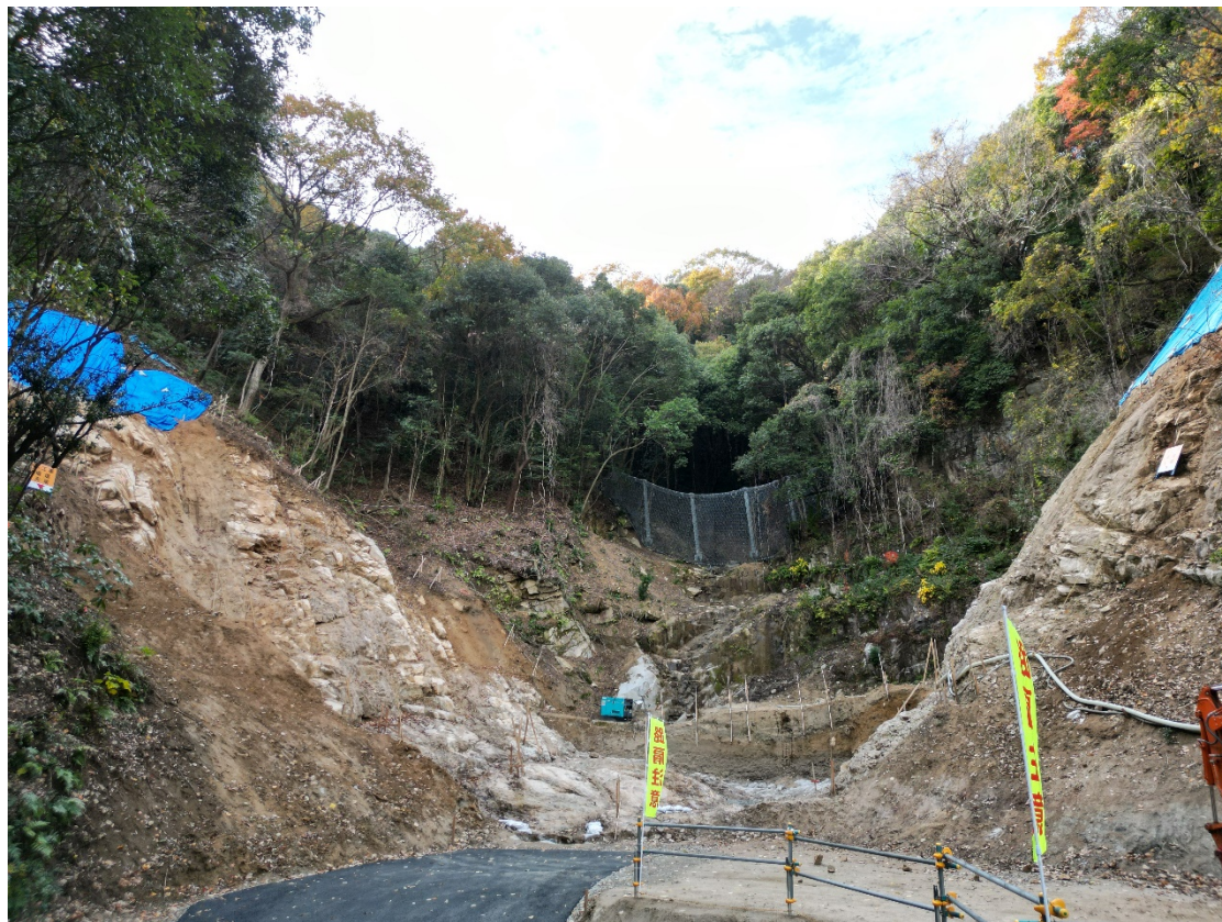
【施工状況（下流側より）】
