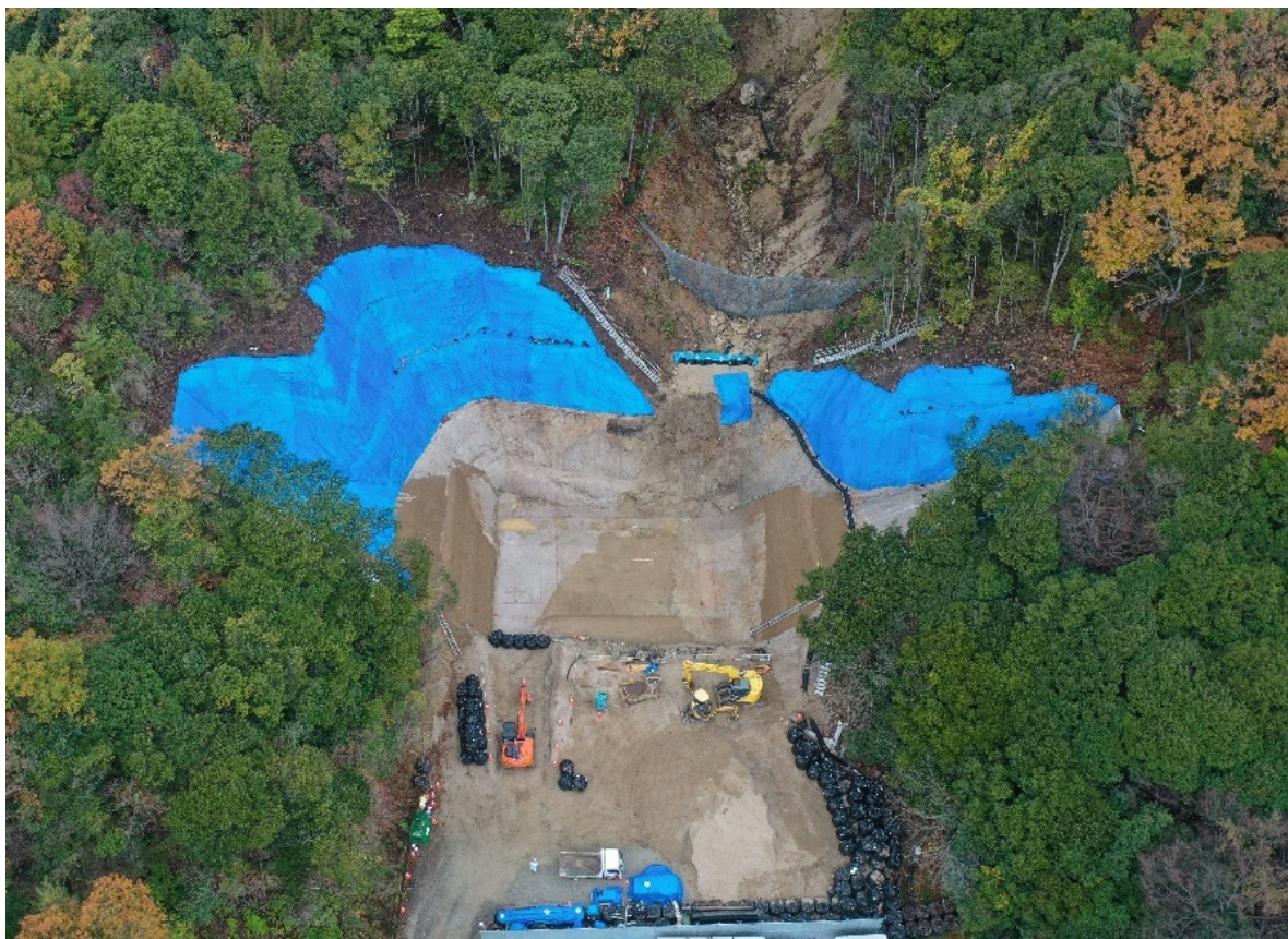
【施工状況（下流側より）】
