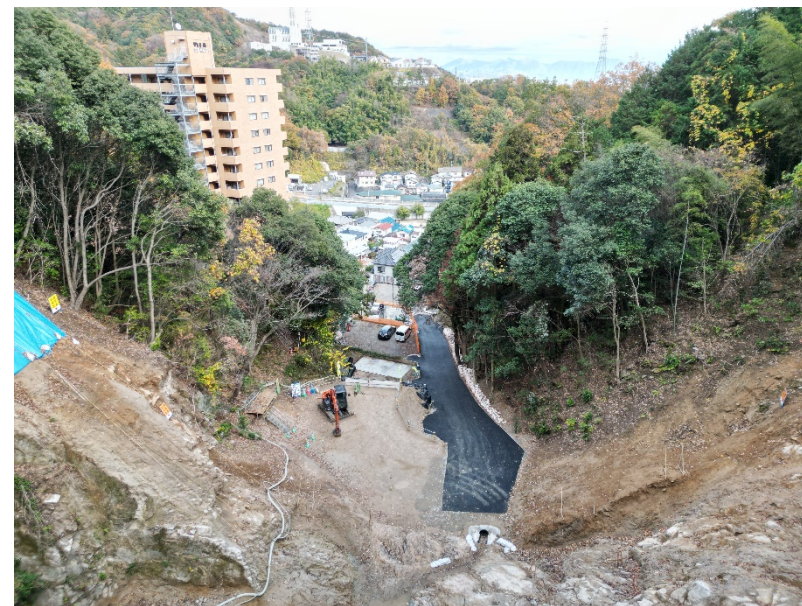
【施工箇所（上流側より）】
