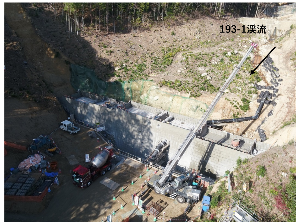
【施工状況（砂防堰堤）】
