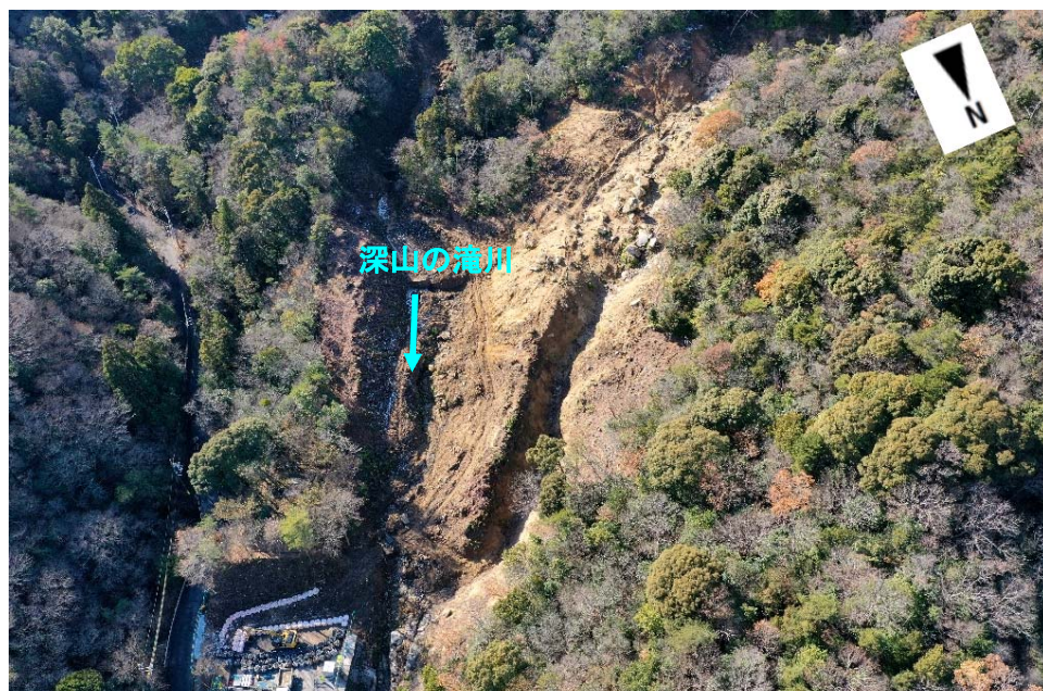
【深山の滝川溪流上流の施工状況】
