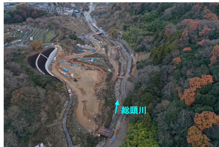
【施工状況（上流から下流を望む）（R4. 12月末時点）】
