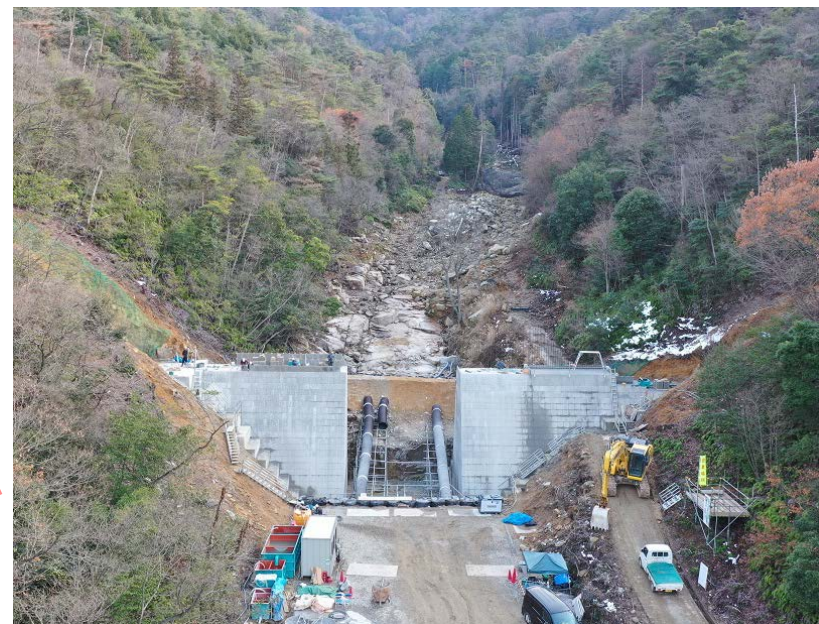
【大谷川3号砂防堰堤 施工状況 (堰堤本体)】
