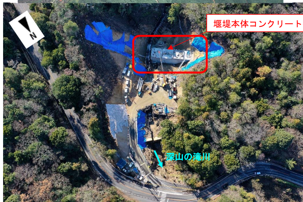
【深山の滝川溪流下流の施工状況】
