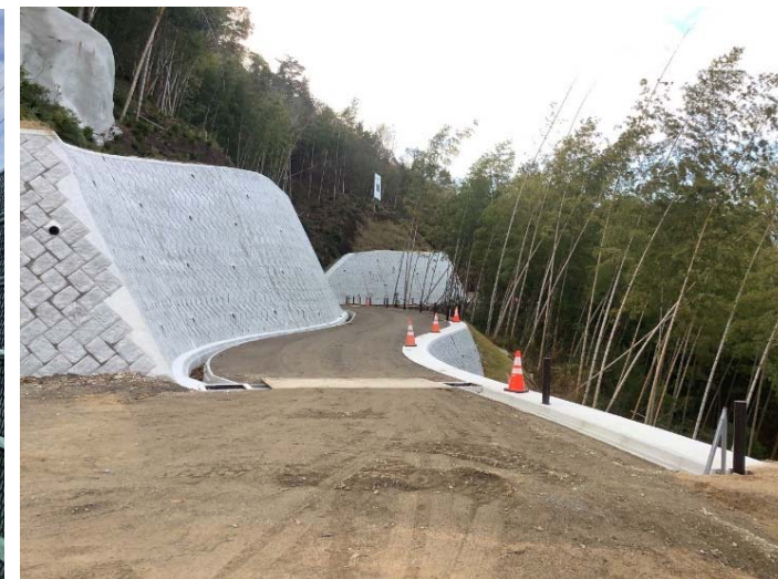
92隣h溪流 管理用道路 施工状況
