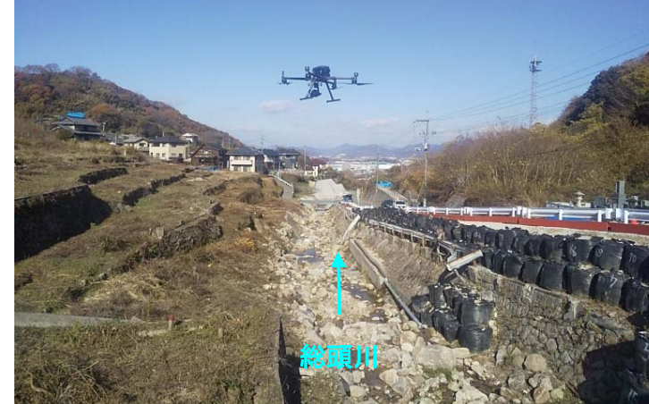
ドローンによる3次元起工測量
