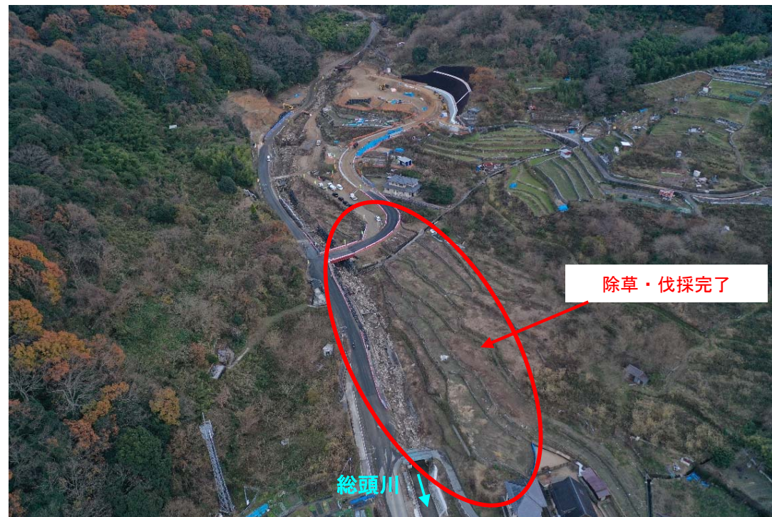
【施工状況（下流から上流を望む）（R4. 12月末時点）】
