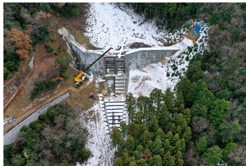
【上原1号砂防堰堤 施工状況 (側壁)】
