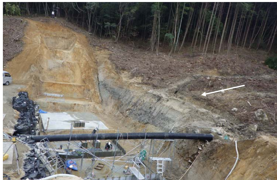
【施工状況（掘削完了）】
