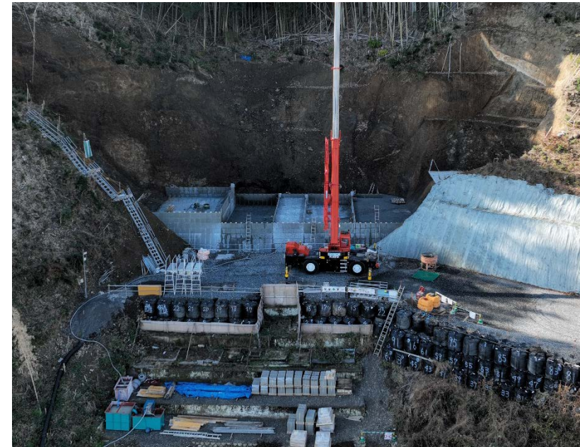
【施工状況（下流側より）】
