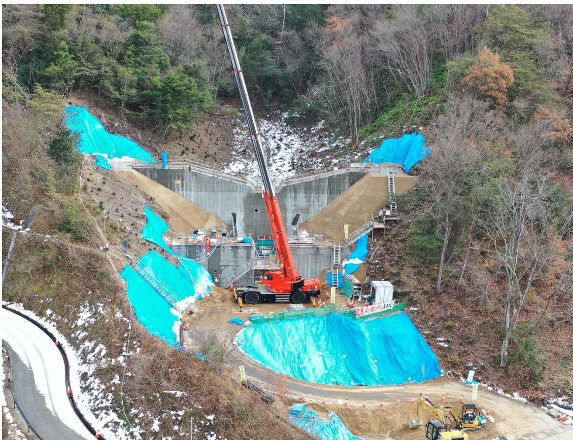
【五月が丘8号砂防堰堤 施工状況】
