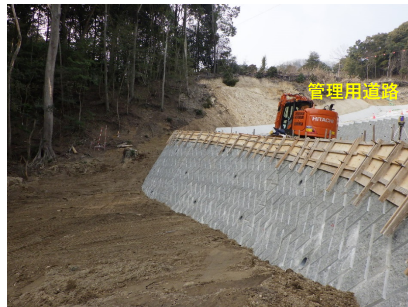
【施工状況（管理用道路）】
