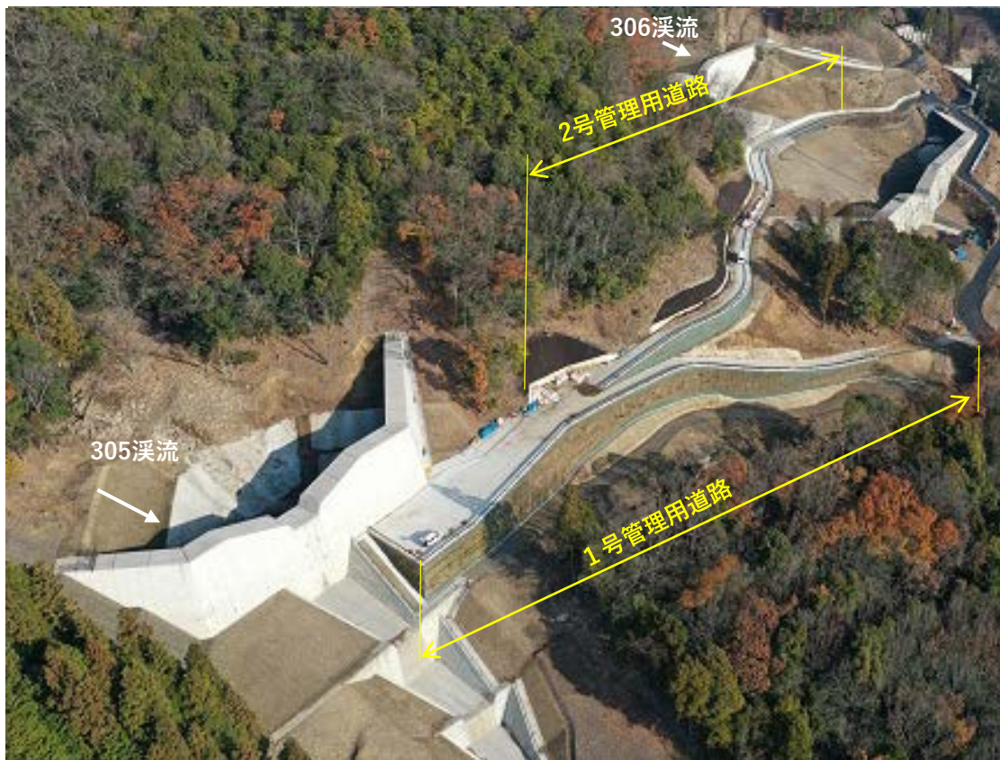
【 施工状況（紫野采砂防堰堤付近の管理用道路）】
