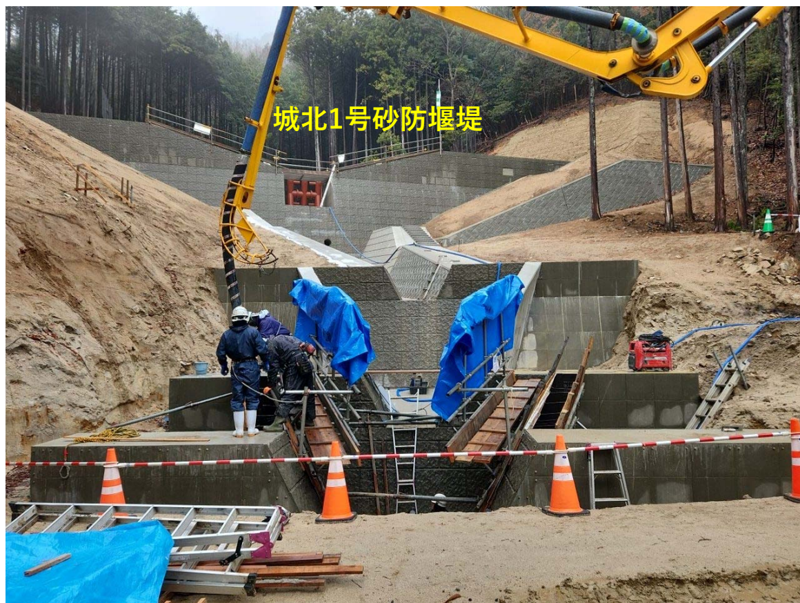
【城北1号砂防堰堤 施工状況（流路工）】
