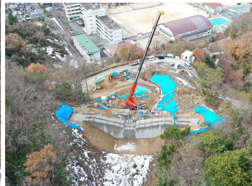
【砂防堰堤 施工箇所(上流側より)】
