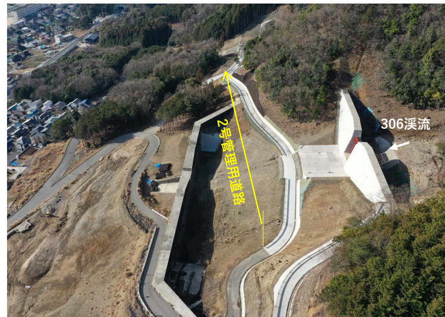
【 施工状況 ( 管理用道路) 】
