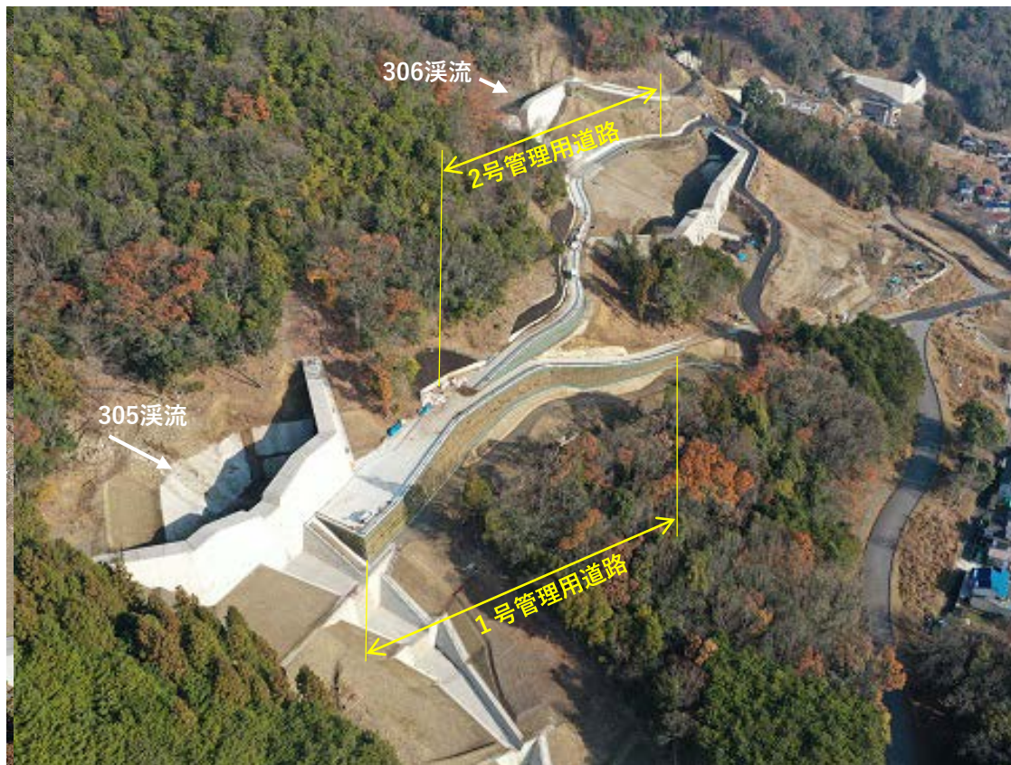
【 施工状況 ( 紫野采砂防堰堤付近の管理用道路) 】
