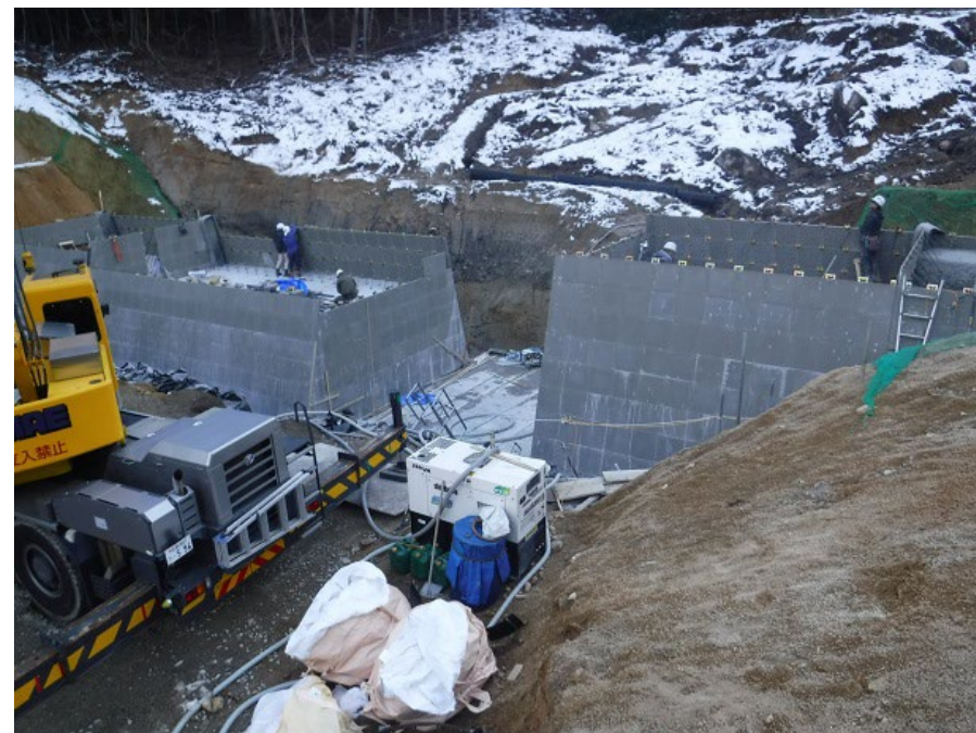
【施工状況（砂防堰堤）】
