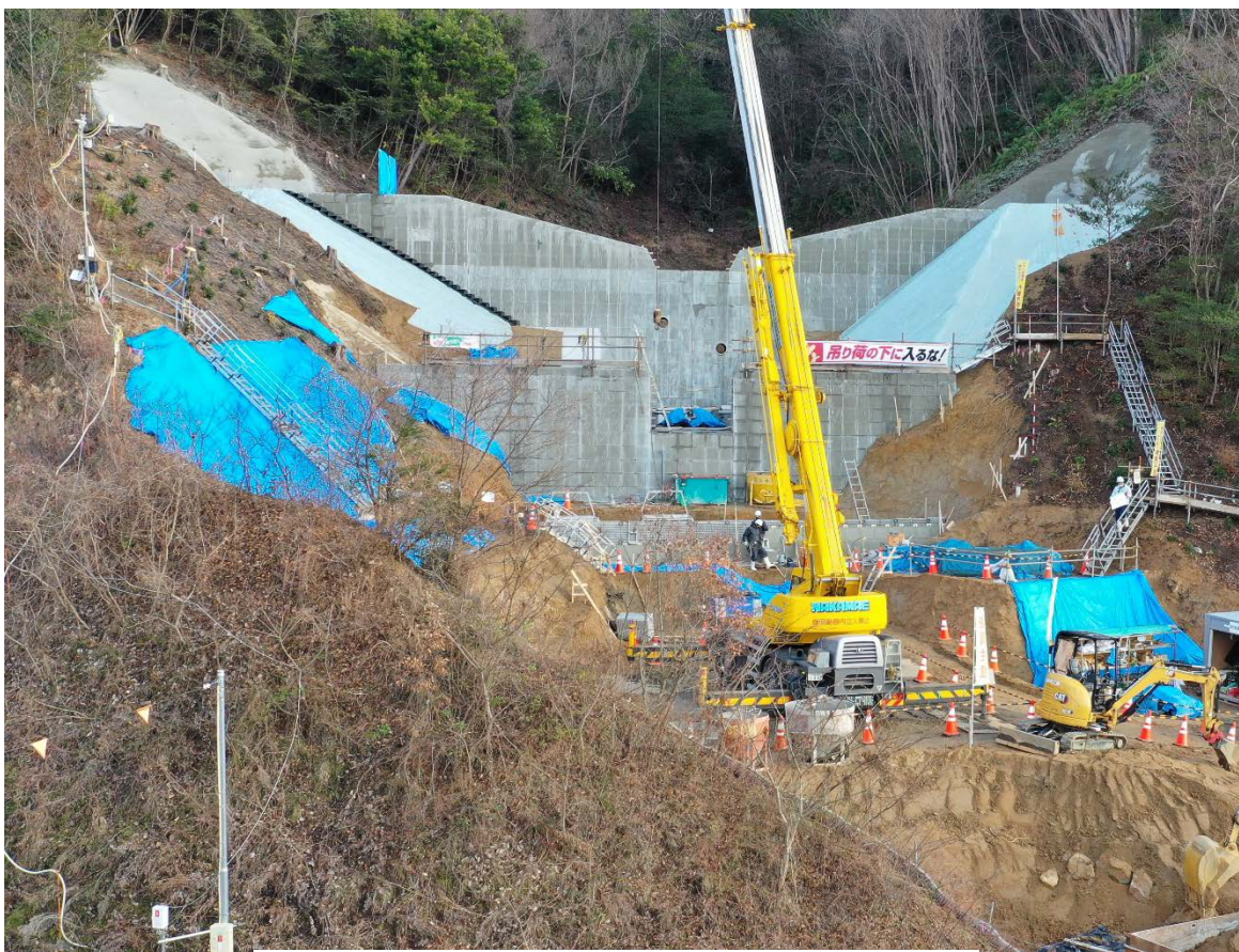
【五月が丘8号砂防堰堤 施工状況】
