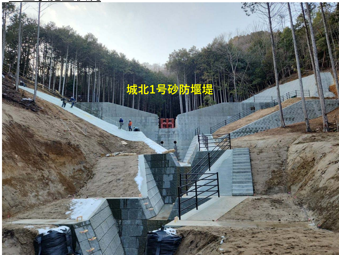
【城北1号砂防堰堤 施工状況（流路工）】
