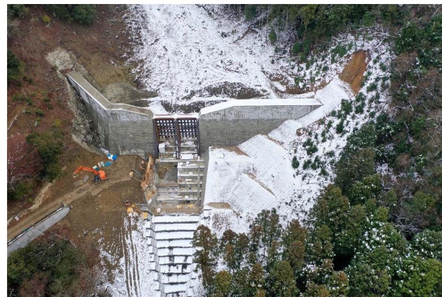
【上原1号砂防堰堤 施工状況 (側壁)】
