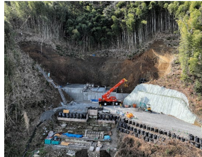
【施工状況（下流側より）】
