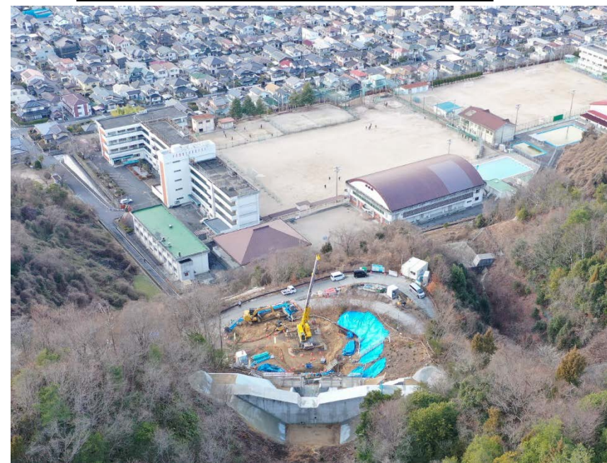
【砂防堰堤 施工箇所（上流側より）】
