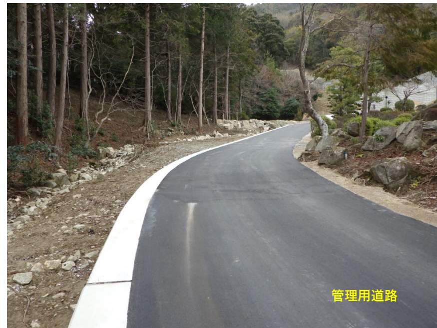
【完成状況 (管理用道路 (舗装後))】
