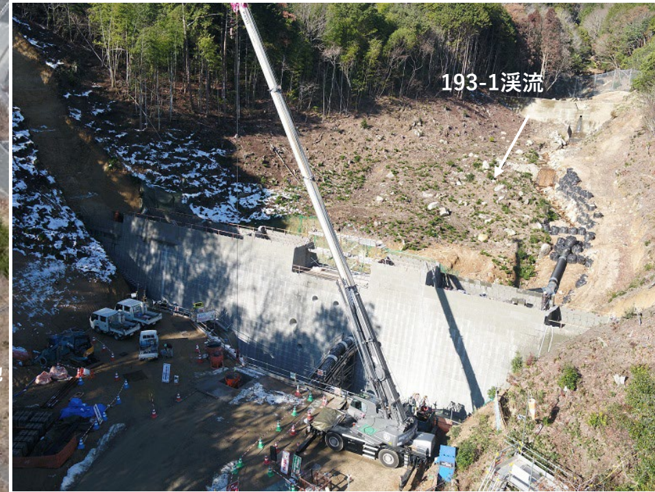
【施工状況 (砂防堰堤)】
