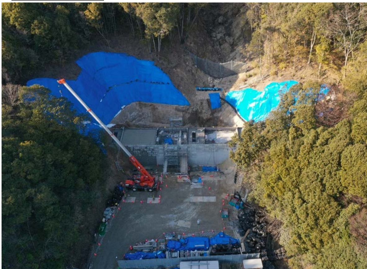
【施工状況（下流側より）】
