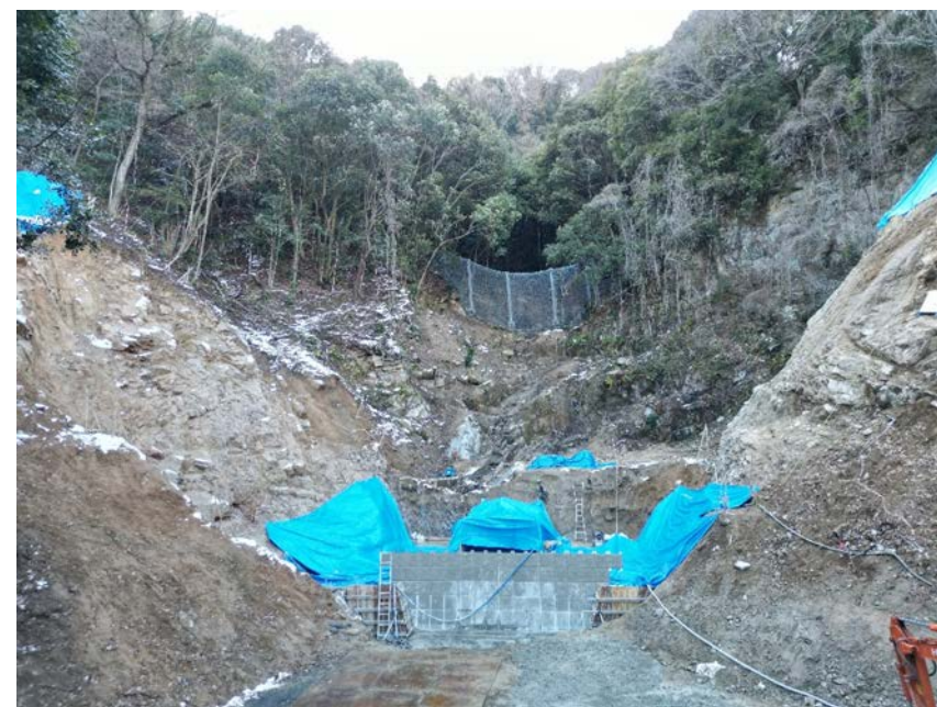
【施工箇所（下流側より）】
