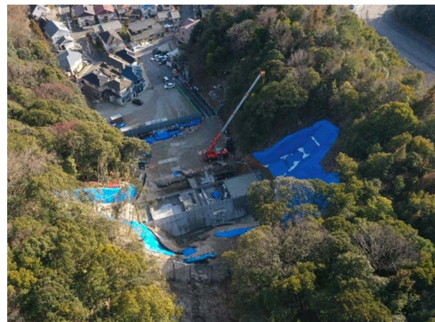
【施工状況（上流側より）】
