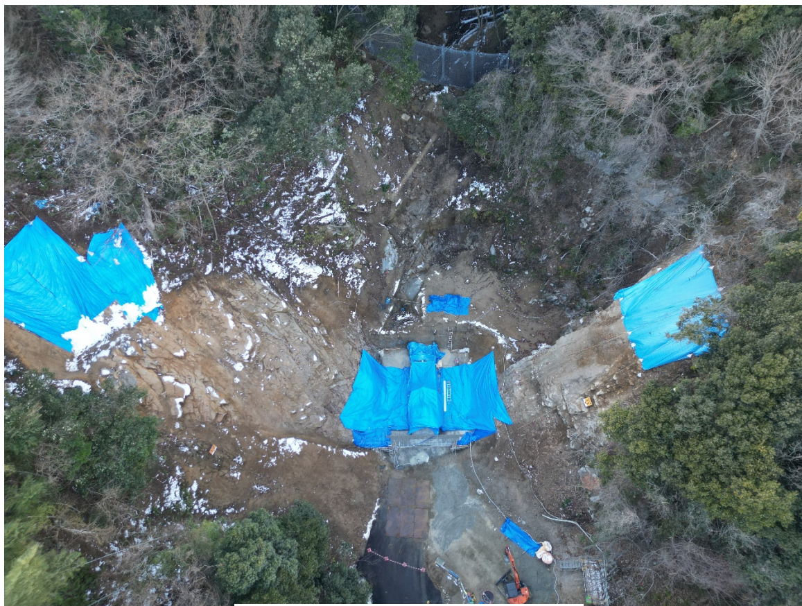
【施工状況（上空より）】
