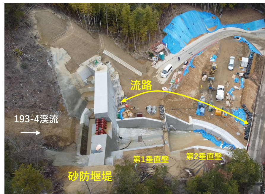
【施工状況(砂防堰堤、第1、2垂直壁)】
