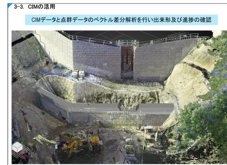
CIMによる出来形確認紹介(施工業者)
