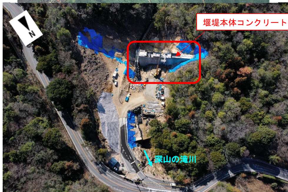
【深山の滝川溪流下流の施工状況】
