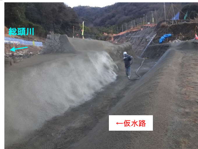
【仮水路設置状況】
