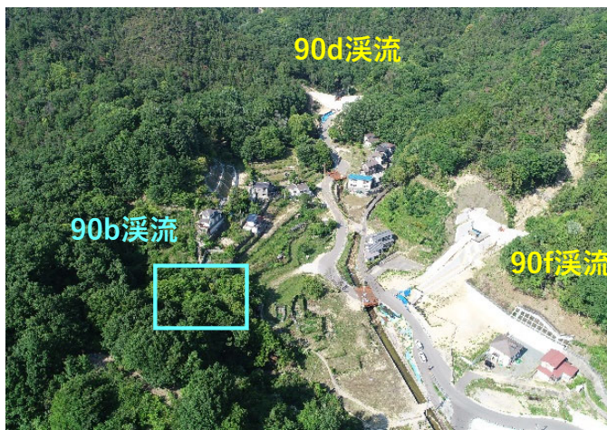
【砂防堰堤全景（90b,90d,90f溪流）】
