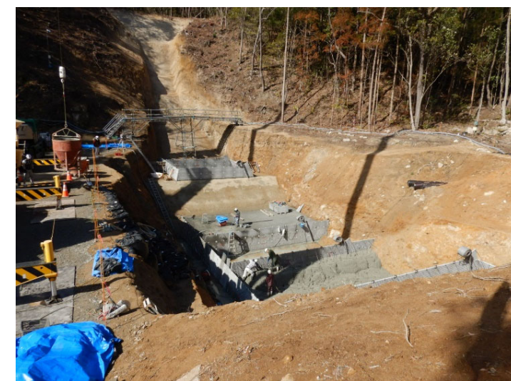
【コンクリート打設状況】
