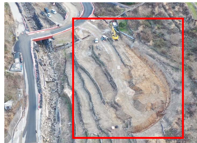
【工事用道路範囲の土砂掘削実施】
