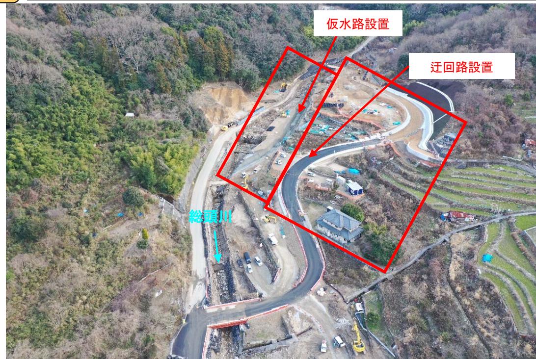
【施工状況（下流から上流を望む）（R5. 2月末時点）】
