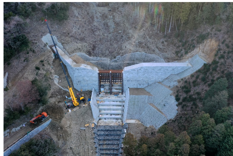
【上原1号砂防堰堤 施工状況 (埋戻し)】
