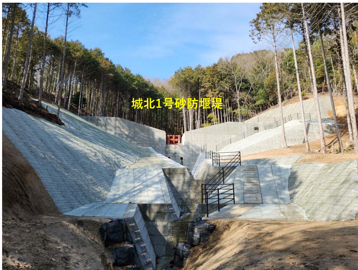
【城北1号砂防堰堤 完成】
