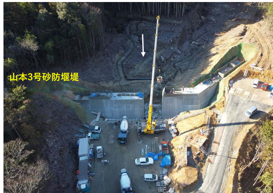
【施工状況 (砂防堰堤)】
