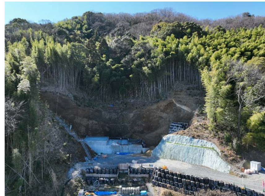
【施工状況（下流側より）】
