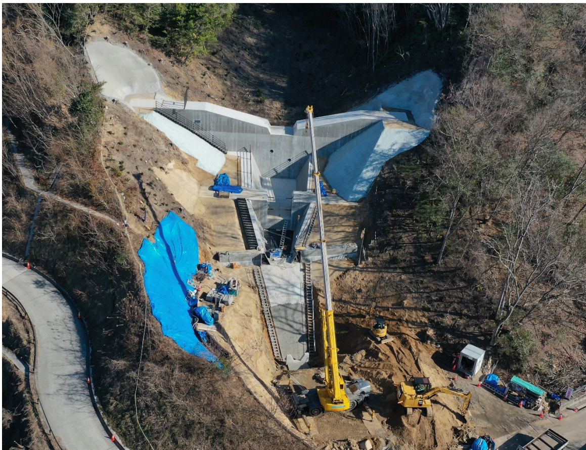
【五月が丘8号砂防堰堤 施工状況】
