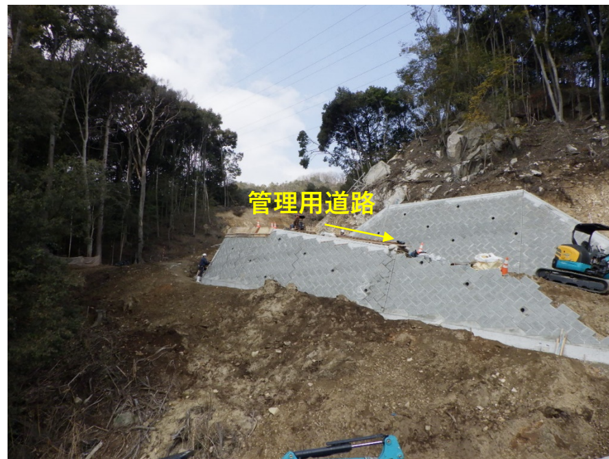
【施工状況 (管理用道路)】
